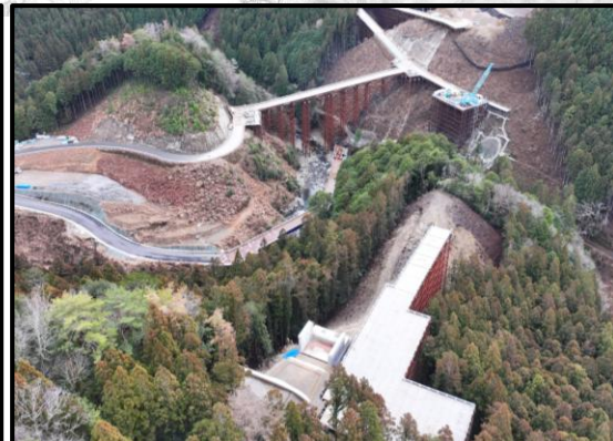
瀬戸設楽線2号トンネルから3号橋
