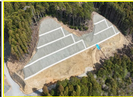
①田口地区道路建設
