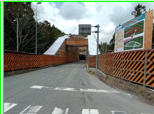
②設楽大橋塗替工事
