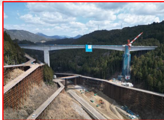
③5号橋PC上部工
