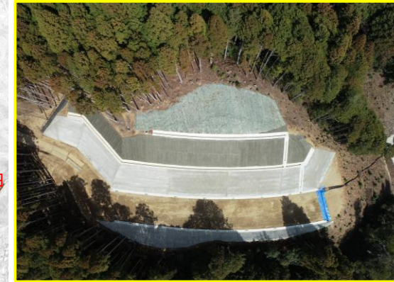
④川向地区道路建設
