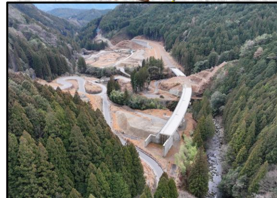
瀬戸設楽線1号橋から1号トンネル
