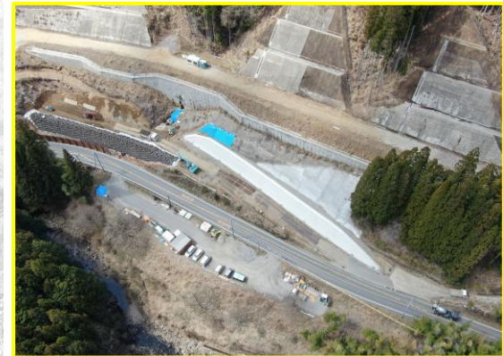
④八橋地区北部道路建設
