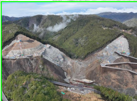
①本体建設第1期(上流側より)
