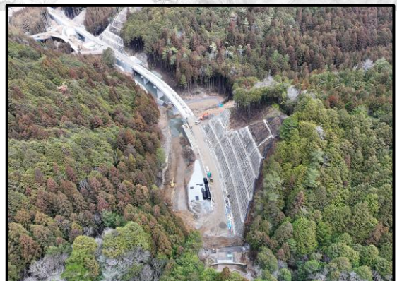
設楽根羽線1号トンネルから4号橋
