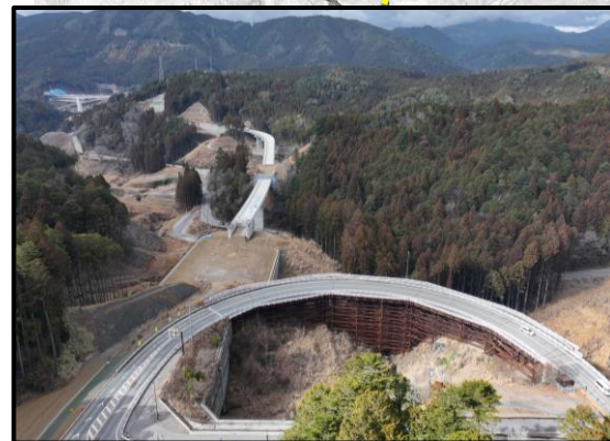
257号起点から設楽大橋
