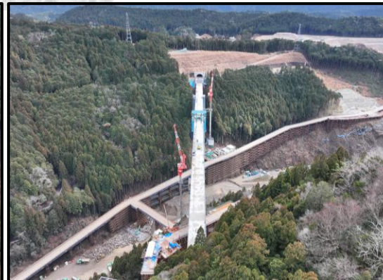
瀬戸設楽線5号橋から4号トンネル
