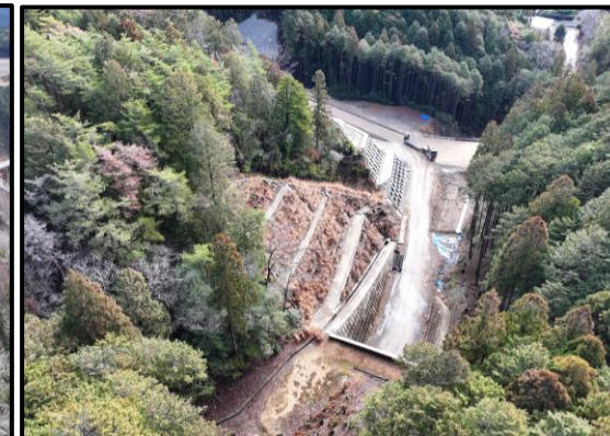
5号トンネルから国道257号
