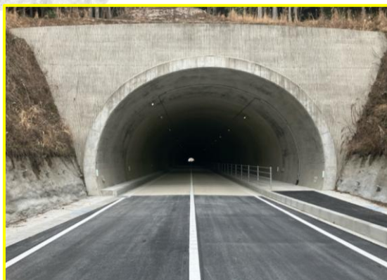
①小松地区舗装工事
