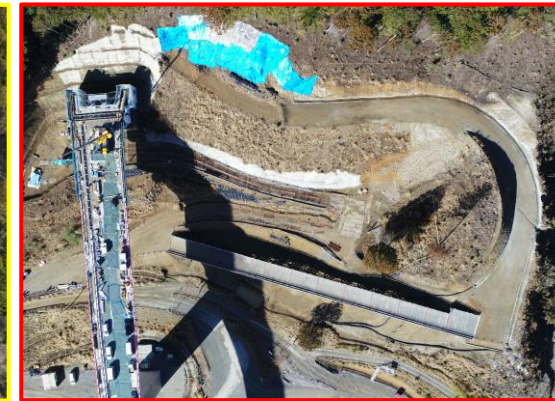
② 4号橋下部工 (A2橋台)
