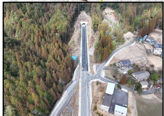
設楽根羽土工3工区から1号トンネル
