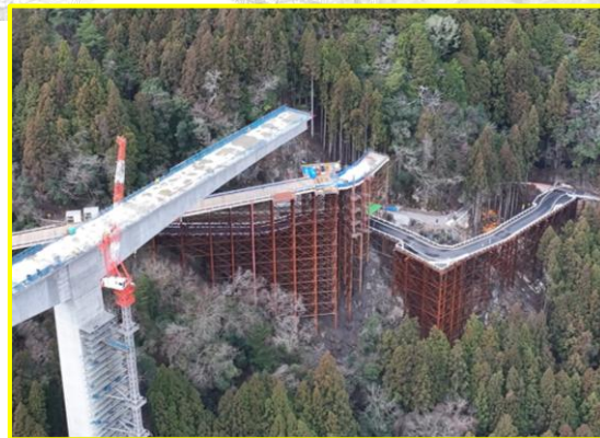
②松戸地区道路建設
