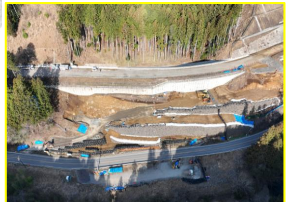
③八橋地区南部道路建設
