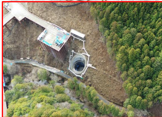
①R6・3号橋下部工
