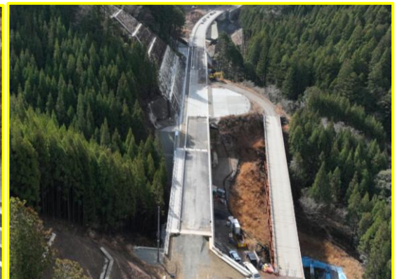
②長江地区道路建設
