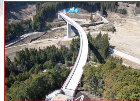
③ 4号橋PC上部工
