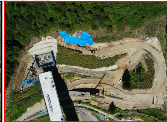
①4号橋下部工(A2橋台)
