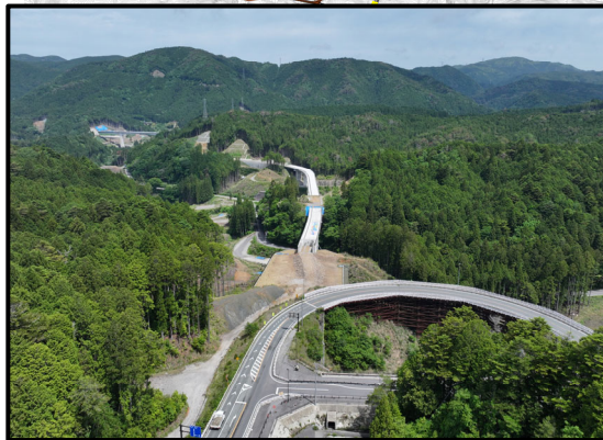
257号起点から設楽大橋
