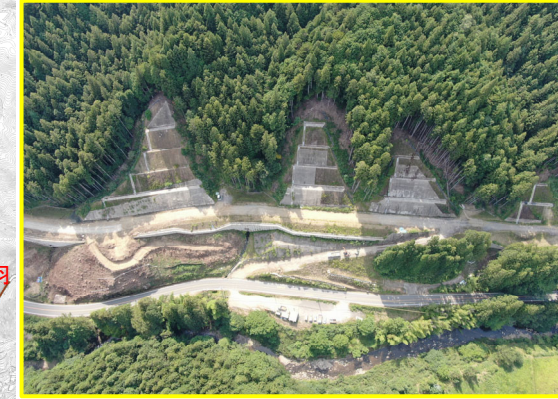
④八橋地区北部道路建設
