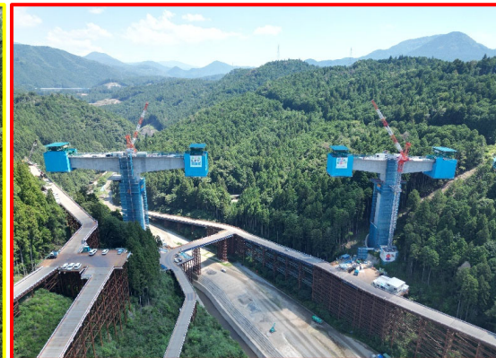
⑤5号橋PC上部工
