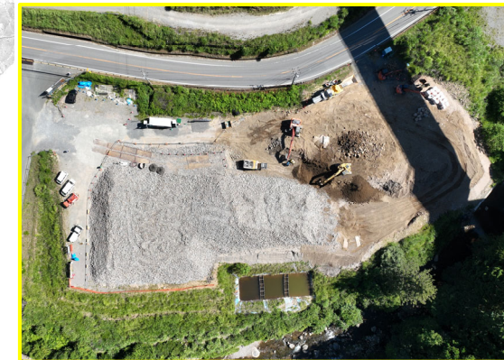
③八橋地区南部道路建設
