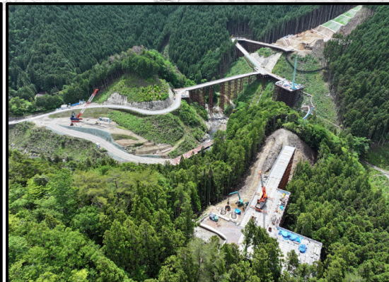
瀬戸設楽線2号トンネルから4号橋
