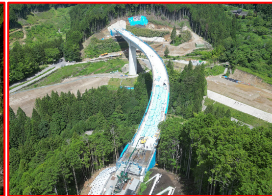
②4号橋PC上部工
