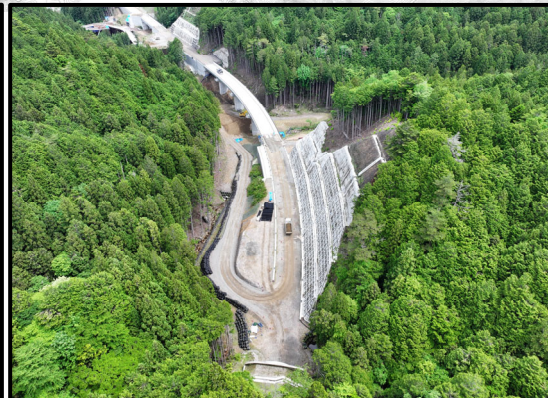
設楽根羽線1号トンネルから4号橋
