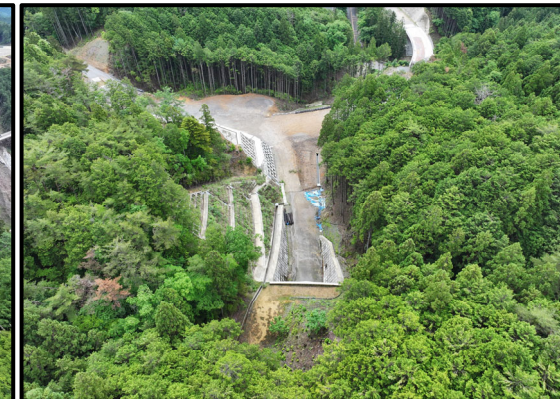
5号トンネルから国道257号
