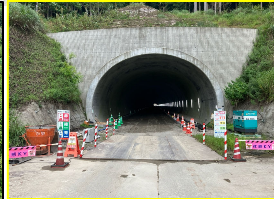
①小松地区舗装
