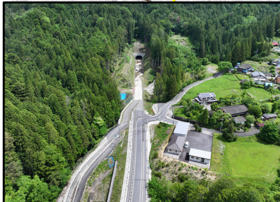
設楽根羽土工3工区から1号トンネル
