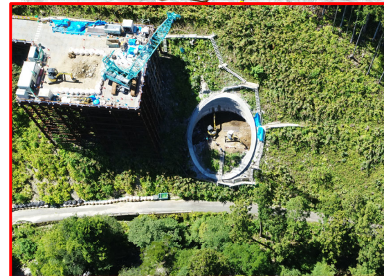
②R6・3号橋下部工
