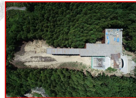
①R5・3号橋下部工
