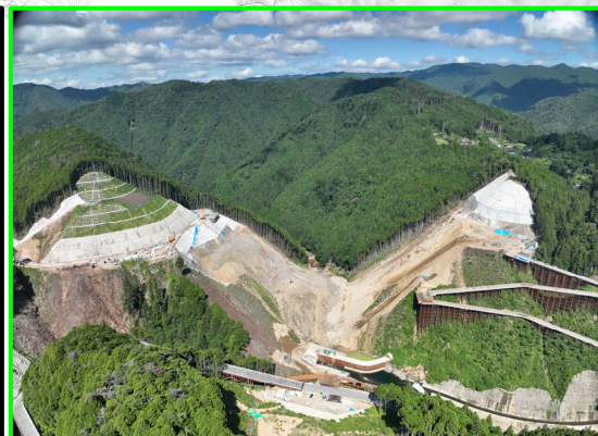
①本体建設第1期(上流側より)
