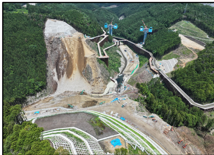
① 左岸頂部より
