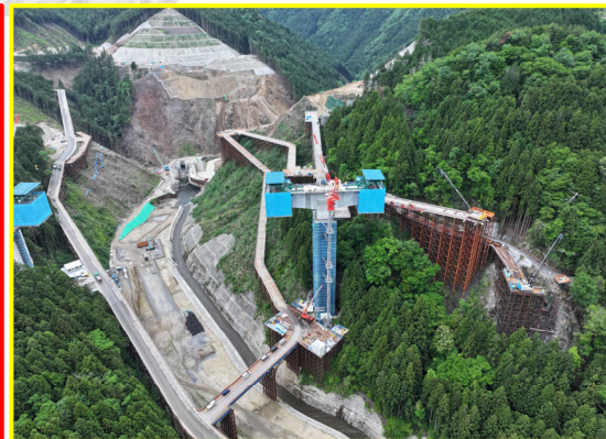
④松戸地区道路建設
