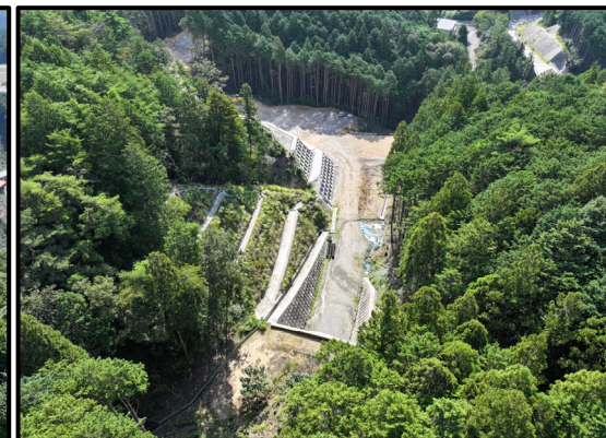
5号トンネルから国道257号
