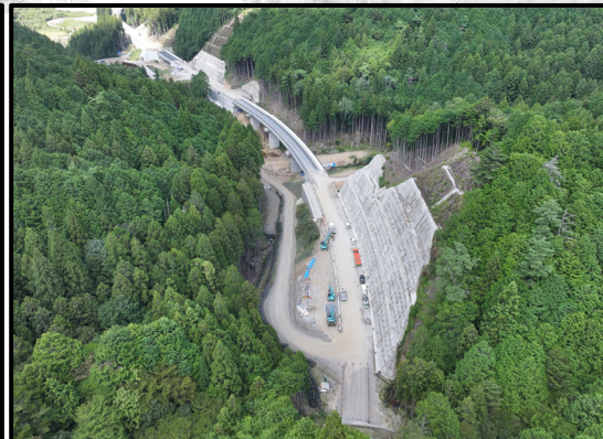
設楽根羽線1号トンネルから4号橋
