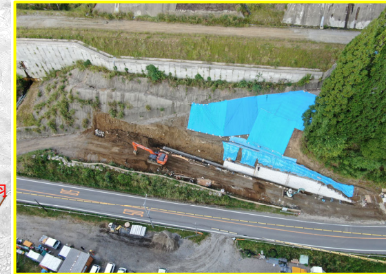
④八橋地区北部道路建設
