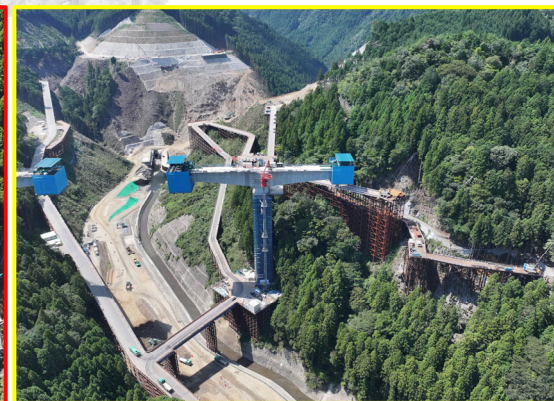
④松戸地区道路建設
