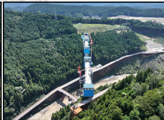
瀬戸設楽線5号橋から5号トンネル
