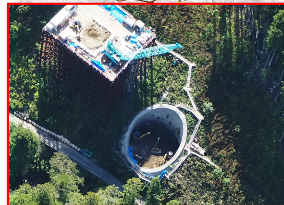
②R6・3号橋下部工
