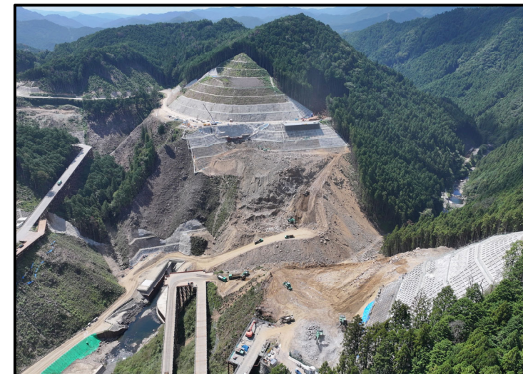
③ 右岸頂部より
