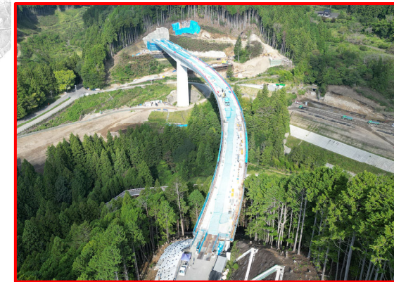
③ 4号橋PC上部工
