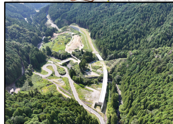
瀬戸設楽線1号橋から1号トンネル
