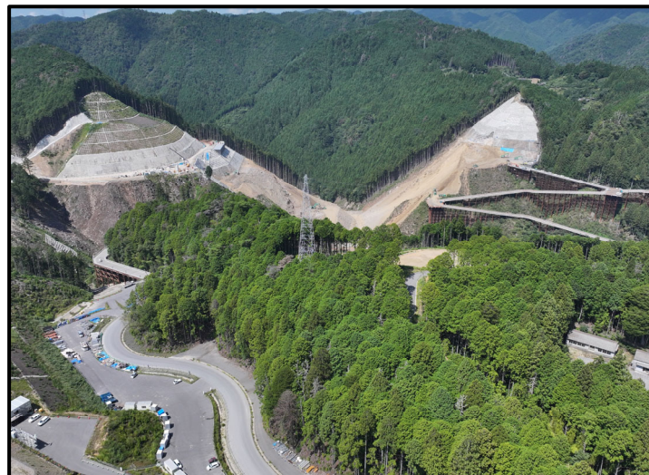
② 上流側より
