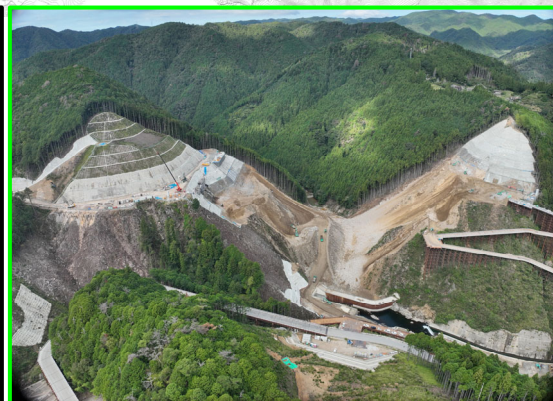
①本体建設第1期(上流側より)
