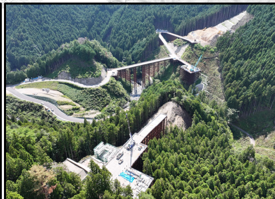
瀬戸設楽線2号トンネルから4号橋
