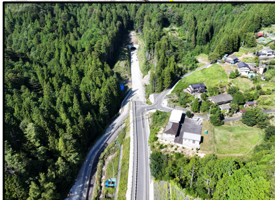
設楽根羽土工3工区から1号トンネル
