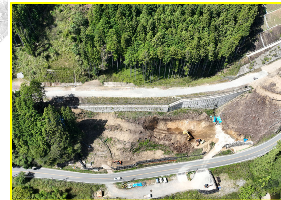
③八橋地区南部道路建設
