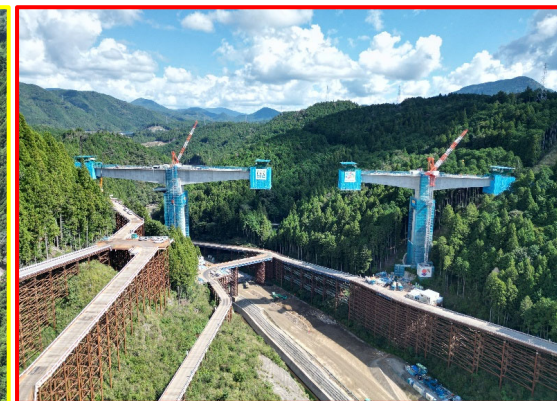
⑤5号橋PC上部工
