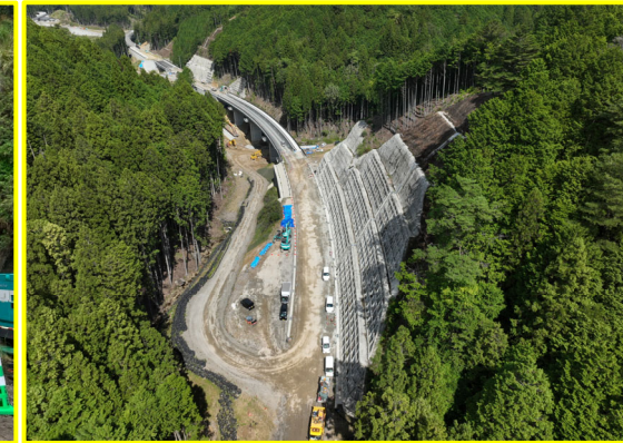
②長江地区道路建設
