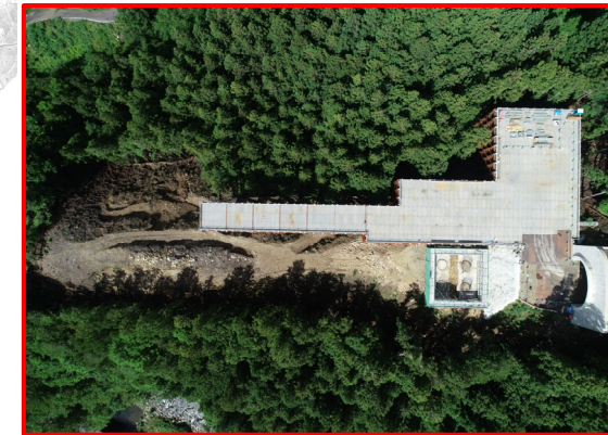
①R5・3号橋下部工
