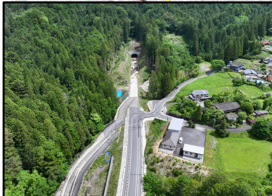
設楽根羽土工3工区から1号トンネル
