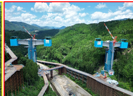
⑤5号橋PC上部工
