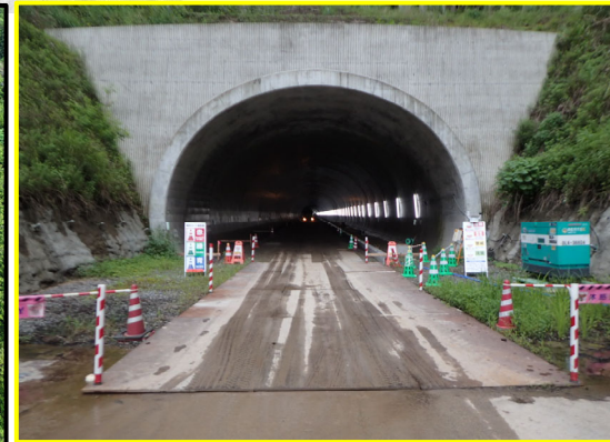
①小松地区舗装
