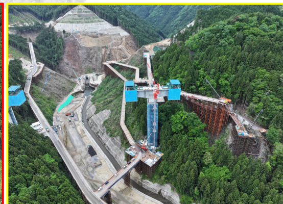
④松戸地区道路建設
