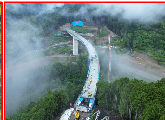
②4号橋PC上部工
