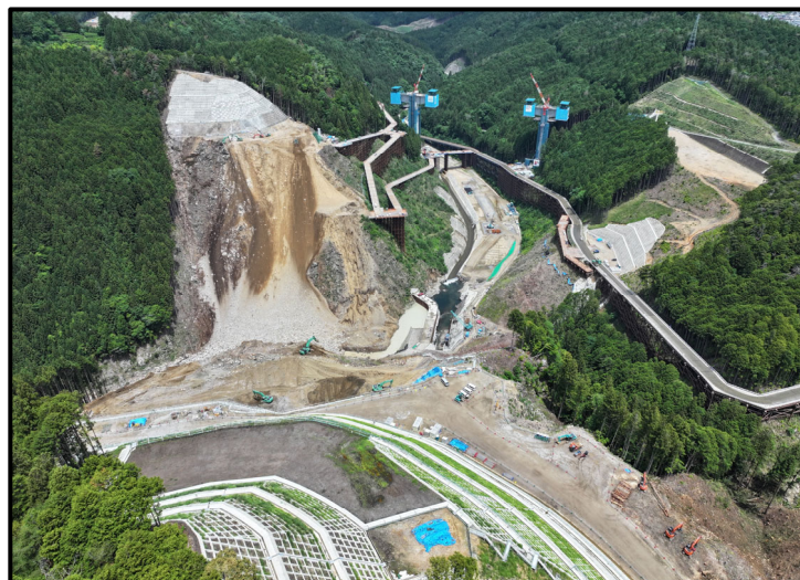
① 左岸頂部より
