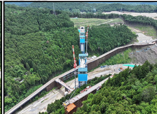
瀬戸設楽線5号橋から5号トンネル
