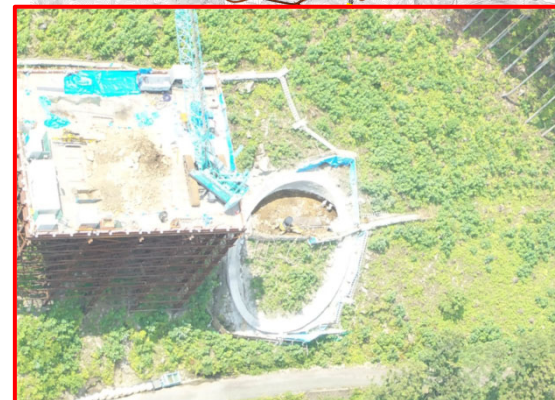
②R6・3号橋下部工
