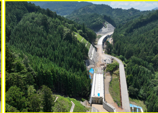
②長江地区道路建設
