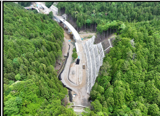
設楽根羽線1号トンネルから4号橋
