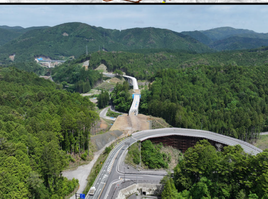
257号起点から設楽大橋
