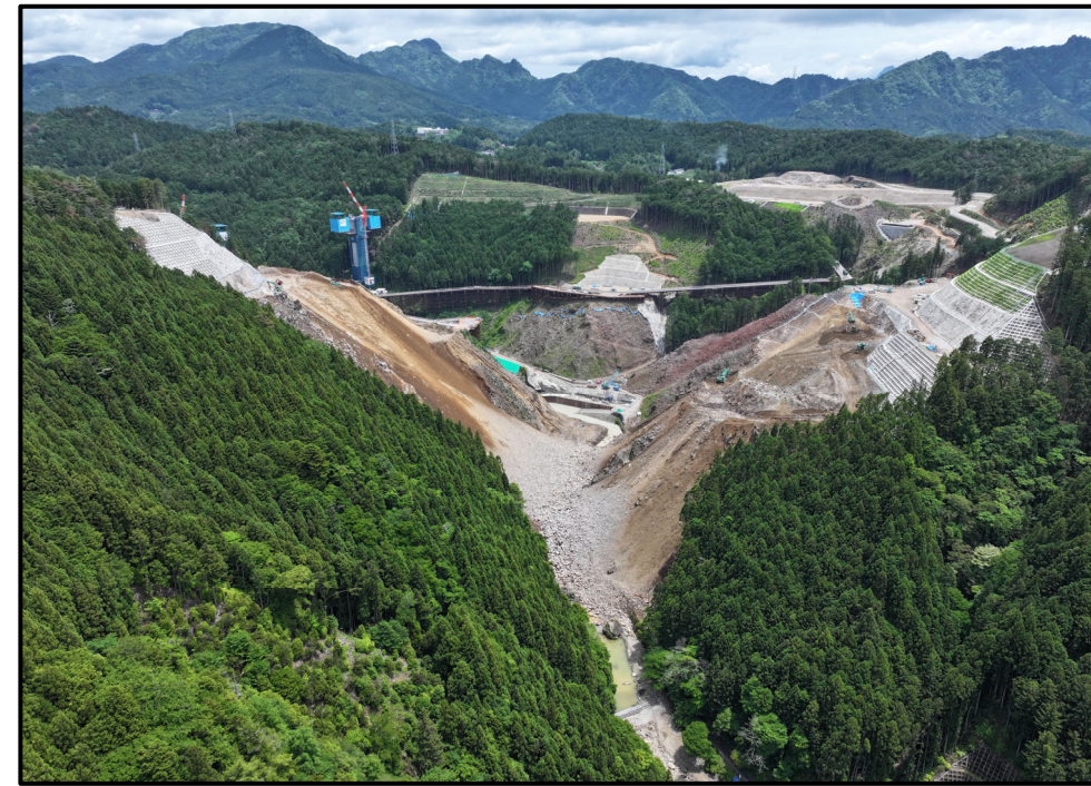
④ 下流側より
