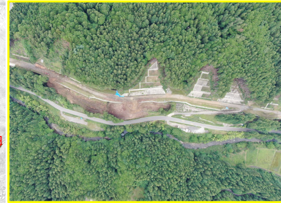
④八橋地区北部道路建設
