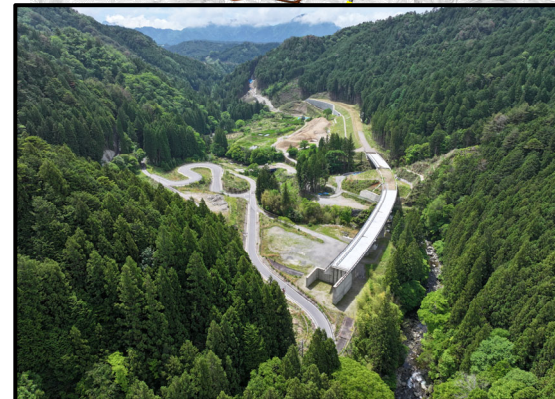
瀬戸設楽線1号橋から1号トンネル
