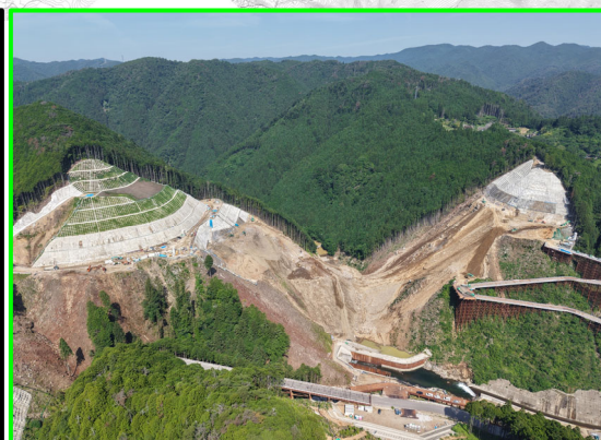
①本体建設第1期(上流側より)
