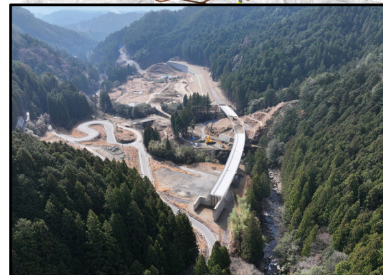
瀬戸設楽線1号橋から1号トンネル
