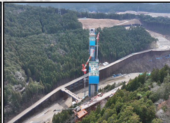
瀬戸設楽線5号橋から5号トンネル
