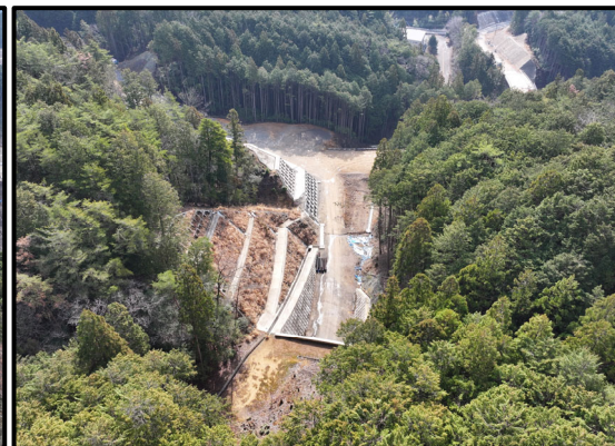
5号トンネルから国道257号
