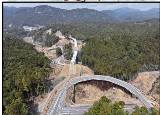
257号起点から設楽大橋
