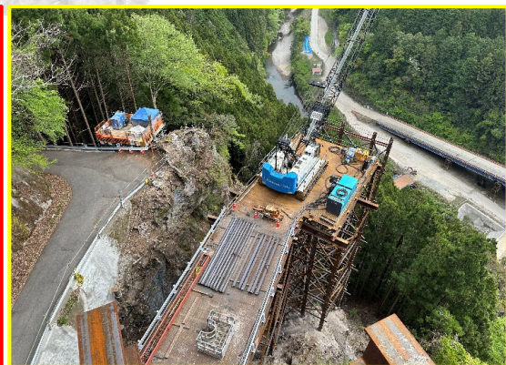
④松戸地区道路建設
