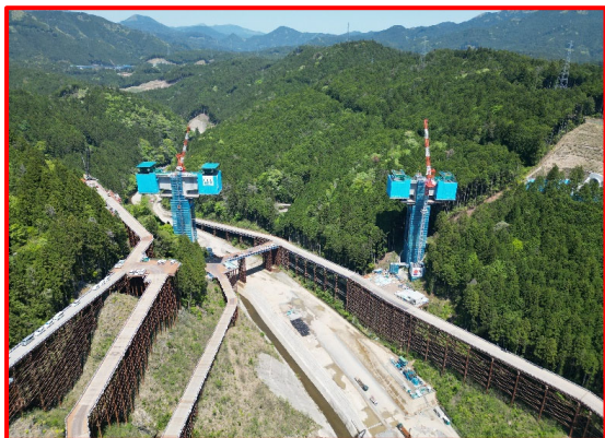
⑤5号橋PC上部工
