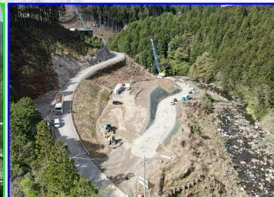
②松戸地区貯水池斜面对策工事用進入路
