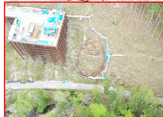
②R6・3号橋下部工
