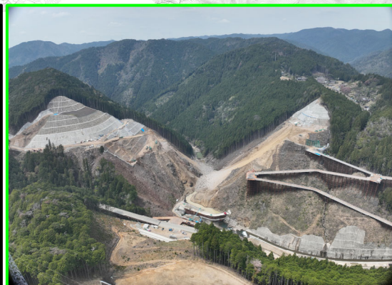
①本体建設第1期(上流側より)
