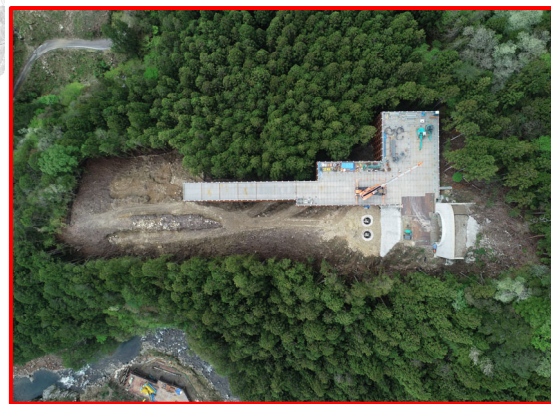
①R5・3号橋下部工
