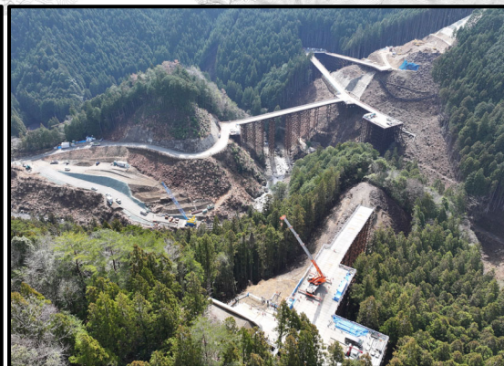
瀬戸設楽線2号トンネルから4号橋
