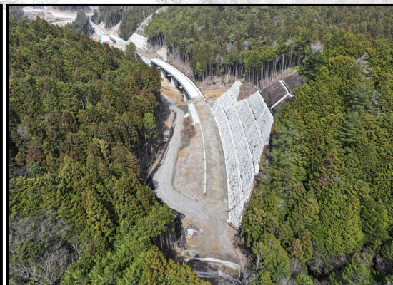
設楽根羽線1号トンネルから4号橋
