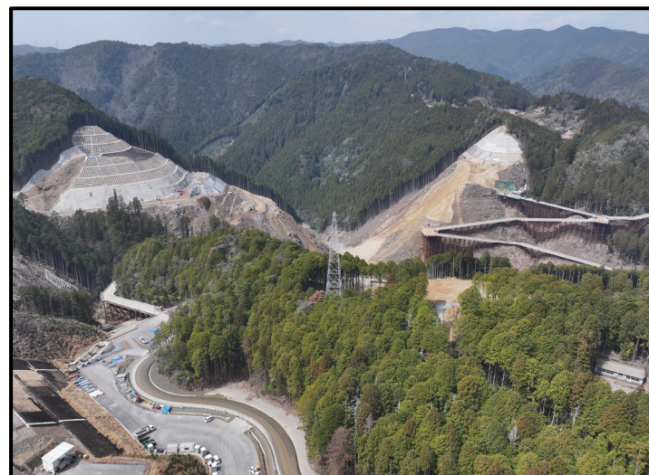
② 上流側より
