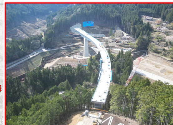
③4号橋PC上部工
