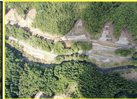
①八橋地区北部道路建設
