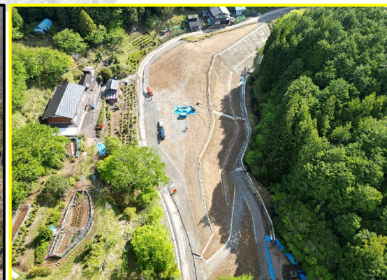
①小松地区道路建設(小松工区)
