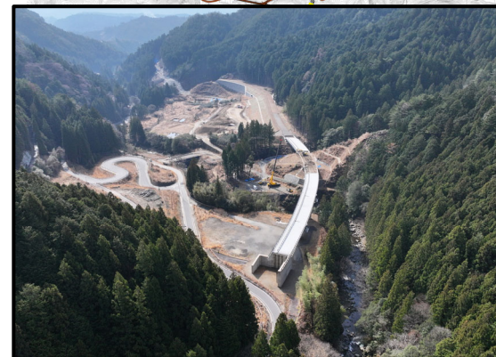
瀬戸設楽線1号橋から1号トンネル
