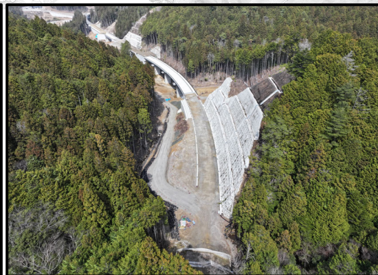
設楽根羽線1号トンネルから4号橋
