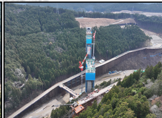
瀬戸設楽線5号橋から5号トンネル
