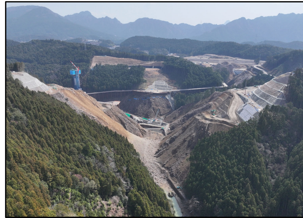
④ 下流側より
