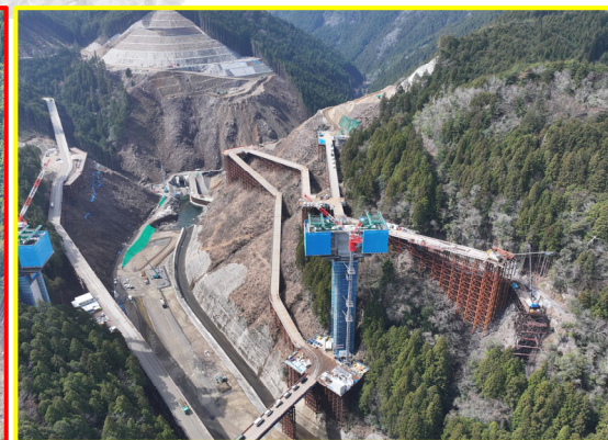
④松戸地区道路建設
