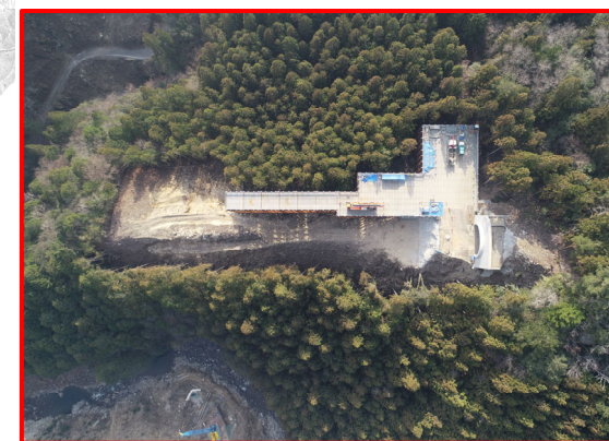
①R5・3号橋下部工
