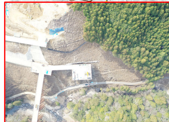
②R6・3号橋下部工
