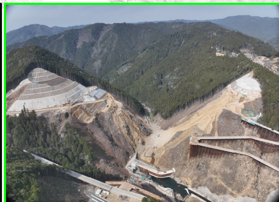
①本体建設第1期(上流側より)
