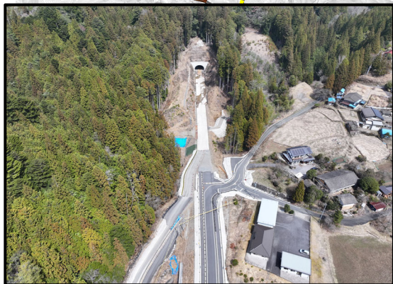
設楽根羽土工3工区から1号トンネル
