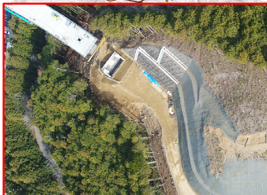
②4号橋下部工(A1橋台)
