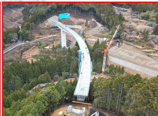
③4号橋PC上部工
