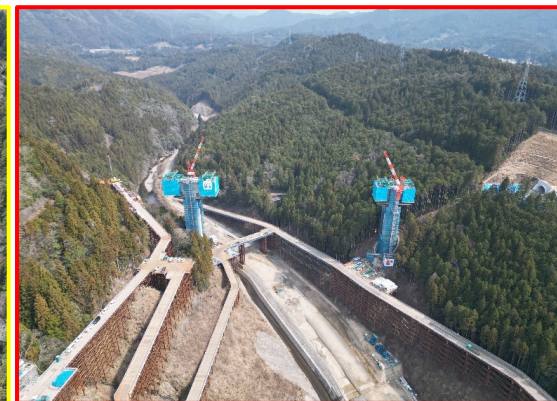
⑤5号橋PC上部工
