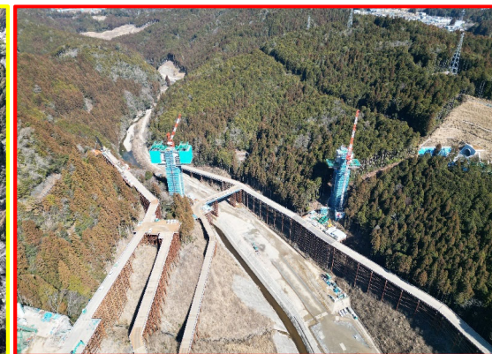
⑤5号橋PC上部工
