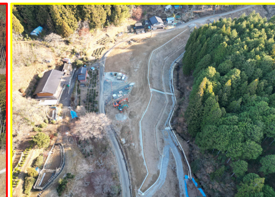
②小松地区道路建設(小松工区)
