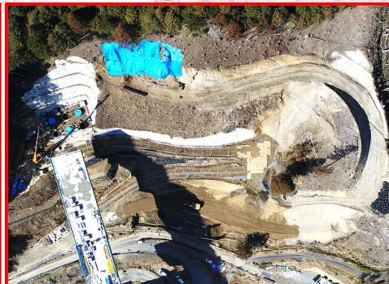
③4号橋下部工(A2橋台)
