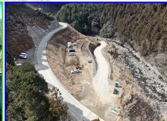
②松戸地区貯水池斜面对策工事用進入路
