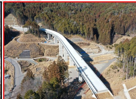
①2号橋床版工
