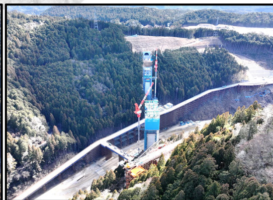
瀬戸設楽線5号橋から5号トンネル
