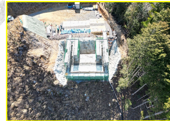
②小松地区道路建設(A1橋台)
