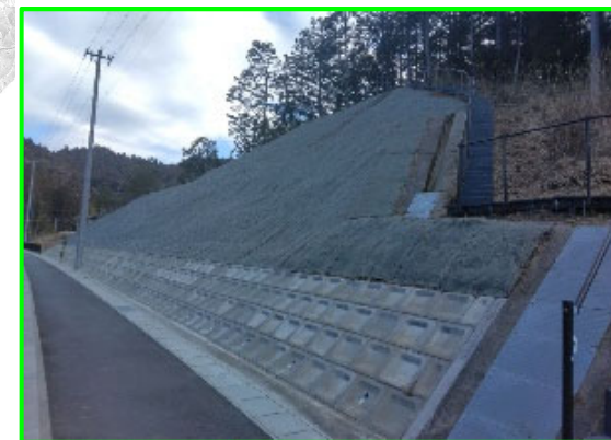
④貯水池東部整備(法面工)
