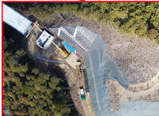
③4号橋下部工(A1橋台)
