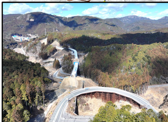
257号起点から設楽大橋
