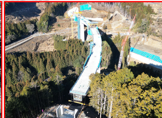
④4号橋PC上部工
