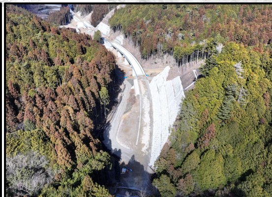
設楽根羽線1号トンネルから4号橋
