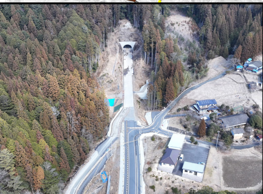
設楽根羽土工3工区から1号トンネル
