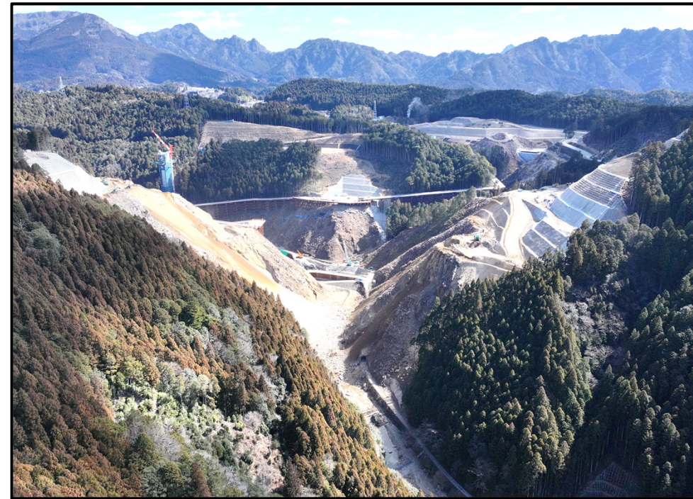
④ 下流側より
