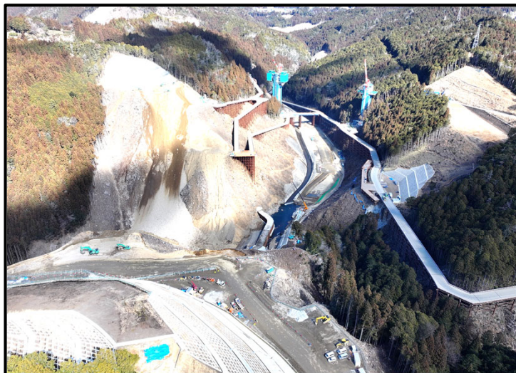
① 左岸頂部より
