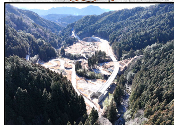
瀬戸設楽線1号橋から1号トンネル
