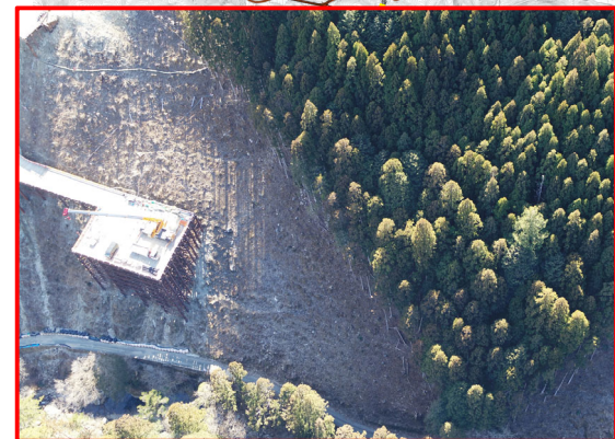
②R6・3号橋下部工
