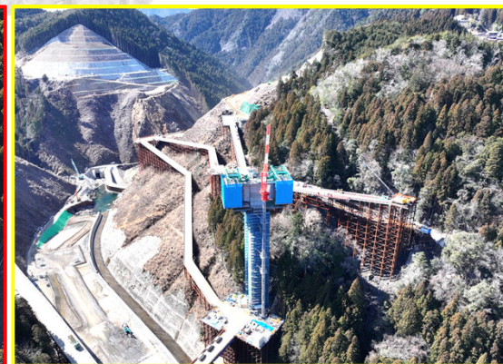
④松戸地区道路建設
