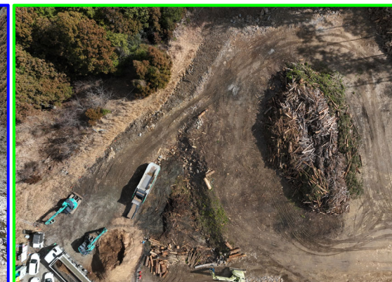
③添沢地区整備(大畑工区)
