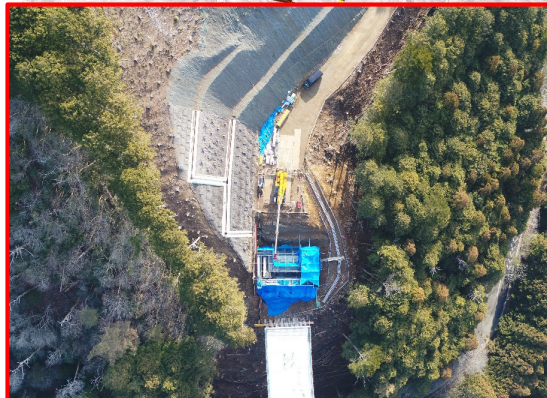
③4号橋下部工A1橋台
