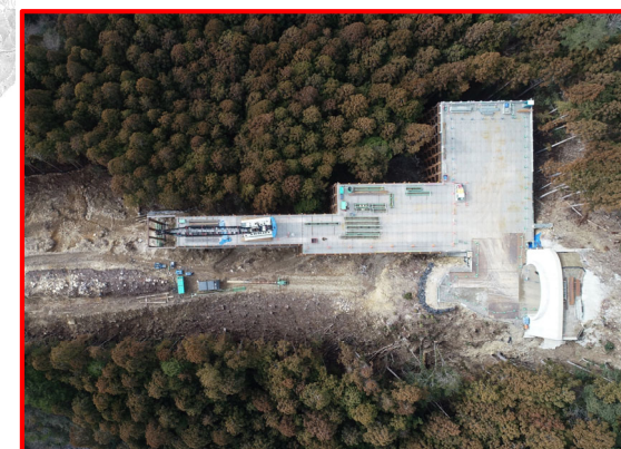
②R5・3号橋下部工
