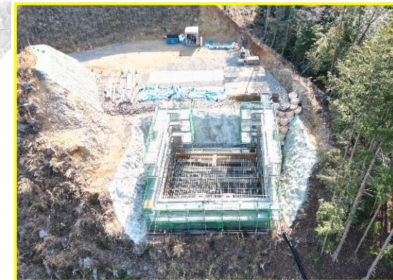
②小松地区道路建設(A1橋台)
