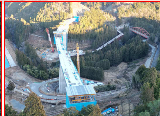
④4号橋PC上部工
