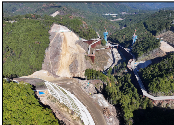
① 左岸頂部より
