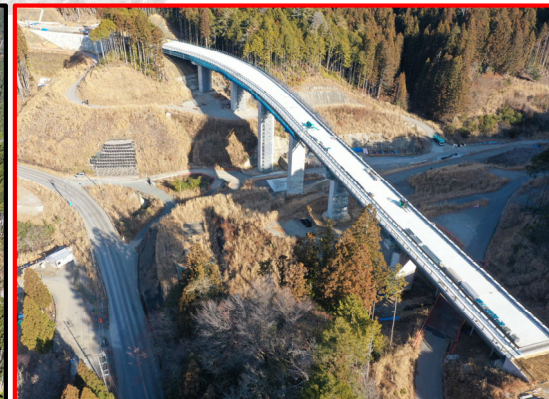
①2号橋床版工
