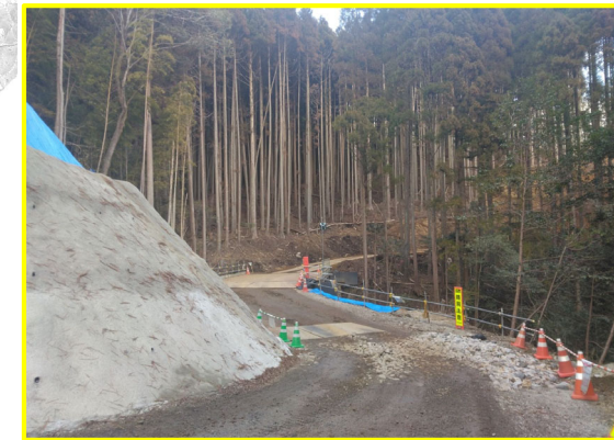
⑤川向地区道路建設
