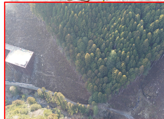
③R6・3号橋下部工
