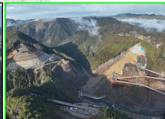
①本体建設第1期(上流側より)
