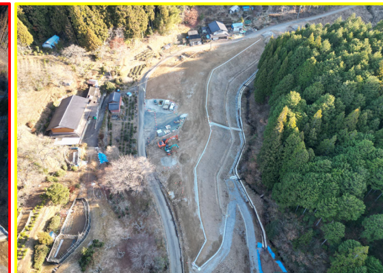
②小松地区道路建設(小松工区)
