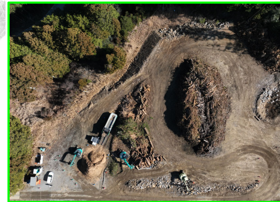
③添沢地区整備(大畑工区)
