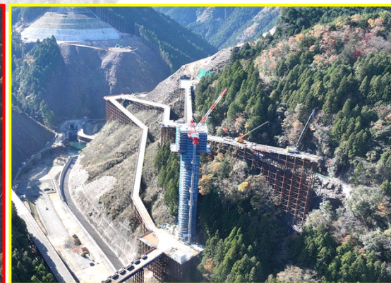
⑤松戸地区道路建設
