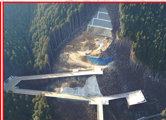
④松戸地区橋梁下部工
