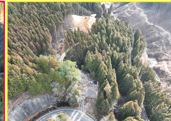
⑤川向地区道路建設
