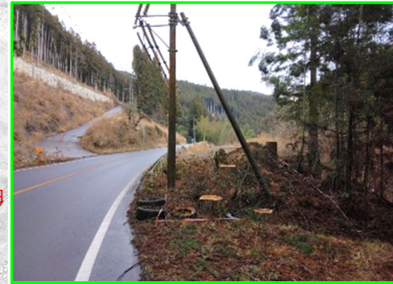
④貯水池東部整備(八橋工区)
