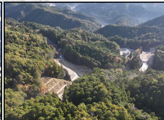
5号トンネルから国道257号
