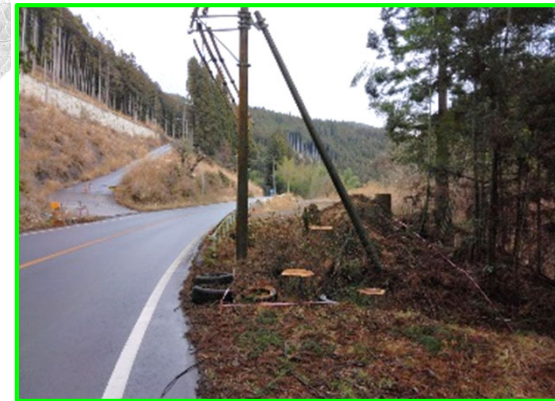
③貯水池東部整備(八橋工区)
