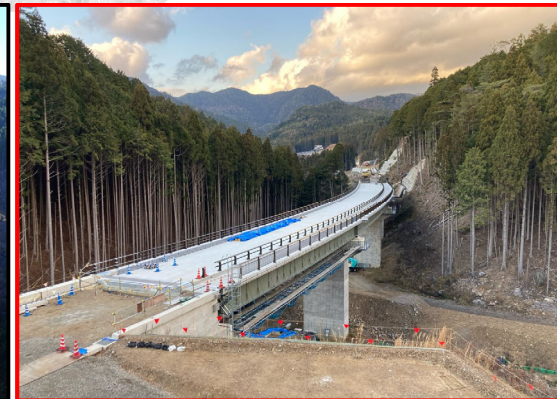
①3号橋床版工
