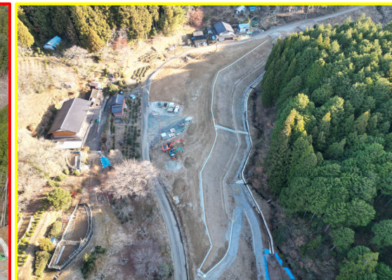
②小松地区道路建設(小松工区)
