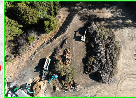
④添沢地区整備(大畑工区)
