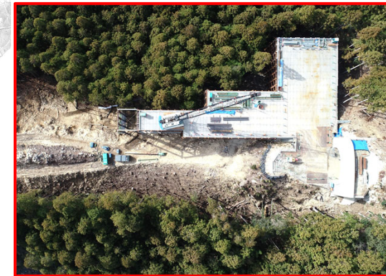
②R5・3号橋下部工
