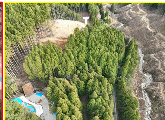
⑤川向地区道路建設
