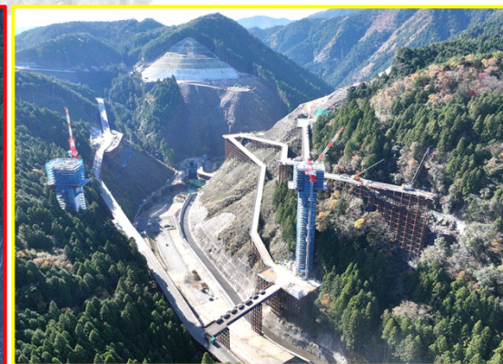
⑤松戸地区道路建設
