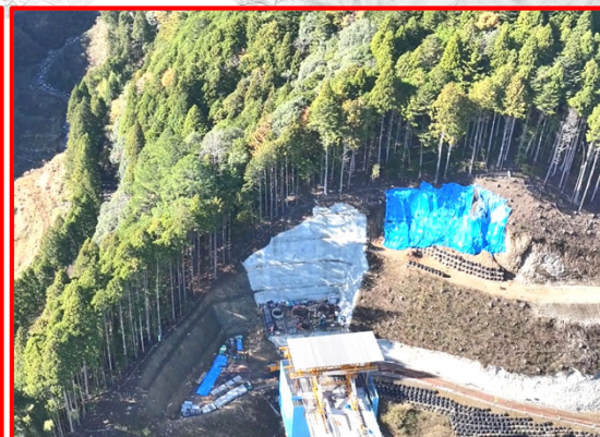
③4号橋下部工A2橋台
