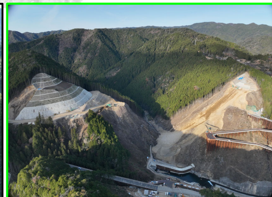
①本体建設第1期(上流側より)
