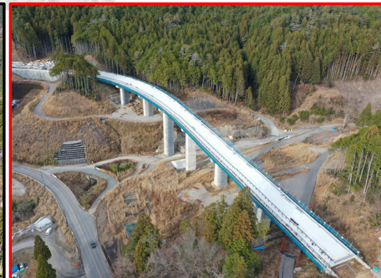
①2号橋床版工
