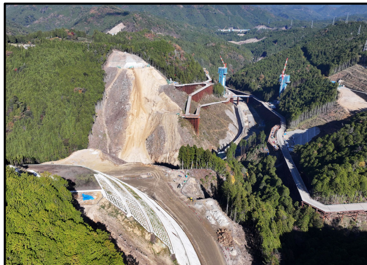
① 左岸頂部より
