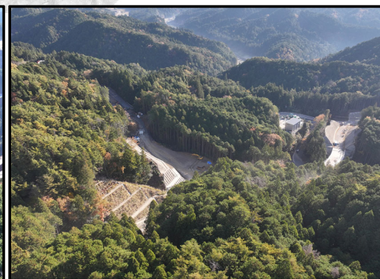
5号トンネルから国道257号
