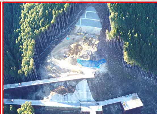
④松戸地区橋梁下部工
