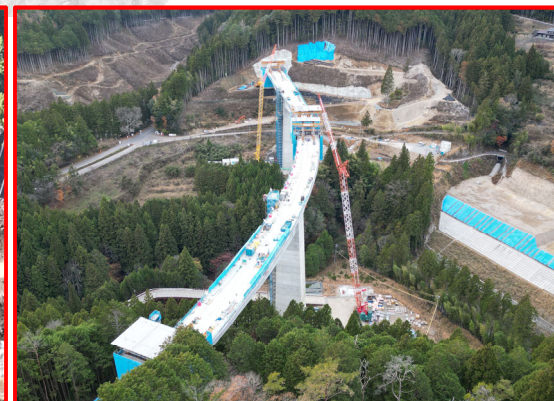
④4号橋PC上部工
