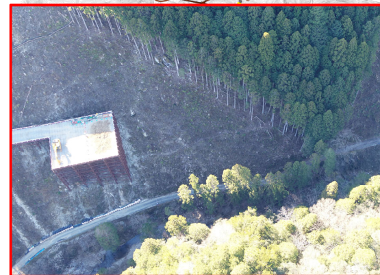
③R6・3号橋下部工
