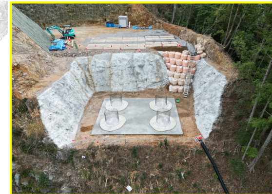
②小松地区道路建設(A1橋台)
