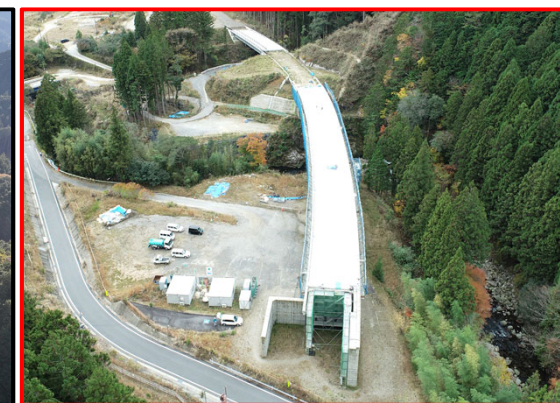
①大名倉地区床版工 (1号橋から2号橋)
