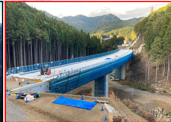
①3号橋床版工
