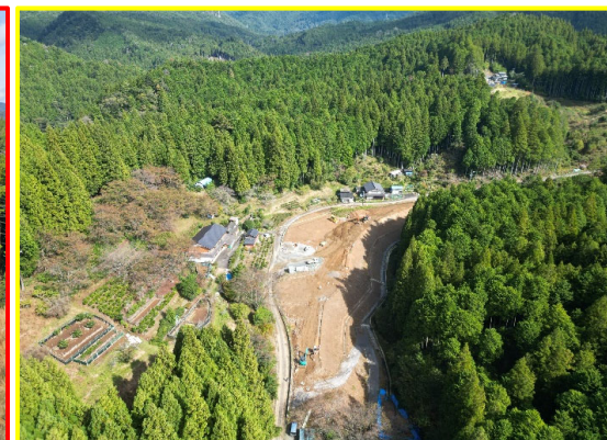
②小松地区道路建設
