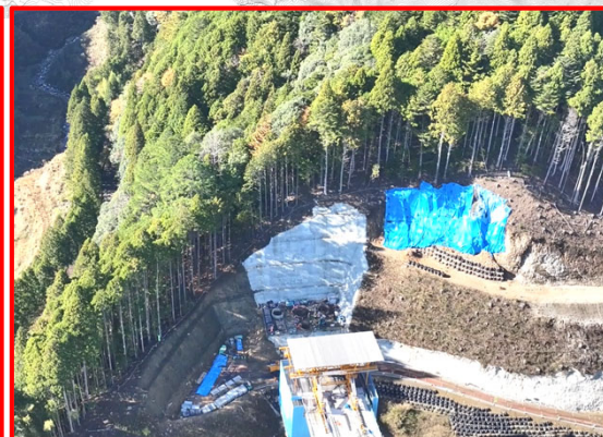
③4号橋下部工A2橋台
