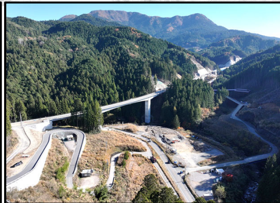
設楽根羽線5号橋から1号トンネル
