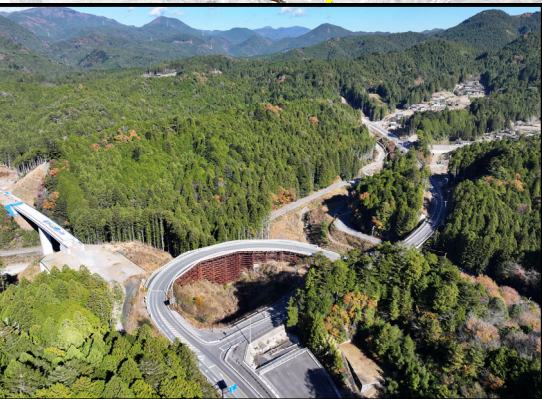
設楽根羽線起点から1号トンネル
