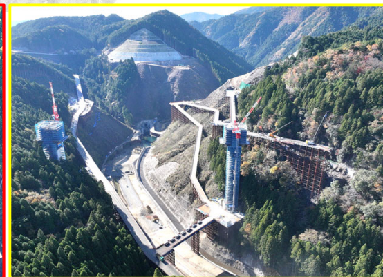
⑤松戸地区道路建設
