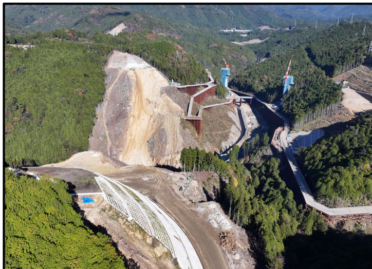
① 左岸頂部より
