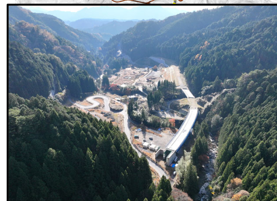
瀬戸設楽線1号橋から1号トンネル
