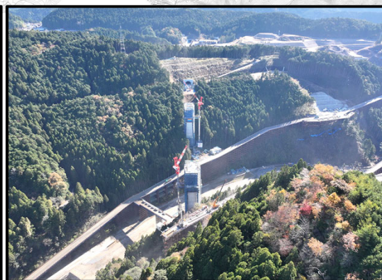
瀬戸設楽線5号橋から5号トンネル
