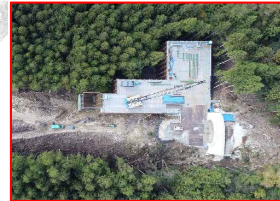
②R5・3号橋下部工
