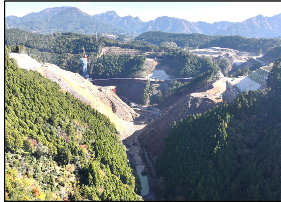
④ 下流側より
