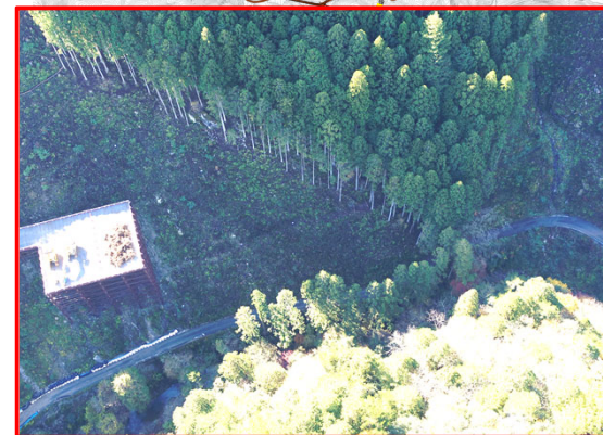
③R6・3号橋下部工
