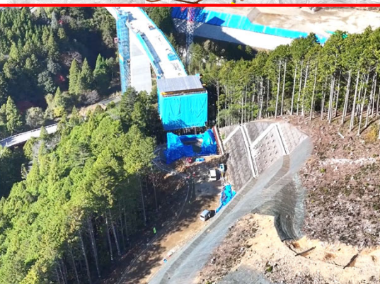
③4号橋下部工A1橋台
