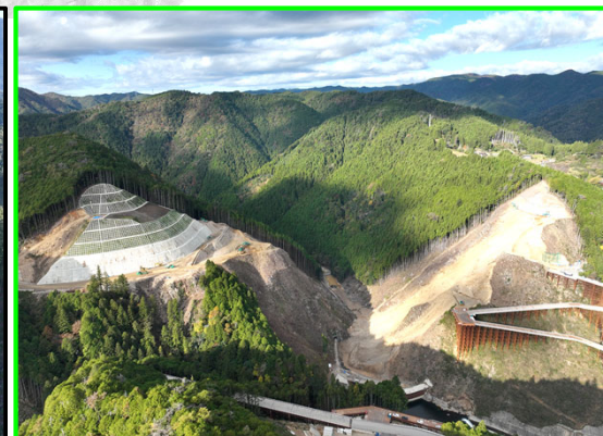
①本体建設第1期(上流側より)
