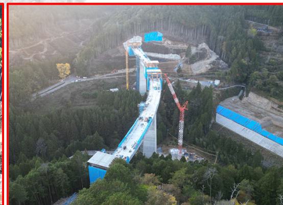
④4号橋PC上部工
