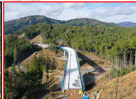
①2号橋床版工
