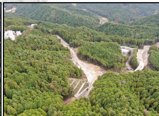
5号トンネルから国道257号
