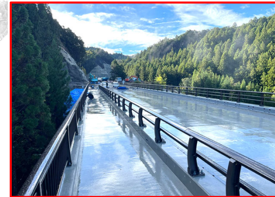
③4号橋PC上部工
