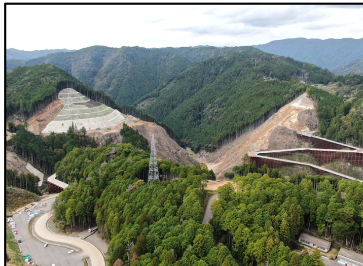
② 上流側より
