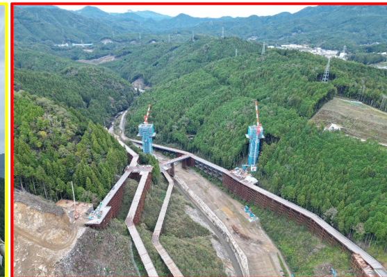
⑤5号橋PC上部工
