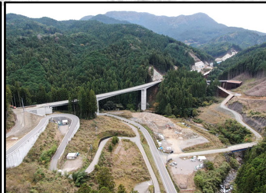
設楽根羽線5号橋から1号トンネル
