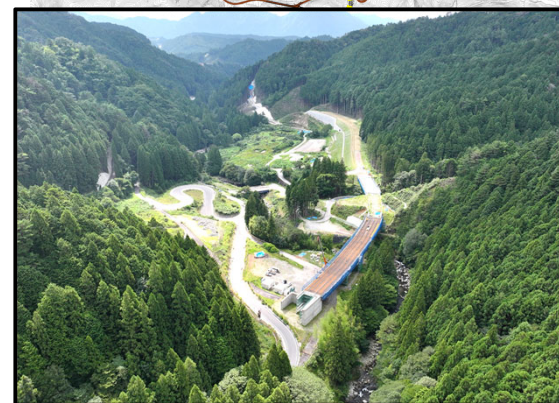
瀬戸設楽線1号橋から1号トンネル
