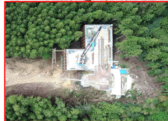
②3号橋下部工
