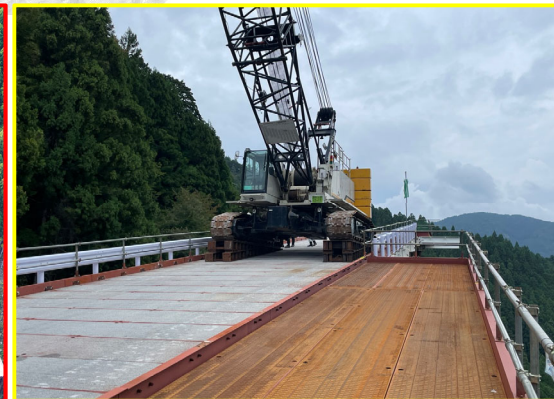
④松戸地区道路建設
