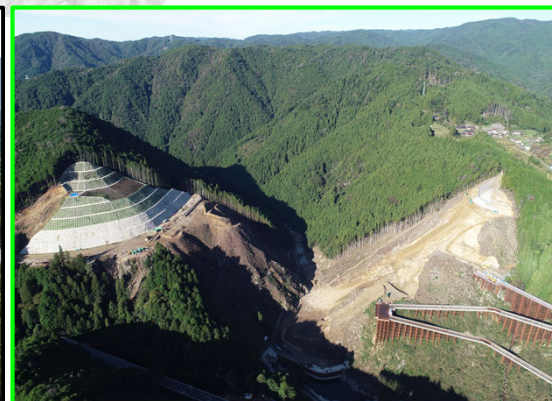
①本体建設第1期(上流側より)
