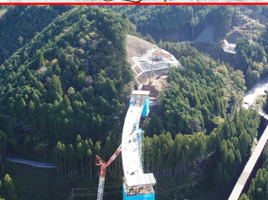
③4号橋下部工A1橋台
