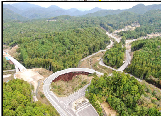
設楽根羽線起点から1号トンネル
