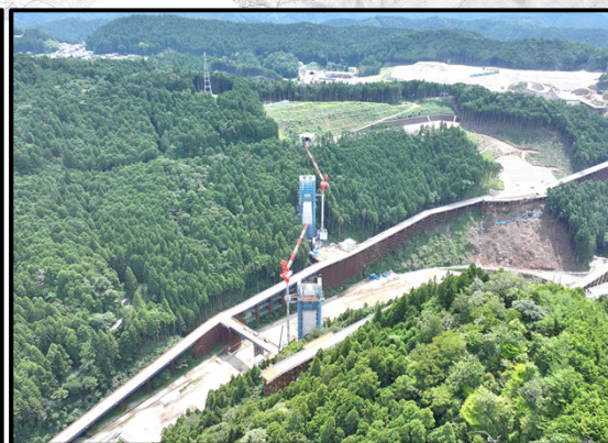
瀬戸設楽線5号橋から5号トンネル
