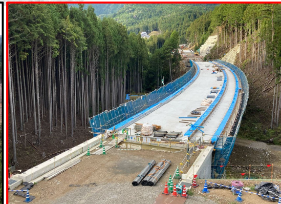
①3号橋床版工
