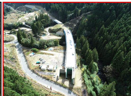
①大名倉地区床版工 (1号橋から2号橋)
