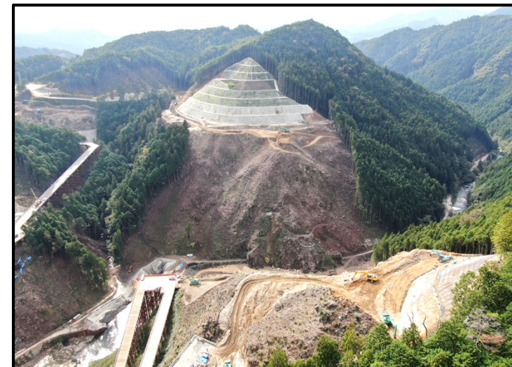
③ 右岸頂部より
