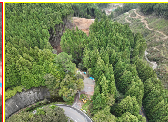
⑤川向地区道路建設
