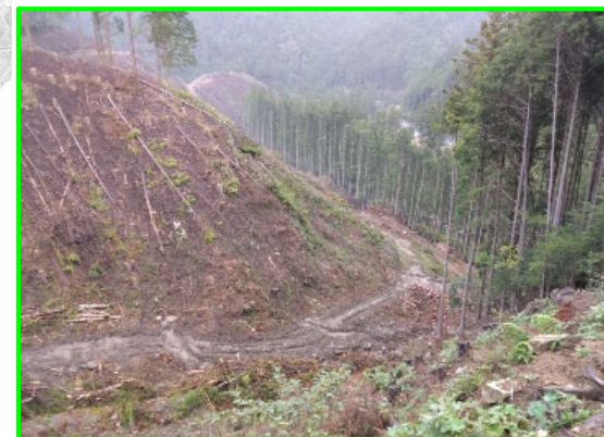
③貯水池東部整備(田口工区)
