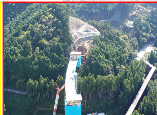
④4号橋下部工A1橋台
