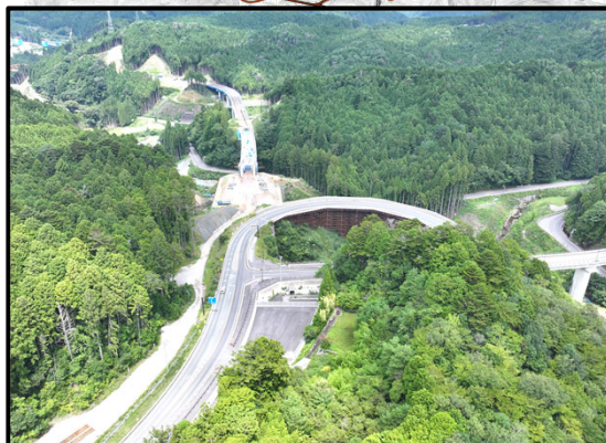
257号起点から設楽大橋
