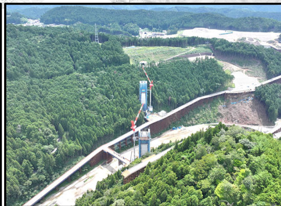
瀬戸設楽線5号橋から5号トンネル
