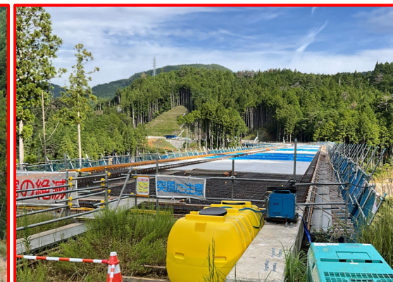
②2号橋床版工
