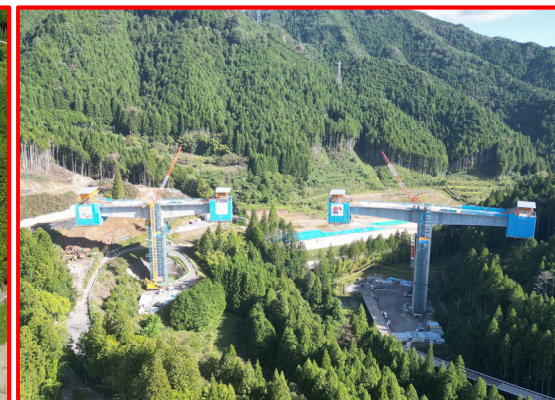
⑤4号橋PC上部工
