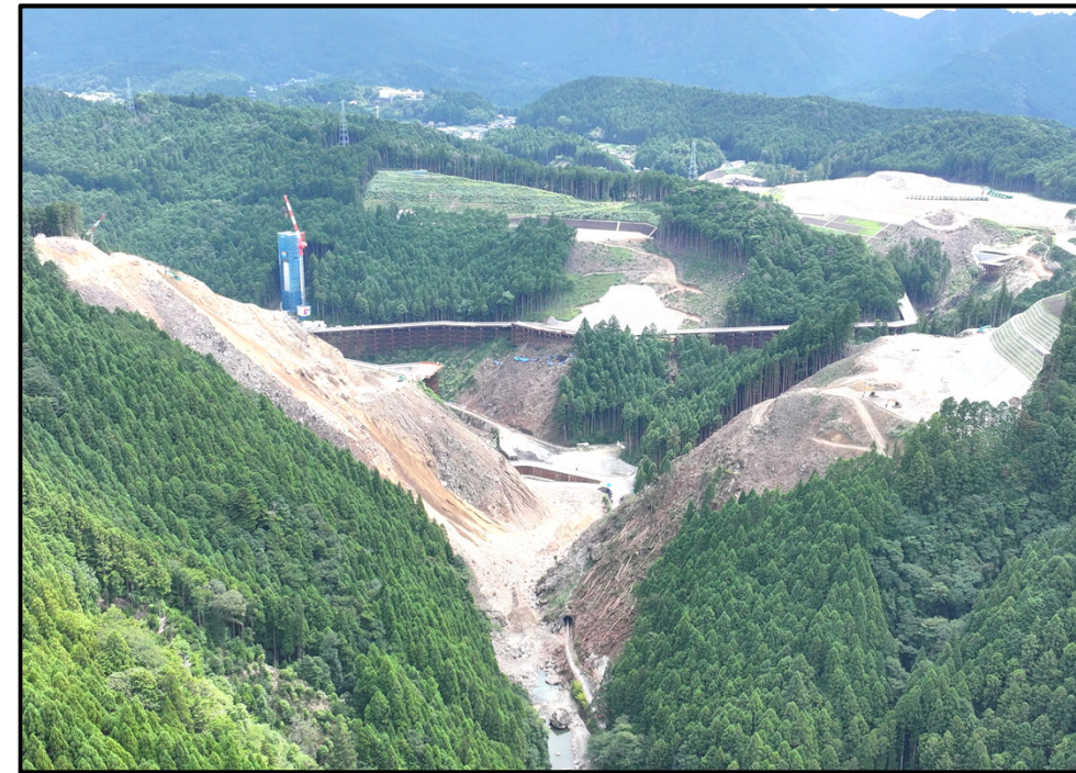
④ 下流側より
