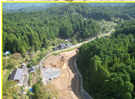
③小松地区道路建設
