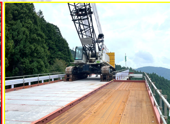
④松戸地区道路建設
