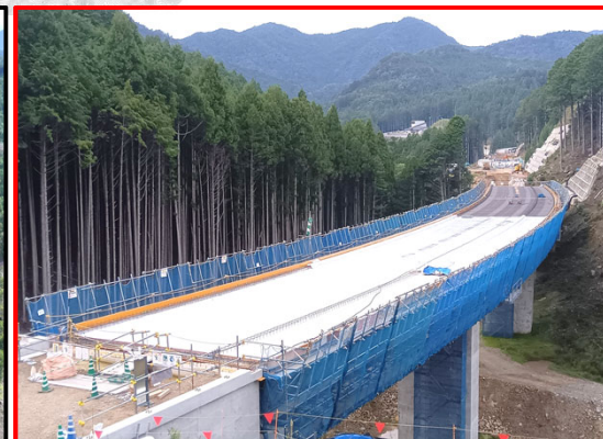
①3号橋床版工
