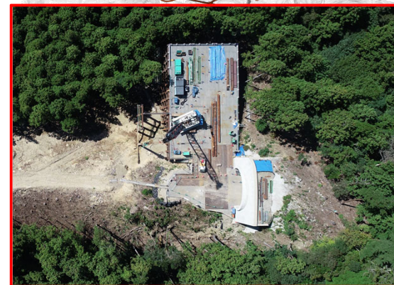
②3号橋下部工
