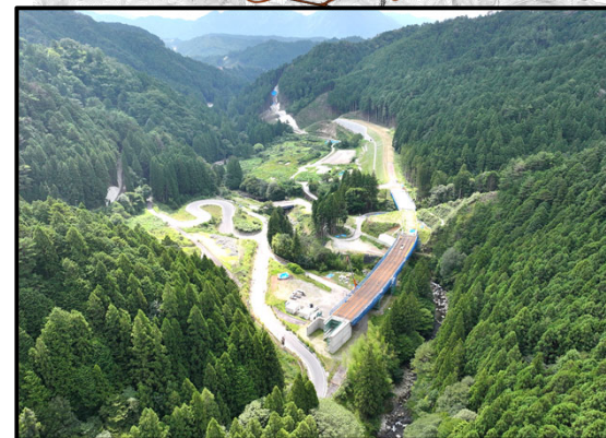
瀬戸設楽線1号橋から1号トンネル
