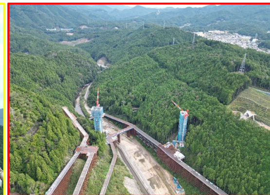
⑤5号橋PC上部工
