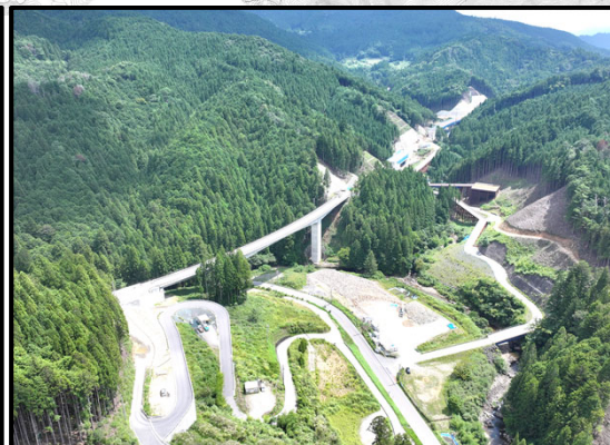
設楽根羽線5号橋から1号トンネル
