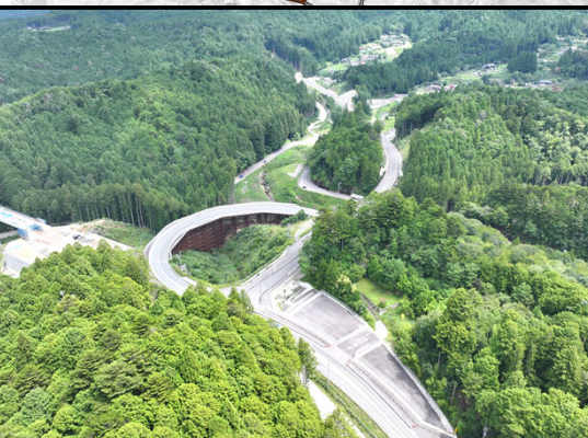
設楽根羽線起点から1号トンネル
