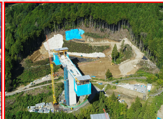
④4号橋下部工A2橋台
