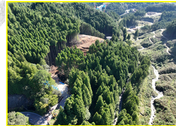
⑥川向地区道路建設
