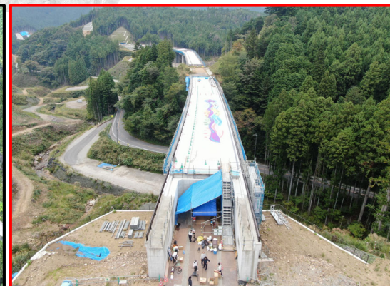
①1号橋PC上部工(起点側より)
