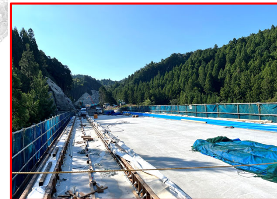
③4号橋PC上部工
