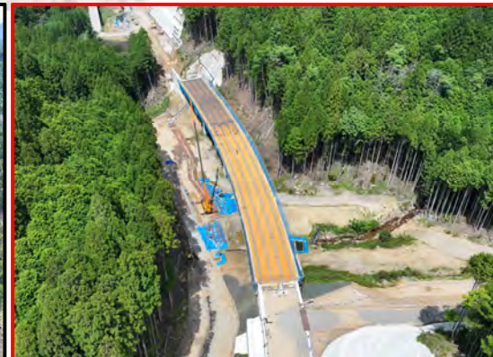
①3号橋床版工
