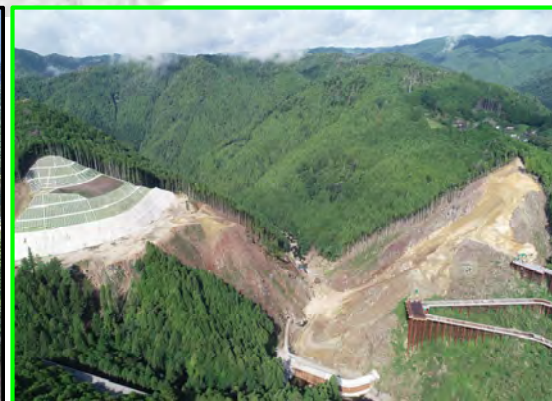
①本体建設第1期(上流側より)
