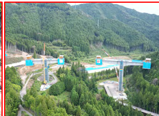
⑤4号橋PC上部工
