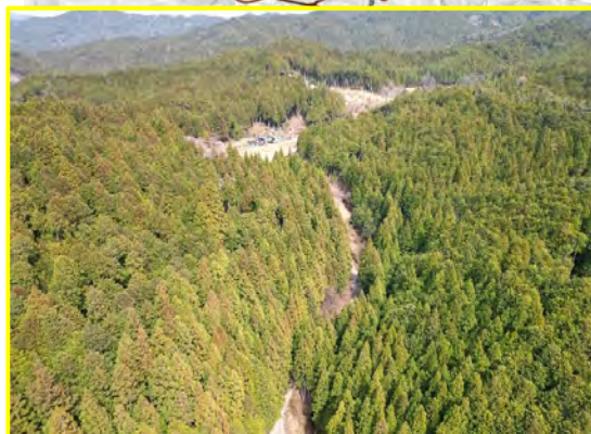
③小松地区道路建設
