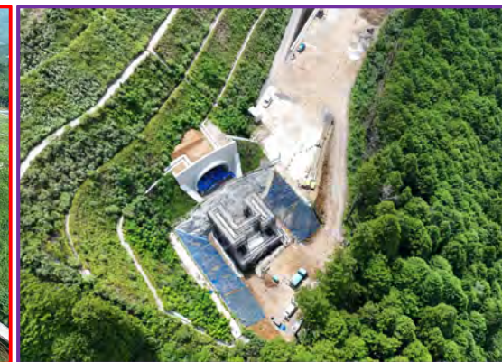
⑥4号トンネル(起点側)
