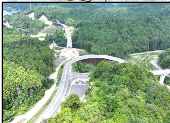
257号起点から設楽大橋
