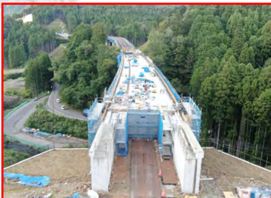
①1号橋PC上部工(起点側より)
