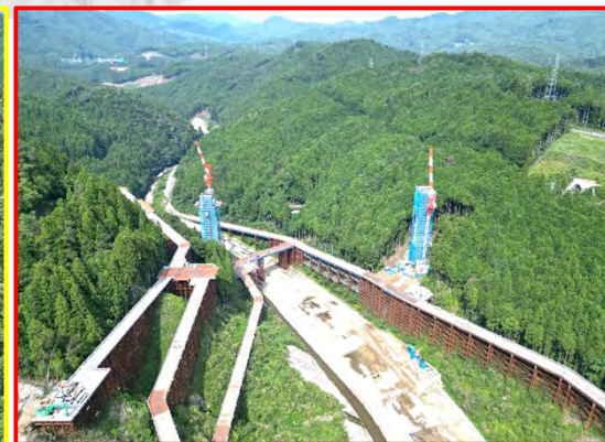
⑤5号橋PC上部工
