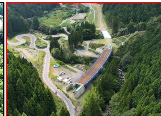
①大名倉地区床版（1号橋から2号橋）
