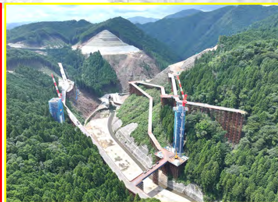
④松戸地区道路建設
