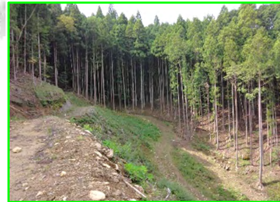
②貯水池東部整備(田口工区)
