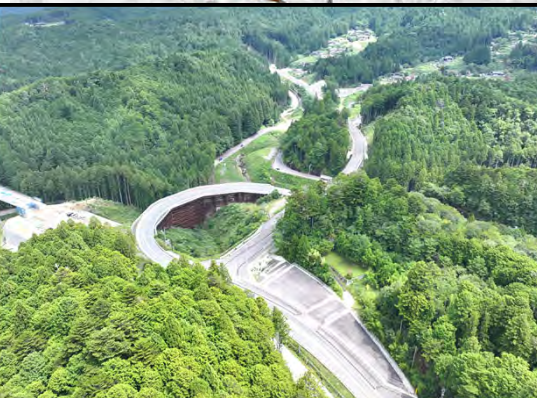
設楽根羽線起点から1号トンネル
