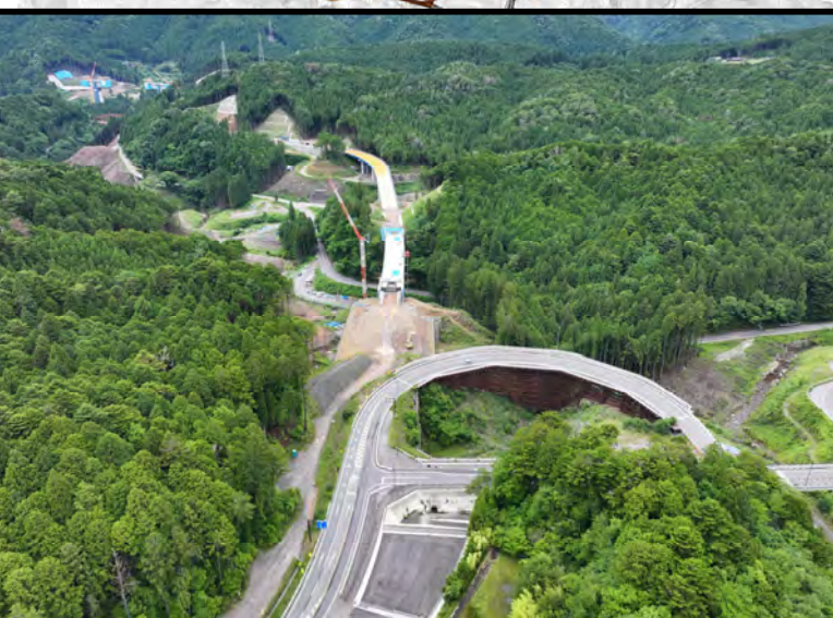
257号起点から設楽大橋
