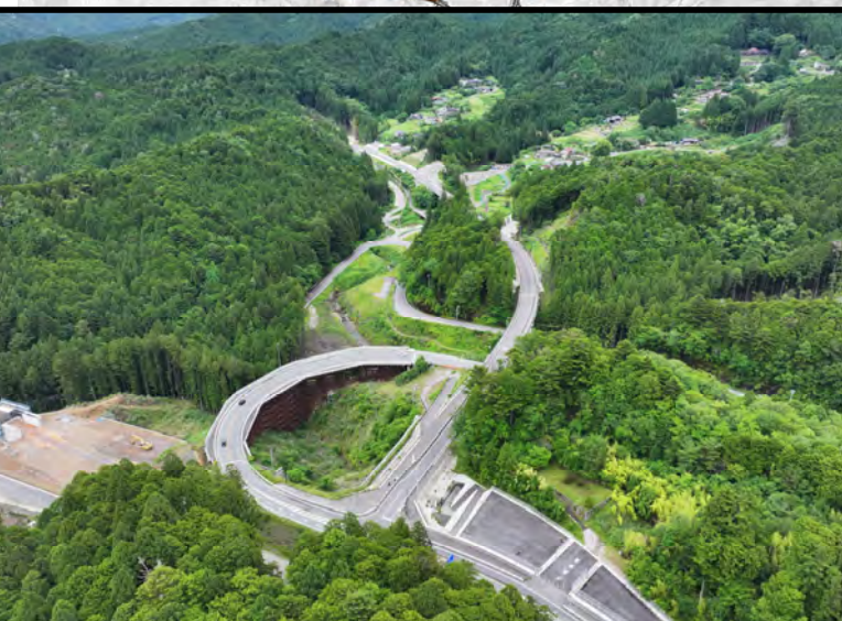
設楽根羽線起点から1号トンネル
