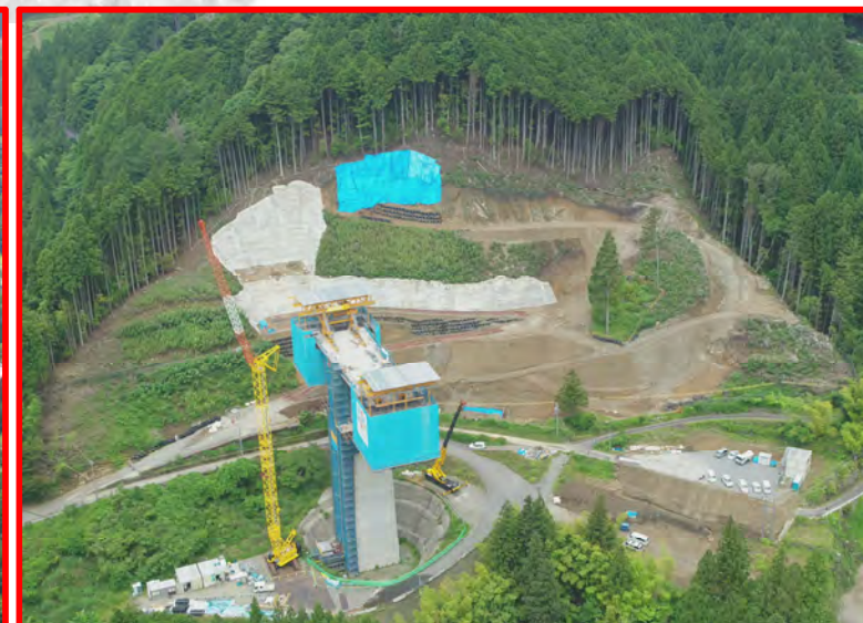
④4号橋下部工A2橋台
