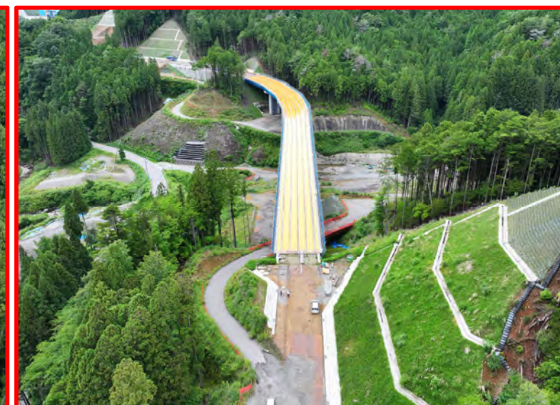
②2号橋床版工
