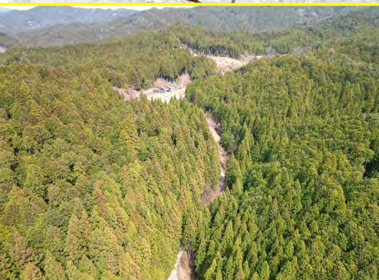
③小松地区道路建設
