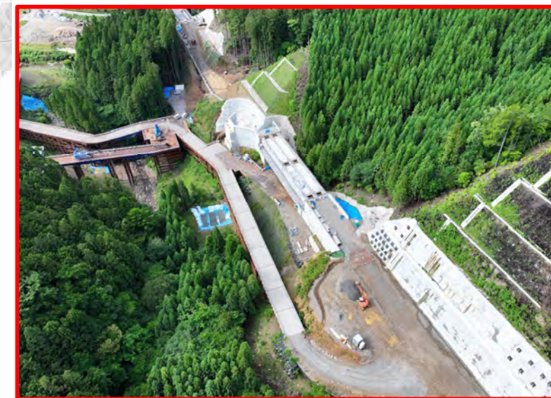
③4号橋PC上部工
