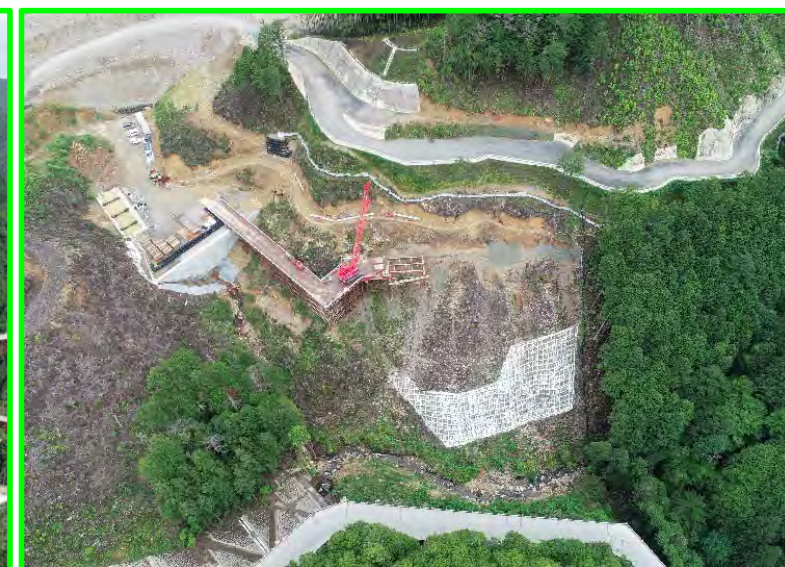
②清崎地区貯水池斜面对策
