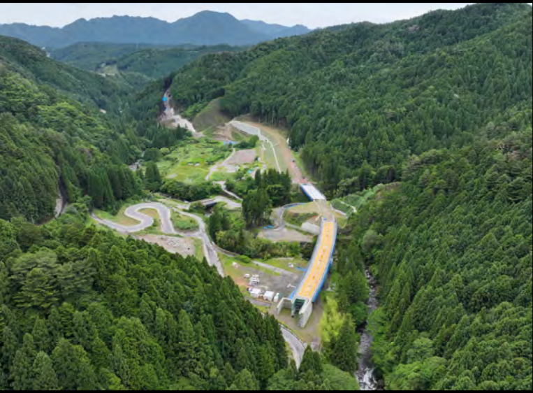
瀬戸設楽線1号橋から1号トンネル
