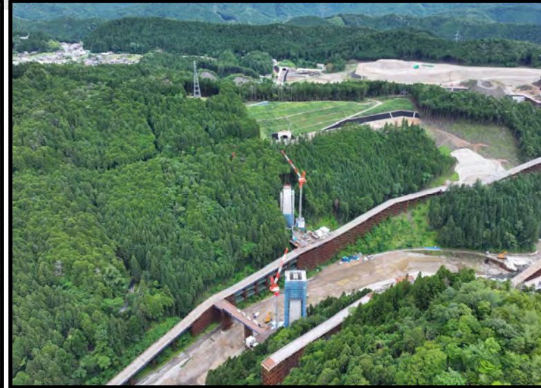
瀬戸設楽線5号橋から5号トンネル
