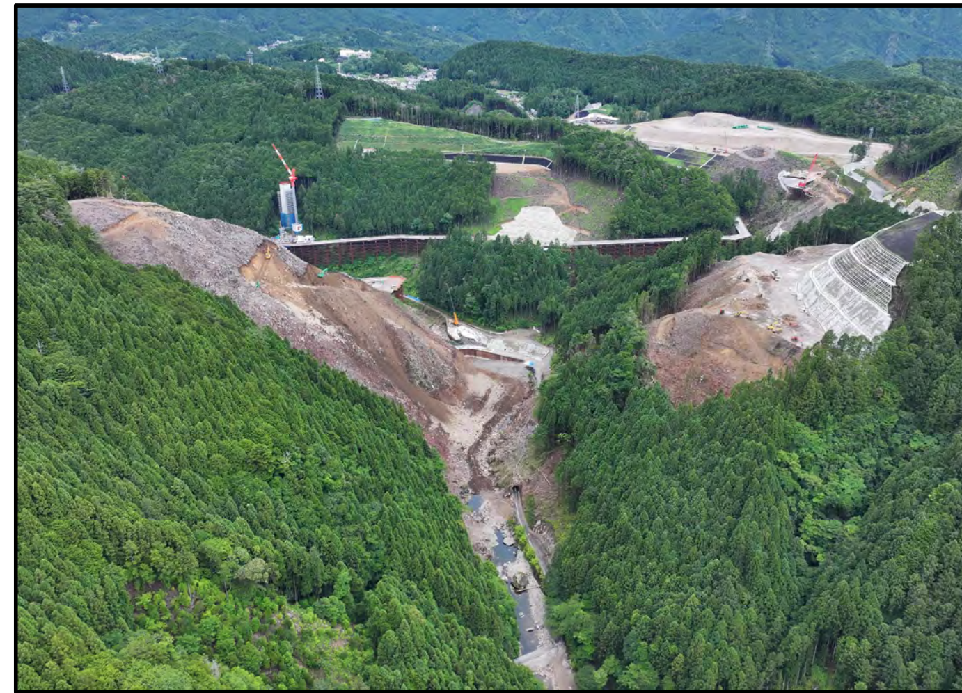
④ 下流側より
