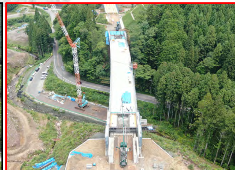
①1号橋PC上部工(起点側より)
