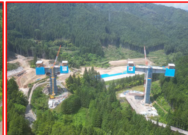
⑤4号橋PC上部工
