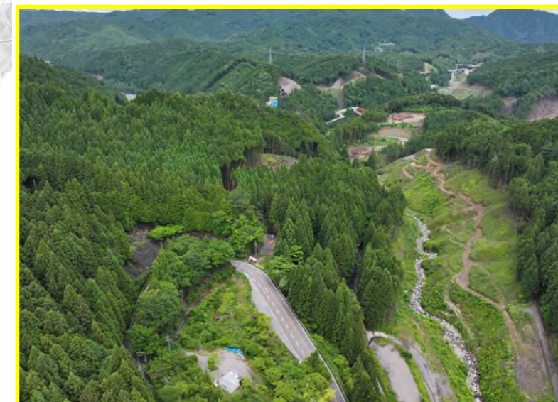
⑥川向地区道路建設
