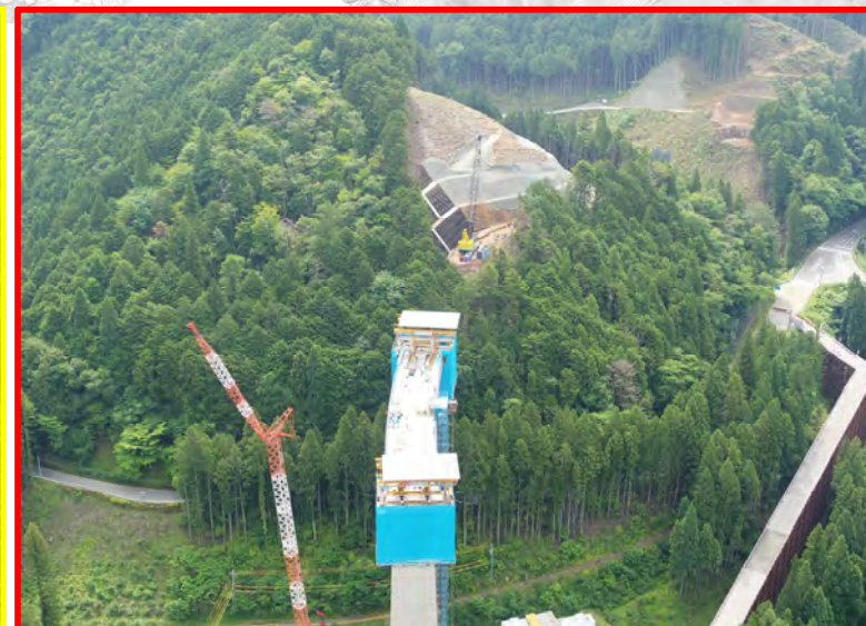
④4号橋下部工A1橋台
