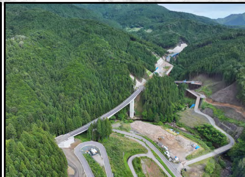
設楽根羽線5号橋から1号トンネル
