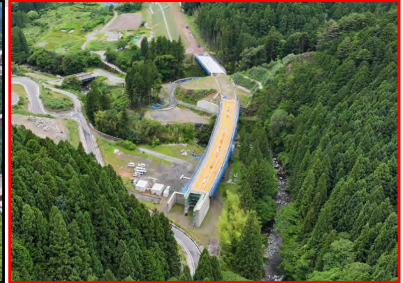
①大名倉地区床版(1号橋から2号橋)
