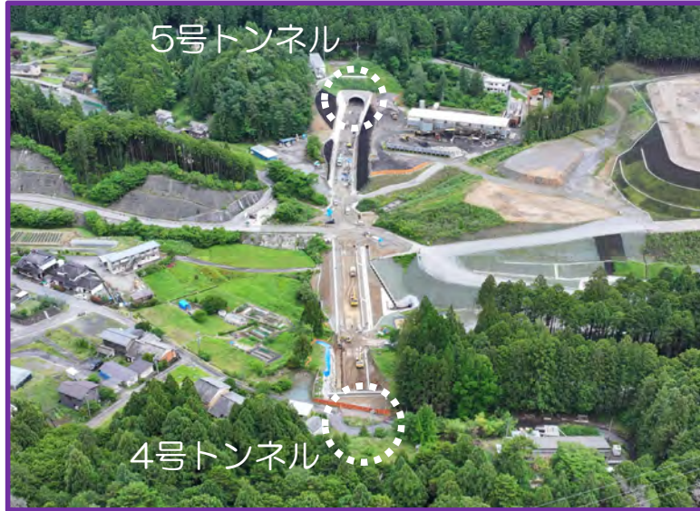
⑤4号トンネル（土工10工区遠景）
