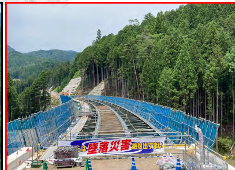
①3号橋床版工
