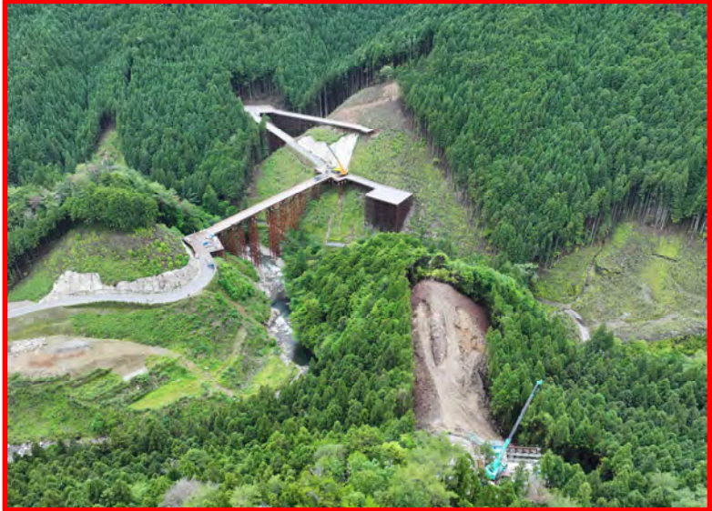
②3号橋下部工
