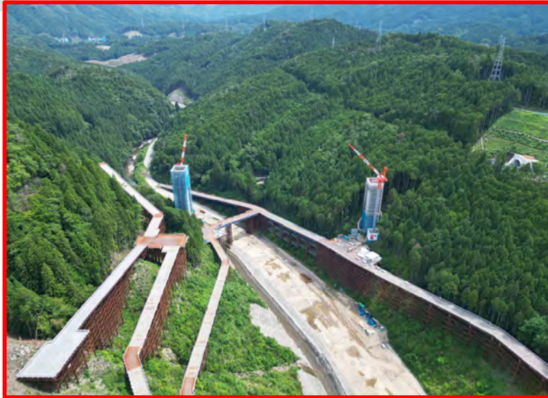
④5号橋PC上部工
