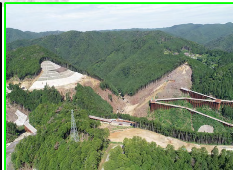
①本体建設第1期(上流側より)
