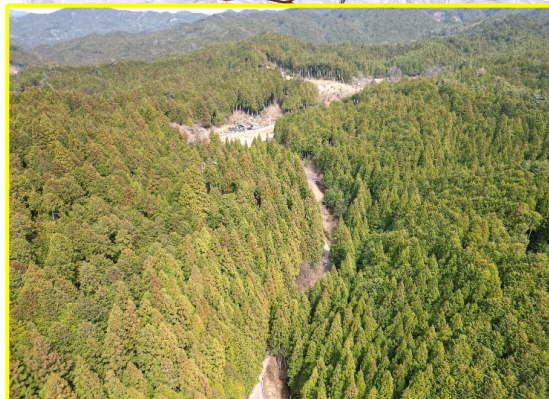
③小松地区道路建設
