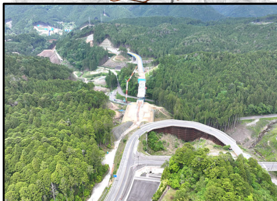
257号起点から設楽大橋
