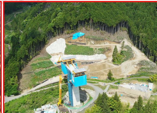
④4号橋下部工A2橋台
