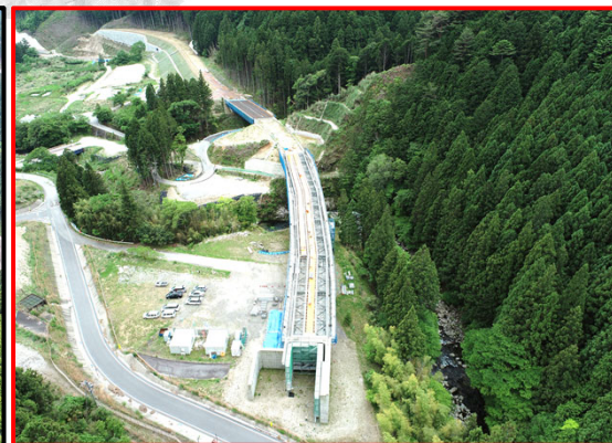
①大名倉地区床版（1号橋から2号橋）
