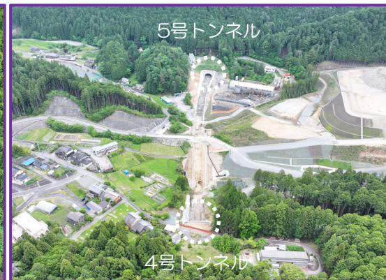
⑤4号トンネル（土工10工区遠景）
