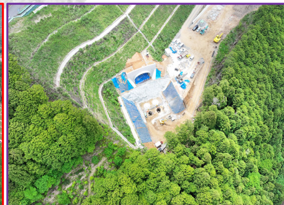
⑤4号トンネル（起点側）
