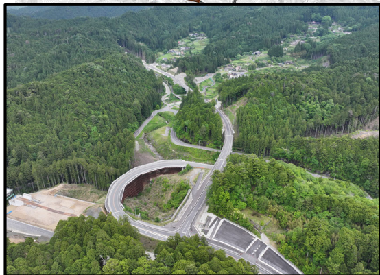
設楽根羽線起点から1号トンネル
