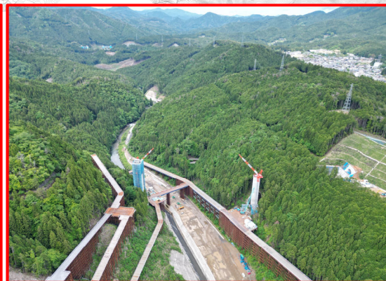
④5号橋PC上部工
