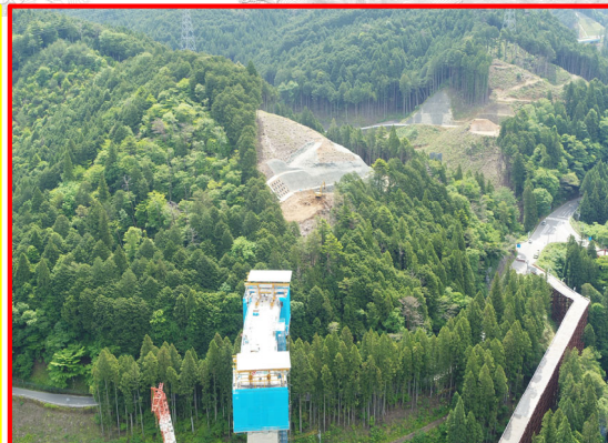
④4号橋下部工A1橋台
