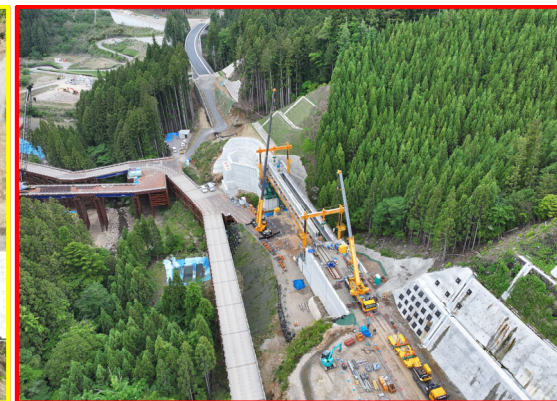
②4号橋PC上部工
