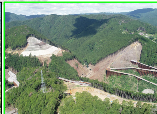
①本体建設第1期(上流側より)
