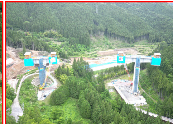
⑤4号橋PC上部工
