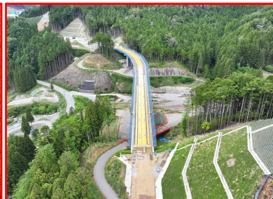
②2号橋床版工
