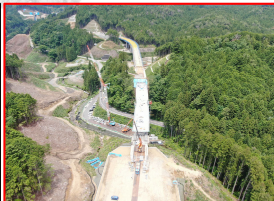
①1号橋PC上部工(起点側より)
