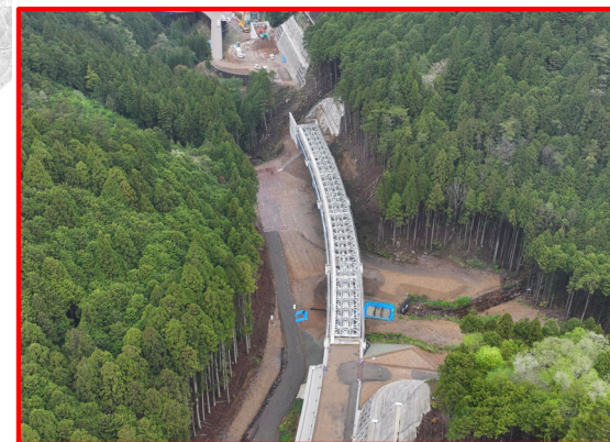
②3号橋鋼上部工
