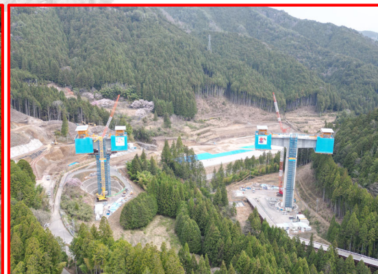
⑤4号橋PC上部工
