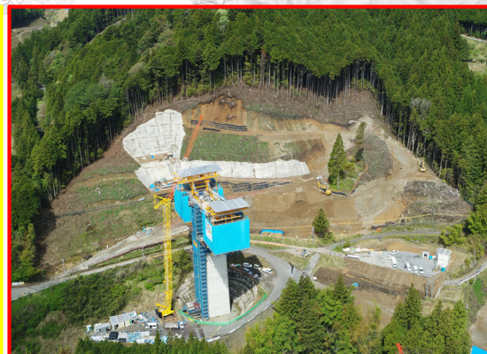
④4号橋下部工
