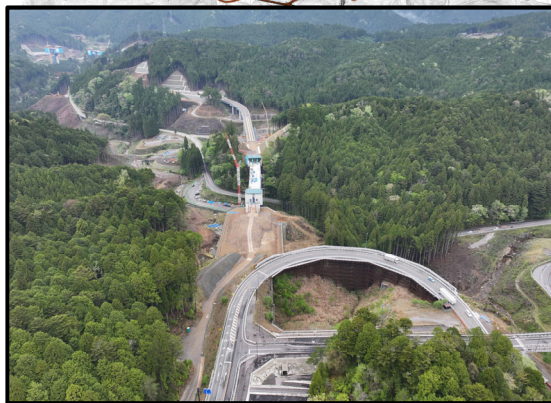
257号起点から設楽大橋
