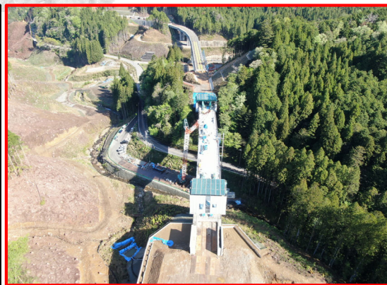
①1号橋PC上部工(起点側より)
