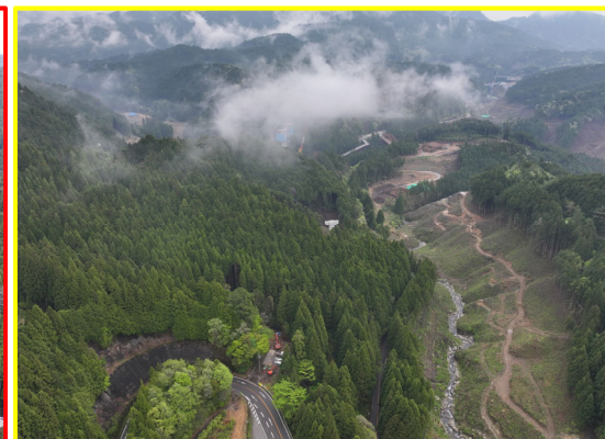
⑥川向地区道路建設
