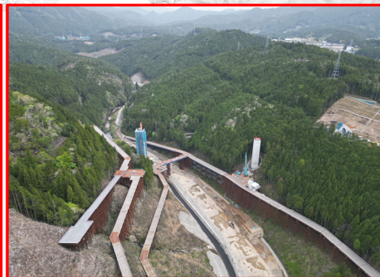
④5号橋PC上部工
