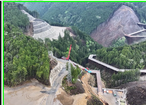
① 本体建設第1期(上流側より)
