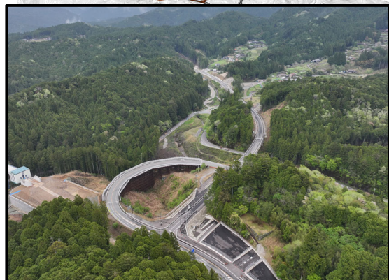
設楽根羽線起点から1号トンネル
