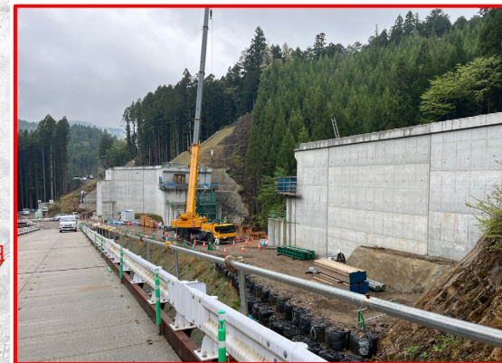
③4号橋PC上部工
