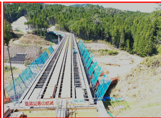
②2号橋床版工
