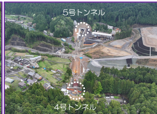
⑤4号トンネル (土工10工区遠景)
