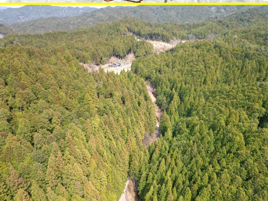
③小松地区道路建設
