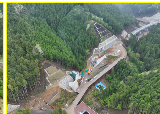
①八橋地区道路建設(長江工区)
