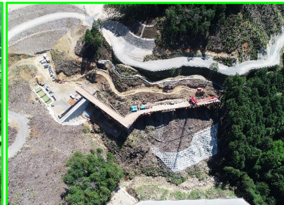
② 清崎地区貯水池斜面对策
