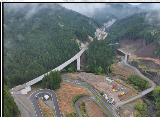
設楽根羽線5号橋から1号トンネル
