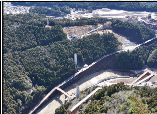
瀬戸設楽線5号橋から5号トンネル
