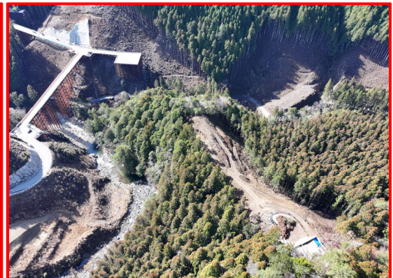
②3号橋下部工
