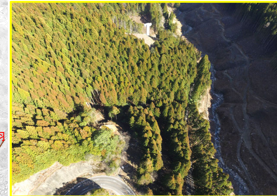
④川向地区道路建設
