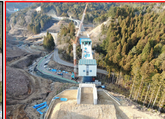
①1号橋PC上部工(起点側より)
