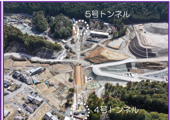
⑤4号トンネル (土工10工区遠景)
