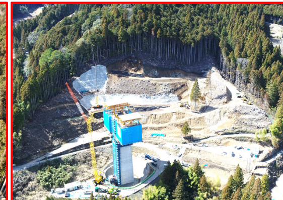
②4号橋下部工
