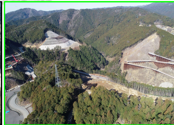
① 本体建設第1期(上流側より)
