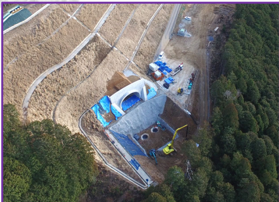
⑤4号トンネル (起点側)
