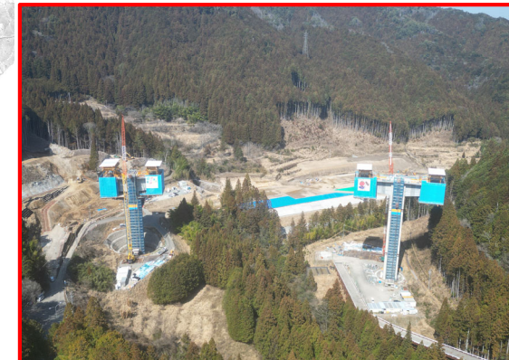
③4号橋PC上部工
