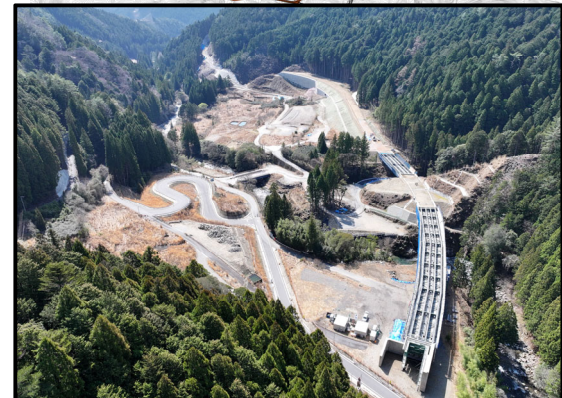
瀬戸設楽線1号橋から1号トンネル
