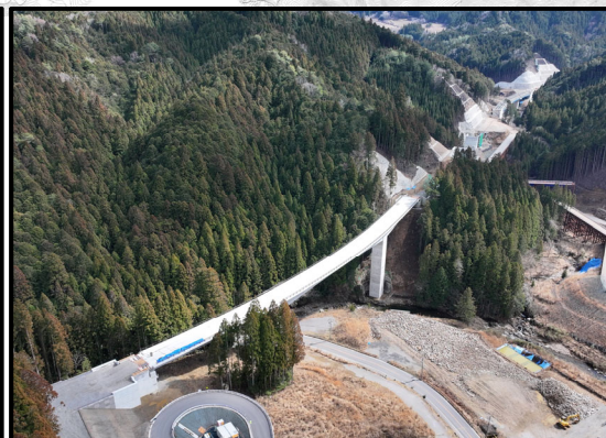
設楽根羽線1号トンネルから5号橋
