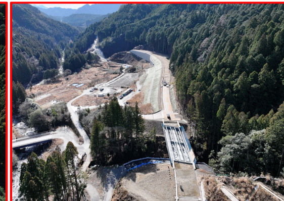
②2号橋鋼上部工
