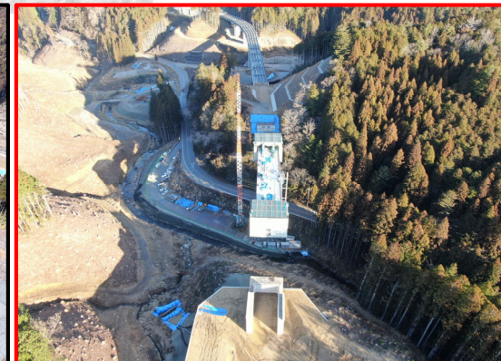
①1号橋PC上部工(起点側より)
