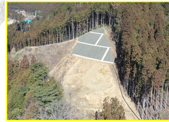
②田口地区道路建設(奴田工区)
