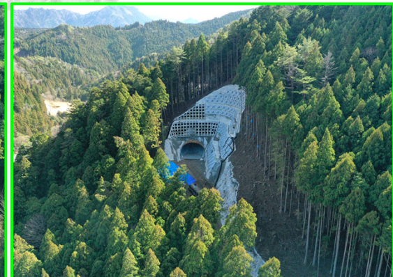
③大名倉地区斜面对策(近景)
