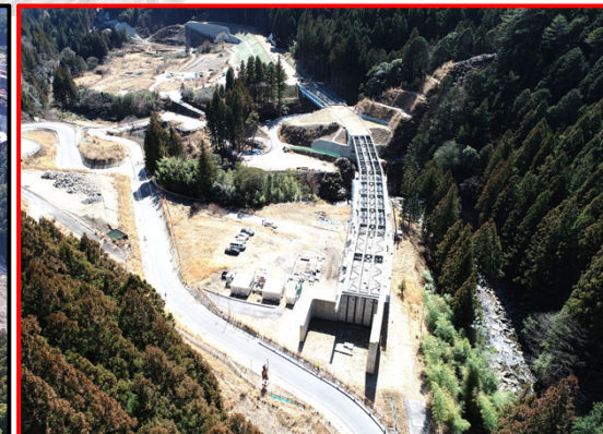
①大名倉地区床版（1号橋）
