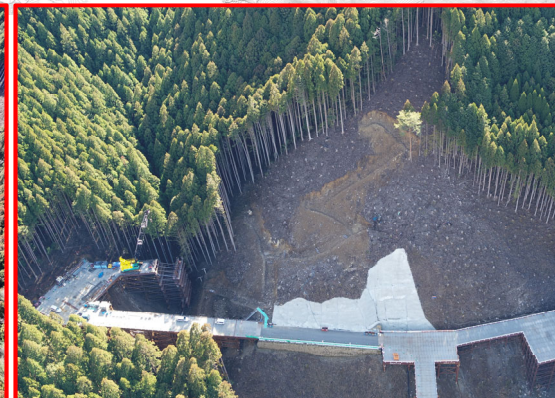
⑤松戸地区橋梁下部工
