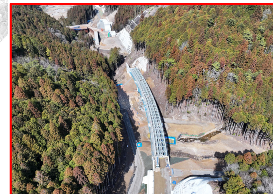
②3号橋鋼上部工
