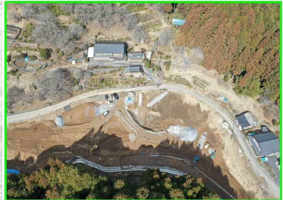
⑤延坂地区盛土整備(小松工区)
