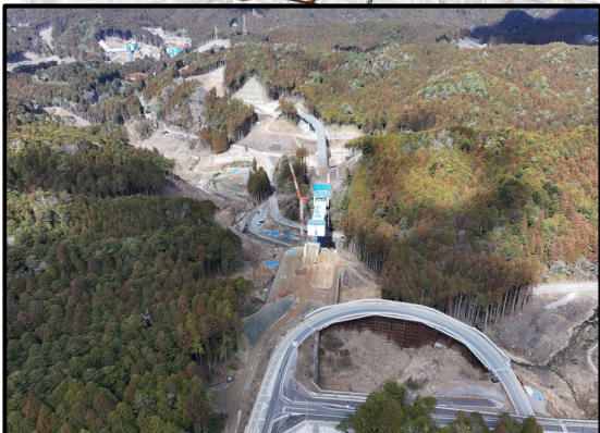
257号起点から設楽大橋
