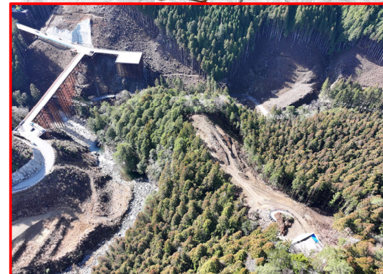
④3号橋下部工
