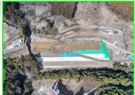
⑤延坂地区盛土整備(延坂工区)
