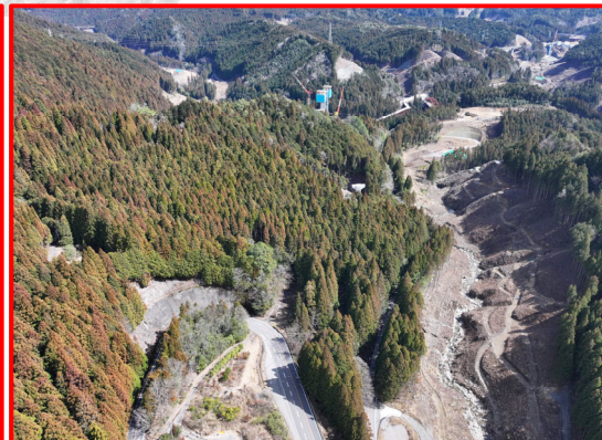
⑤川向地区道路建設
