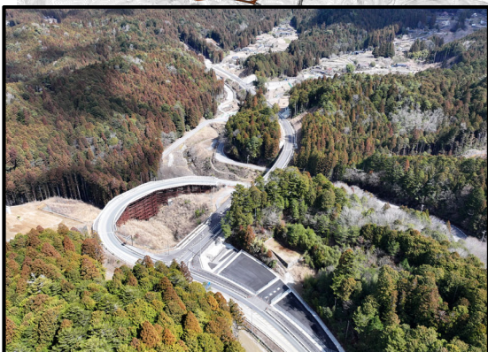
設楽根羽線起点から1号トンネル
