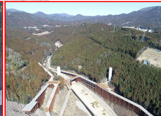
⑥5号橋PC上部工
