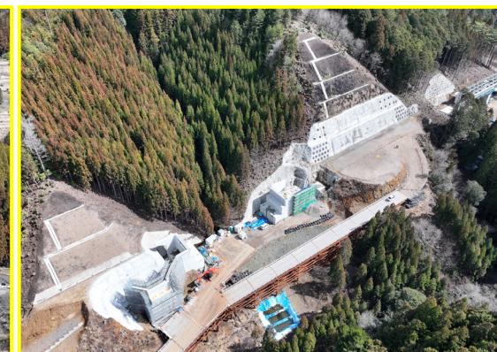
①八橋地区道路建設(長江工区)
