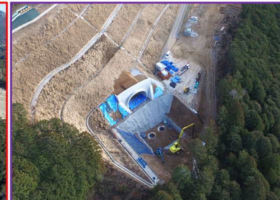
⑦4号トンネル (起点側)
