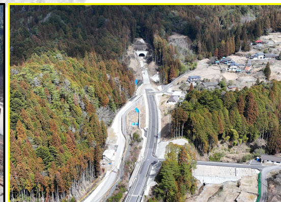
①八橋地区道路建設(田口・小松工区終点)
