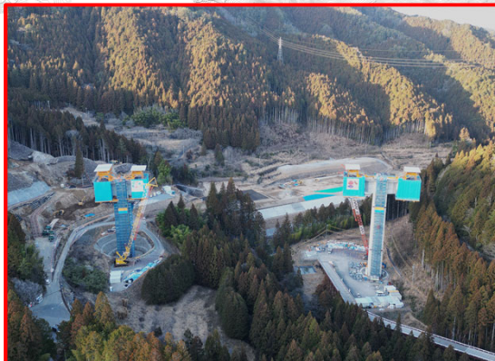
④4号橋PC上部工
