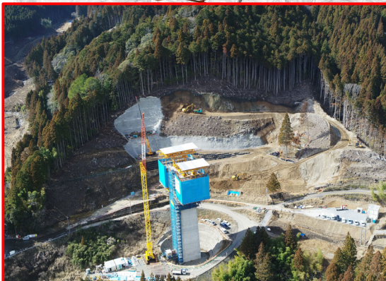
③4号橋下部工
