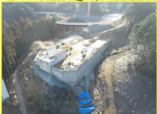
③田口地区道路建設(田口工区)
