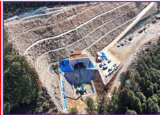
⑥ 4号トンネル（起点側）
