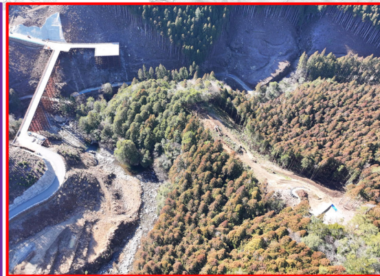
④ 3号橋下部工
