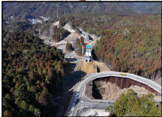
257号起点から設楽大橋
