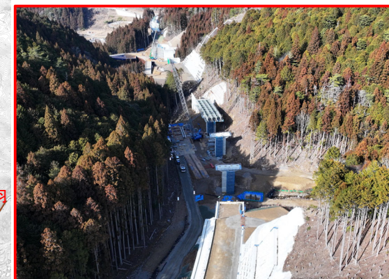
③3号橋鋼上部工
