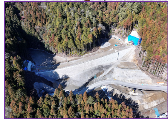
③ 瀬戸設楽線トンネル（土工4工区）
