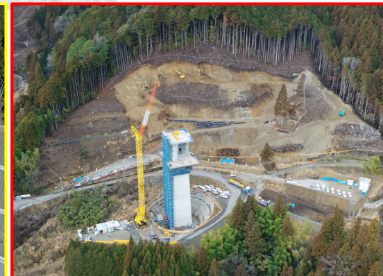
④4号橋下部工
