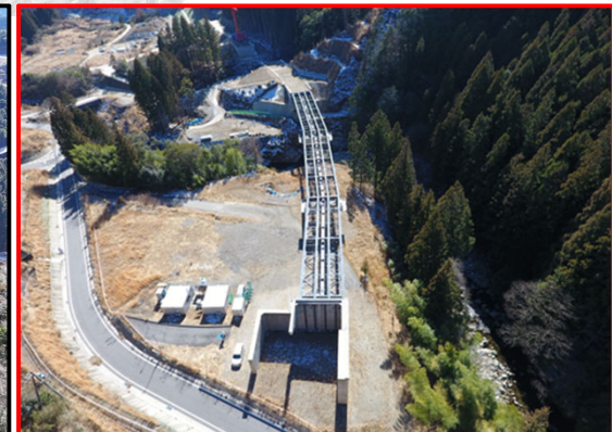
①大名倉地区床版 (1号橋)
