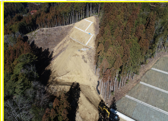
③田口地区道路建設(奴田工区)
