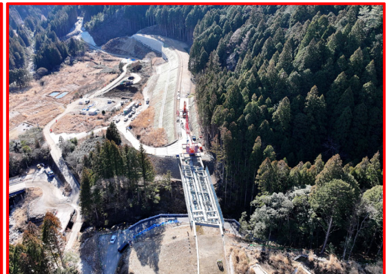
②2号橋鋼上部工
