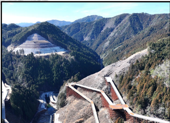
ダム本体施工箇所
