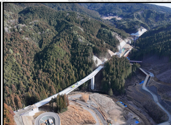
設楽根羽線1号トンネルから5号橋
