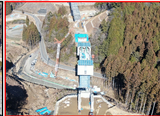
①1号橋PC上部工(起点側より)
