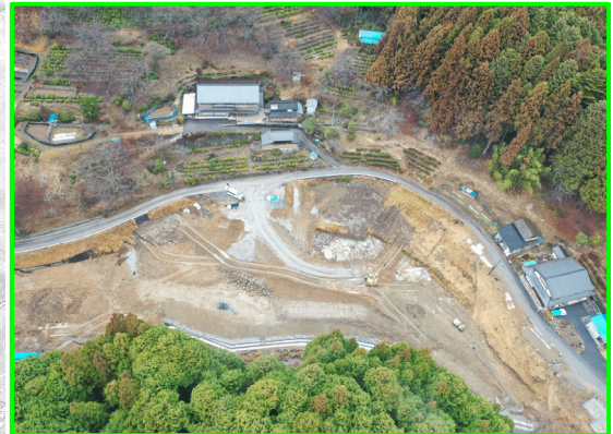
⑦延坂地区盛土整備(小松工区)
