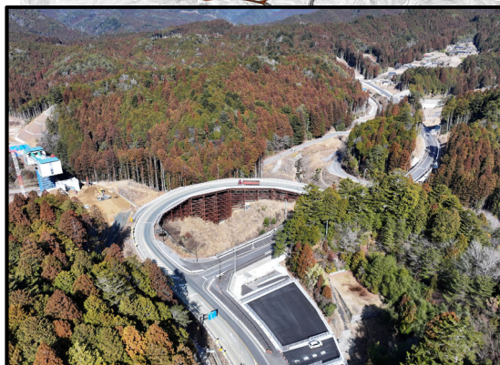
設楽根羽線起点から1号トンネル
