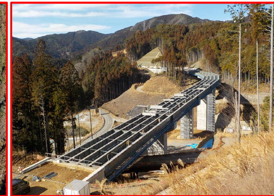
②2号橋鋼上部工
