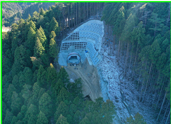
⑤大名倉地区斜面对策(近景)
