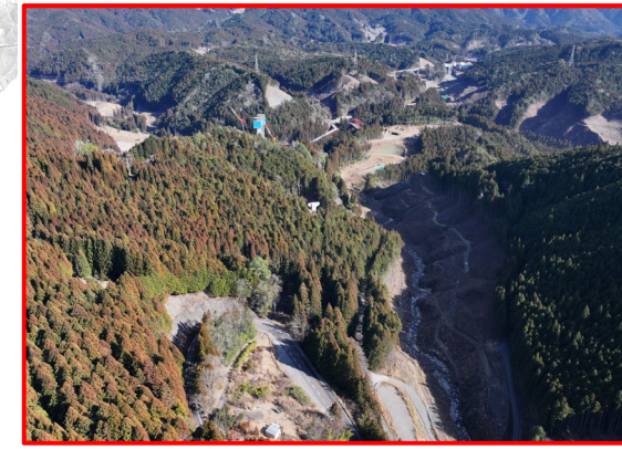
⑥川向地区道路建設
