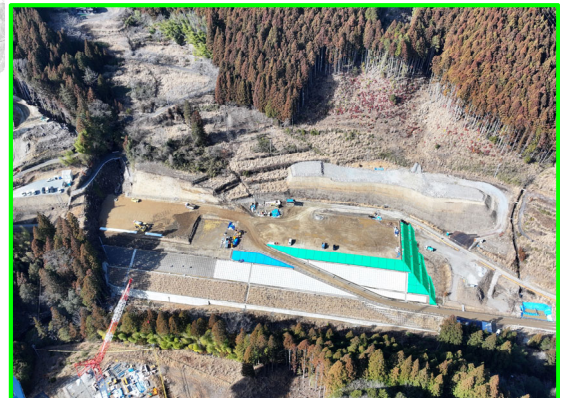
⑦延坂地区盛土整備(延坂工区)
