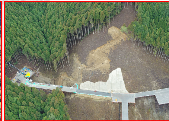
⑤ 松戸地区橋梁下部工
