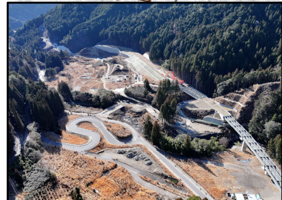
瀬戸設楽線1号橋から1号トンネル
