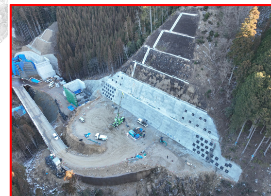
②3号橋右岸下部工(終点側)
