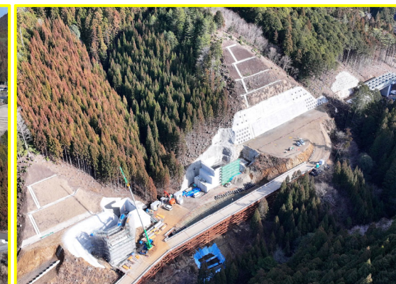
①八橋地区道路建設(長江工区)
