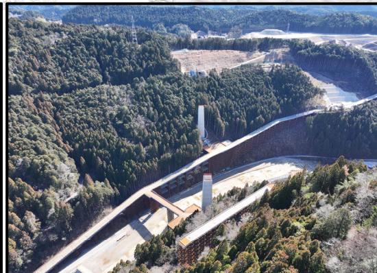
瀬戸設楽線5号橋から5号トンネル
