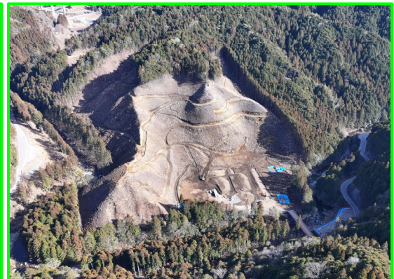
⑥田口地区林道進入路整備
