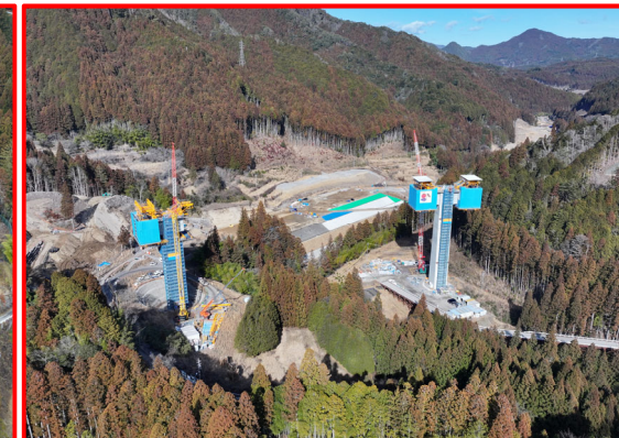
⑤4号橋PC上部工
