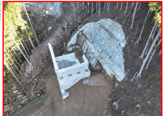
② 3号橋右岸下部工(起点側)
