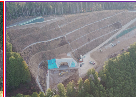
⑤4号トンネル（起点側）
