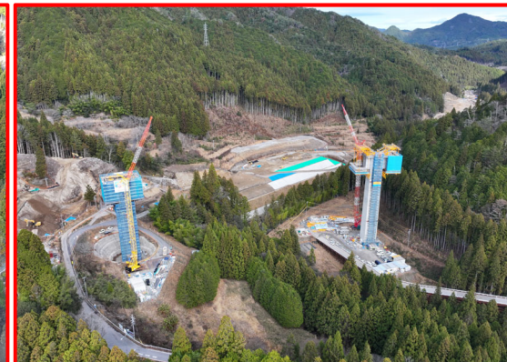
⑤4号橋PC上部工
