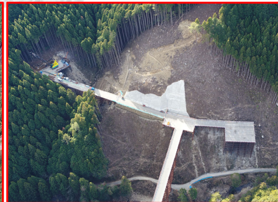
④松戸地区橋梁下部工
