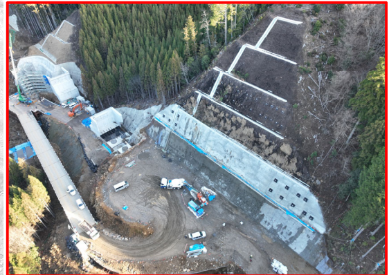
② 3号橋右岸下部工(終点側)
