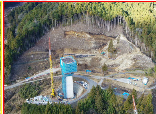
④4号橋下部工
