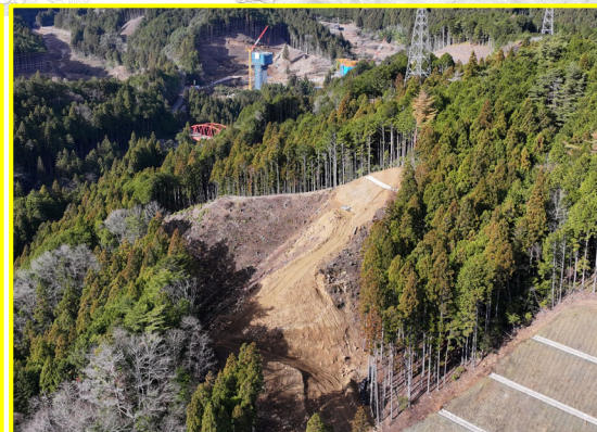
③田口地区道路建設(奴田工区)
