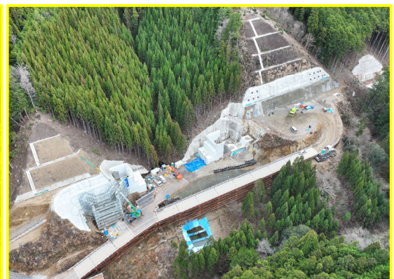
① 八橋地区道路建設(長江工区)
