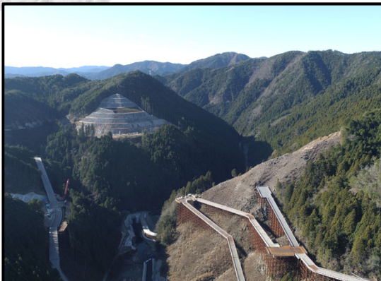
ダム本体施工箇所
