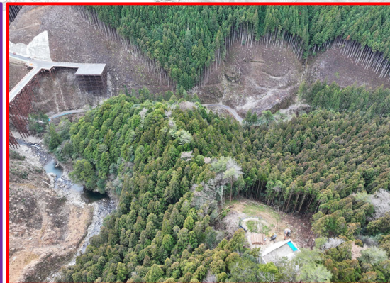
③3号橋下部工
