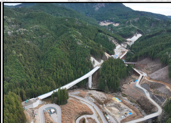
設楽根羽線1号トンネルから5号橋
