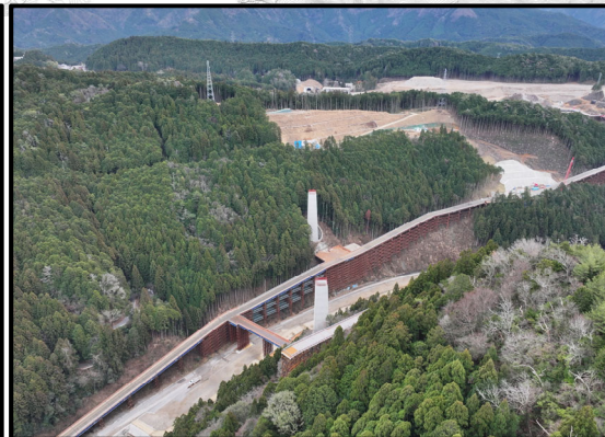
瀬戸設楽線5号橋から5号トンネル
