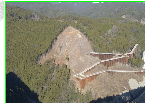
②松戸地区整備(右岸側)
