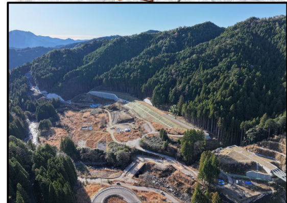
瀬戸設楽線土工3工区から5号橋
