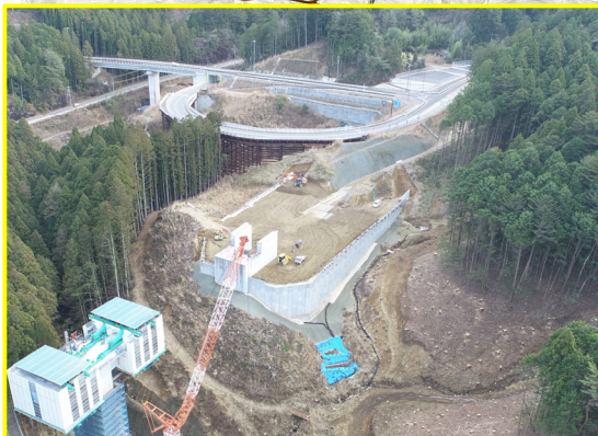
③田口地区道路建設(田口工区)
