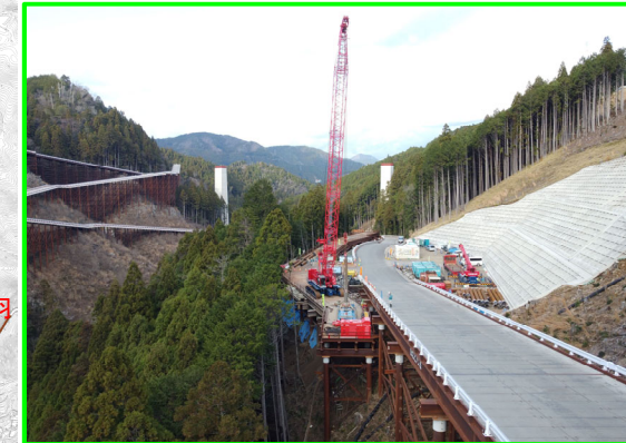
③田口地区貯水池斜面对策
