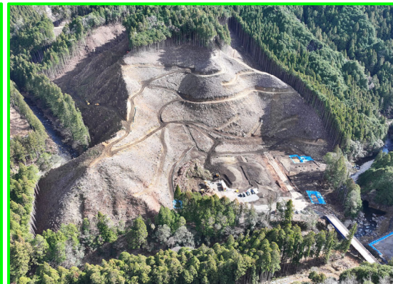
⑥田口地区林道進入路整備
