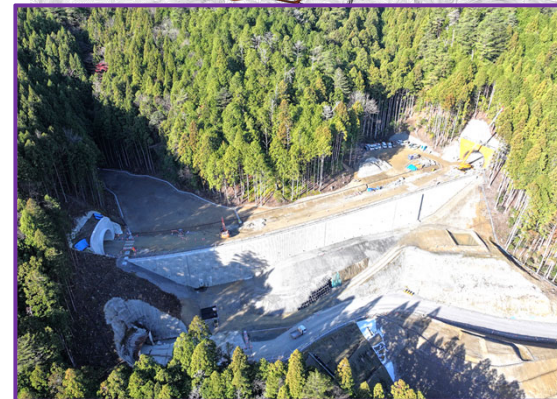
②瀬戸設楽線トンネル（土工4工区）
