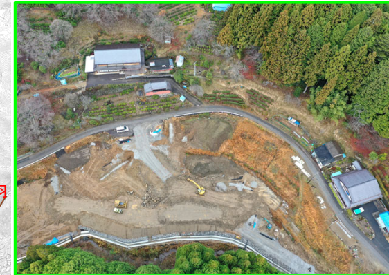
⑦延坂地区盛土整備(小松工区)
