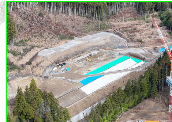
⑦延坂地区盛土整備(延坂工区)
