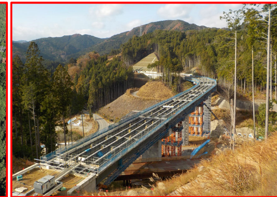
②2号橋鋼上部工
