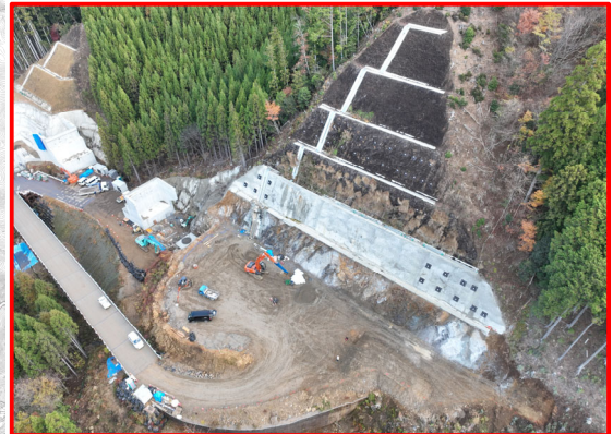
② 3号橋右岸下部工(終点側)
