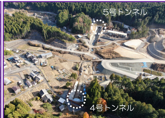
⑤4号トンネル(土工10工区遠景)
