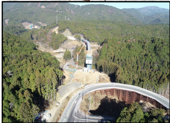
257号起点から設楽大橋
