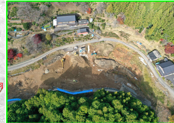
⑦延坂地区盛土整備(小松工区)
