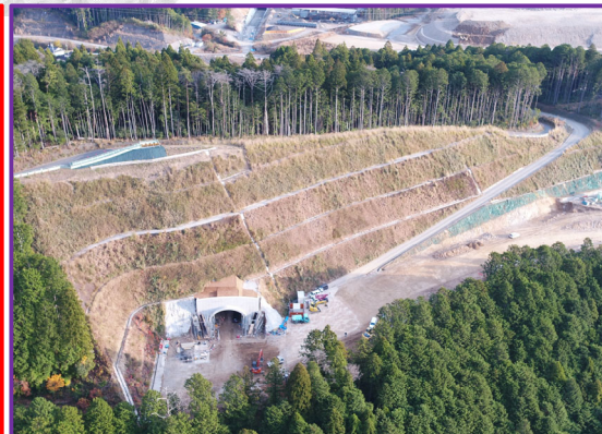
⑤4号トンネル(起点側)
