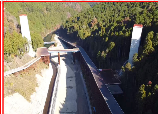
④5号橋下部工(遠景)
