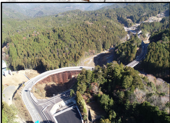
設楽根羽線起点から1号トンネル
