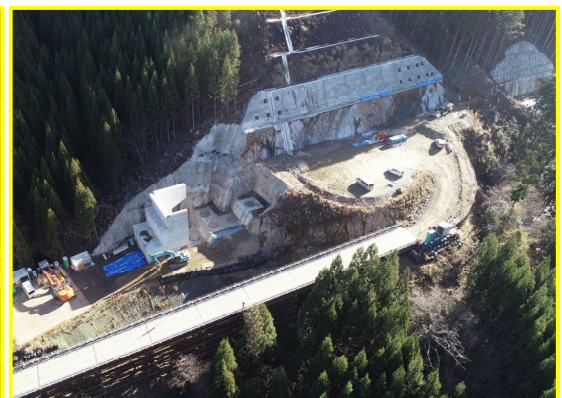
① 八橋地区道路建設(長江工区)
