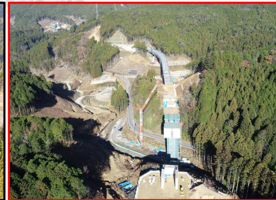
①1号橋PC上部工(起点側より)
