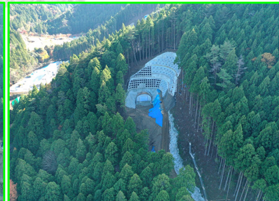
⑥大名倉地区斜面对策(近景)
