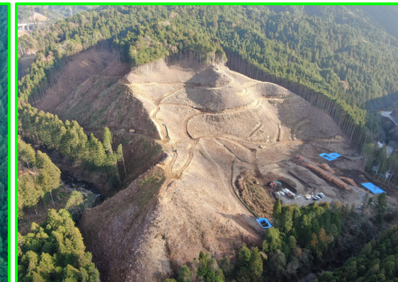
⑥田口地区林道進入路整備
