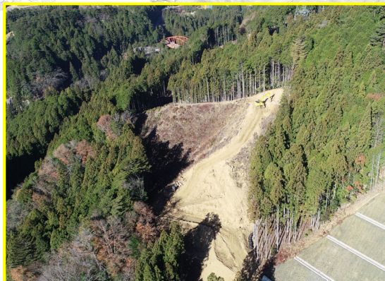
③田口地区道路建設(奴田工区)
