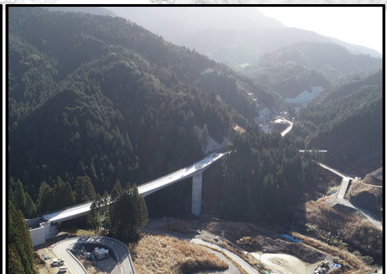
設楽根羽線1号トンネルから5号橋
