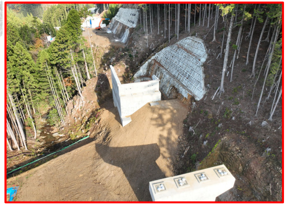
② 3号橋右岸下部工(起点側)
