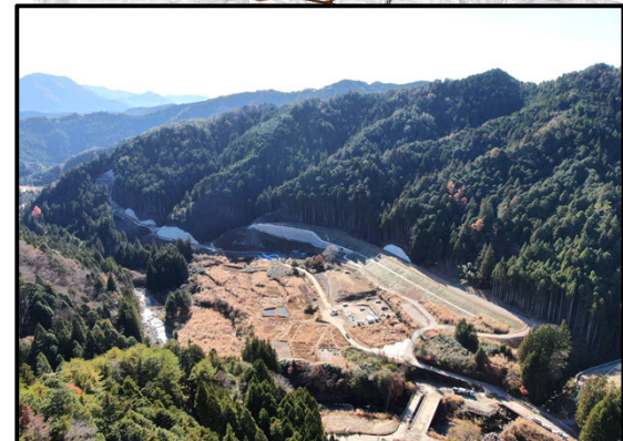
瀬戸設楽線土工3工区から5号橋
