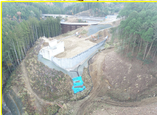
③田口地区道路建設(田口工区)
