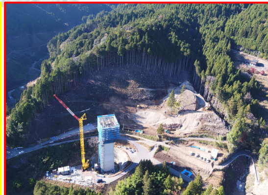
④4号橋下部工
