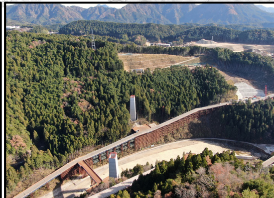
瀬戸設楽線5号橋から5号トンネル
