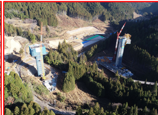
⑤4号橋PC上部工
