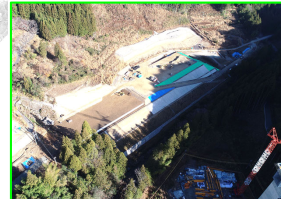
⑦延坂地区盛土整備(延坂工区)
