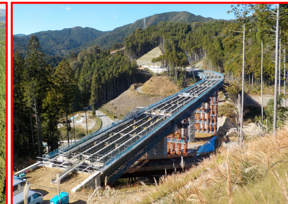
②2号橋鋼上部工
