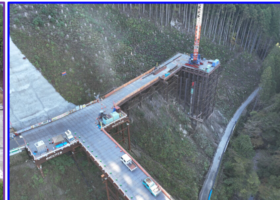
②松戸地区工事用進入路
