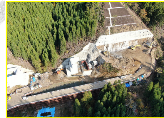
①八橋地区道路建設(長江工区)
