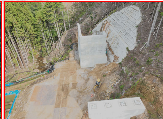
③3号橋右岸下部工(起点側)
