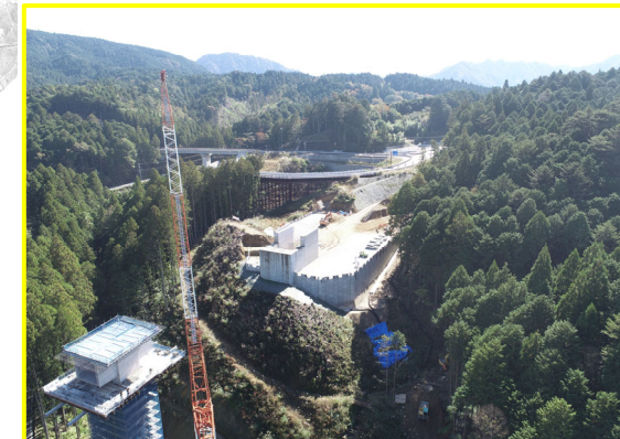
③田口地区道路建設(田口工区)
