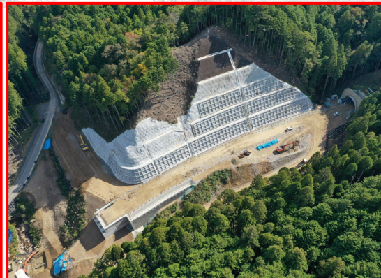
②3号橋左岸下部工(終点側より)
