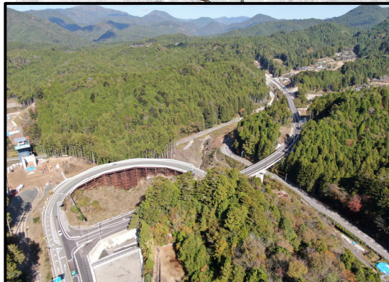
設楽根羽線起点から1号トンネル
