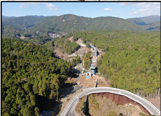
257号起点から設楽大橋
