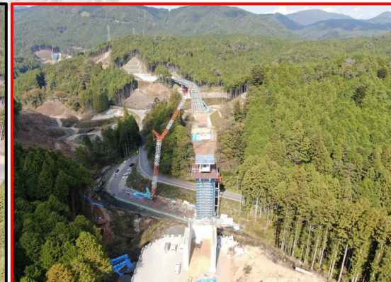
①1号橋PC上部工(起点側より)
