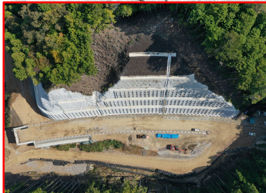
②3号橋左岸下部工(真上)
