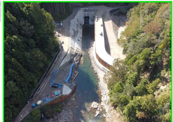
①堤外仮排水路 (呑口側)
