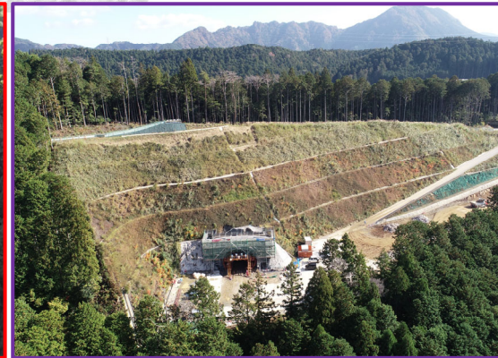
⑤4号トンネル(起点側)
