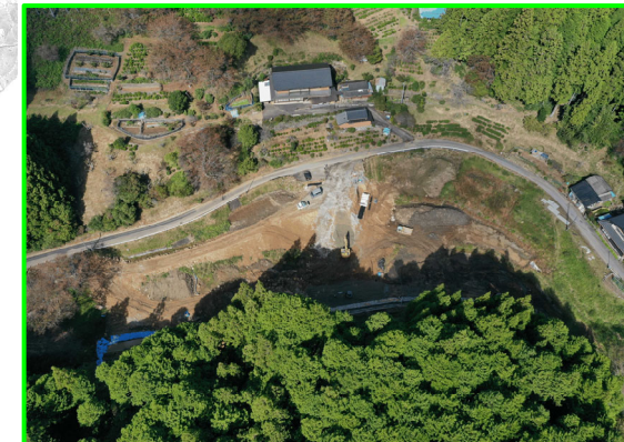
⑧延坂地区盛土整備(小松工区)
