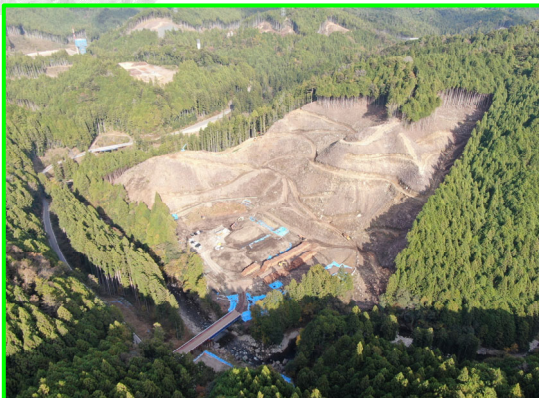
⑦田口地区林道進入路整備
