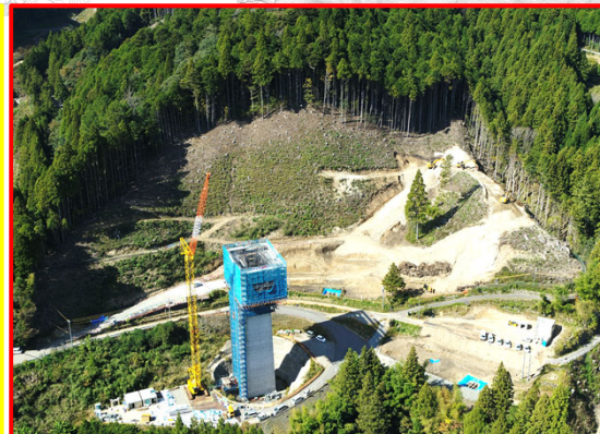
⑤4号橋下部工
