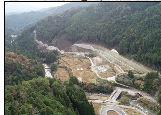
瀬戸設楽線土工3工区から5号橋
