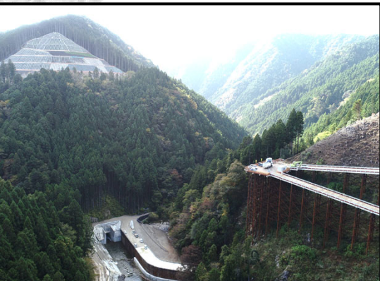
ダム本体施工箇所
