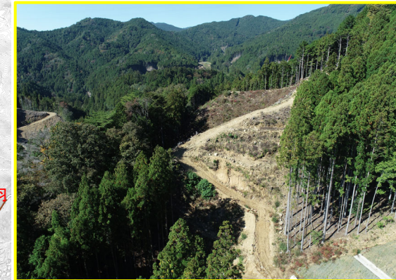
③田口地区道路建設(奴田工区)
