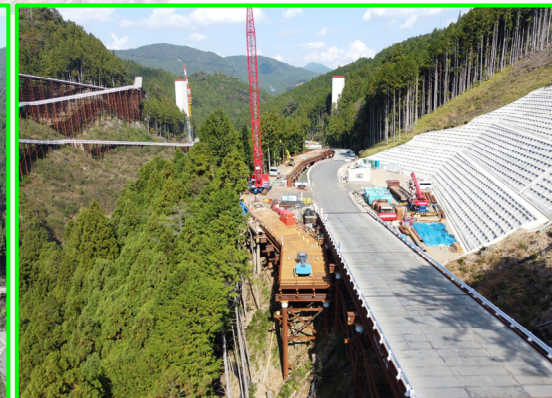
④田口地区貯水池斜面对策
