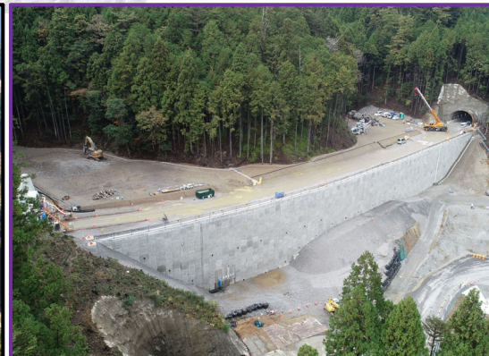
①瀬戸設楽線トンネル (土工4工区)
