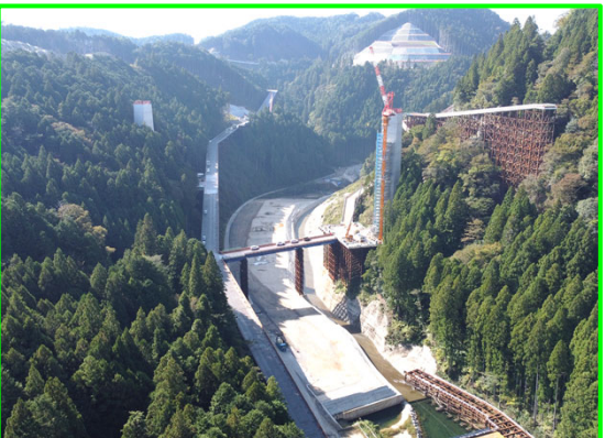
①堤外仮排水路 (遠景)
