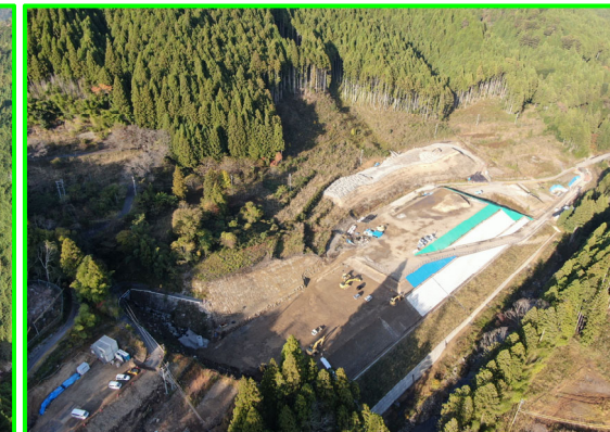
⑧延坂地区盛土整備(延坂工区)
