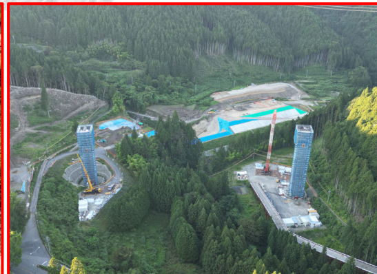
⑥4号橋PC上部工
