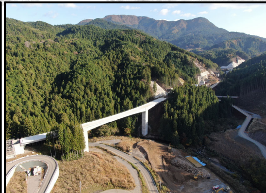
設楽根羽線1号トンネルから5号橋
