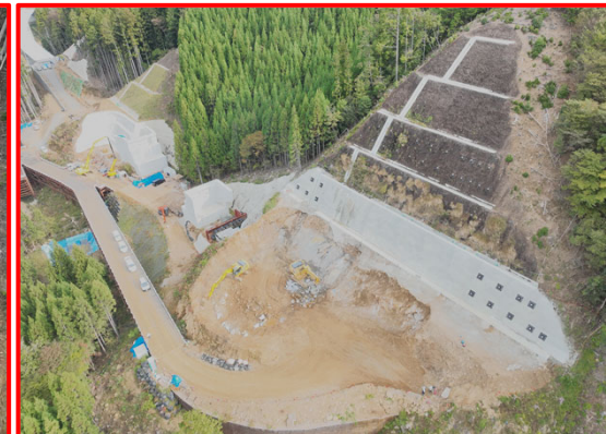
③3号橋右岸下部工(終点側)
