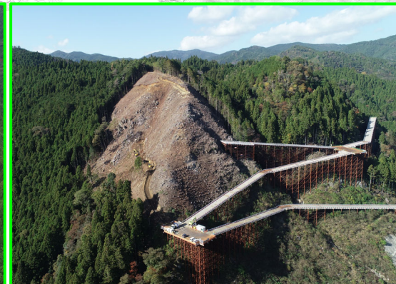
③松戸地区整備(右岸側)
