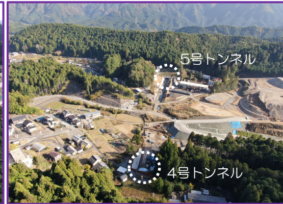
⑤4号トンネル(土工10工区遠景)
