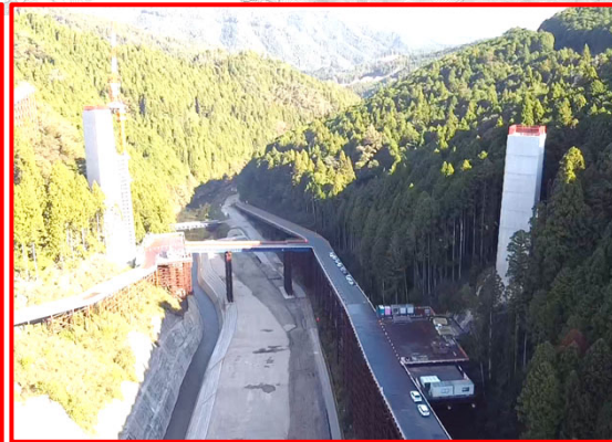
④5号橋下部工(遠景)
