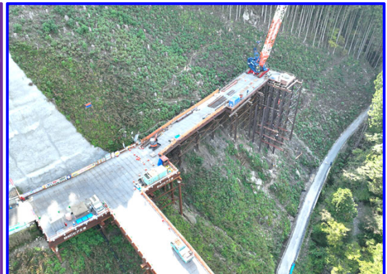
②松戸地区工事用進入路
