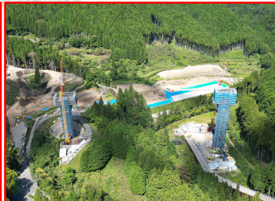
⑥4号橋PC上部工
