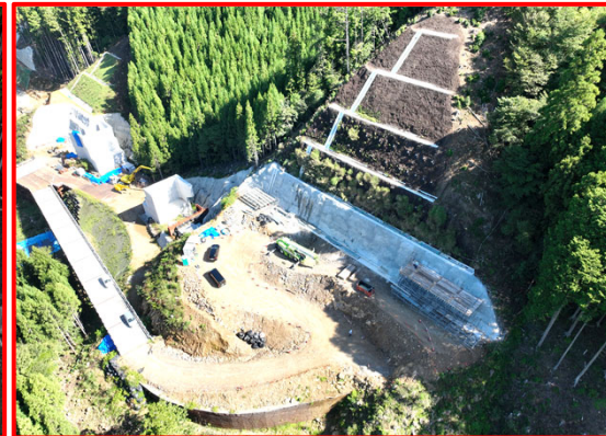
③3号橋右岸下部工(終点側)
