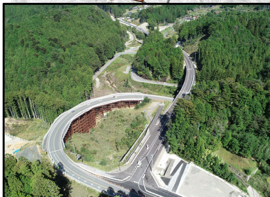
設楽根羽線起点から1号トンネル
