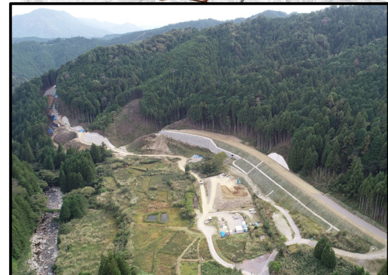
瀬戸設楽線土工3工区から5号橋
