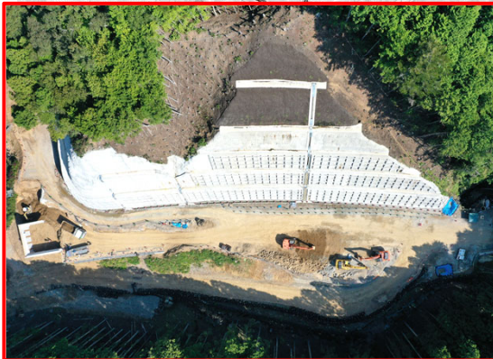
②3号橋左岸下部工(真上)
