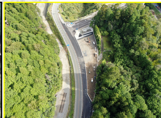
①八橋地区道路建設(田口・小松工区起点)
