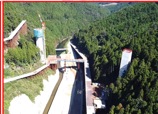
④5号橋下部工(遠景)
