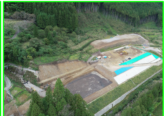
⑧延坂地区盛土整備(延坂工区)
