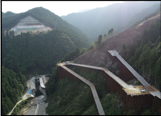
ダム本体施工箇所
