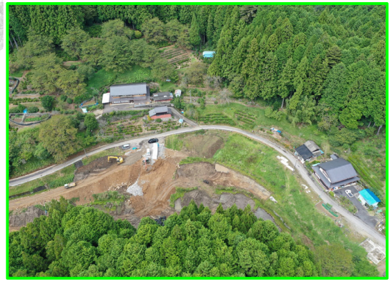
⑧延坂地区盛土整備(小松工区)
