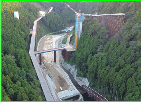
①堤外仮排水路（遠景）
