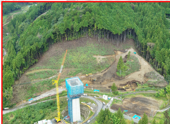
⑤4号橋下部工
