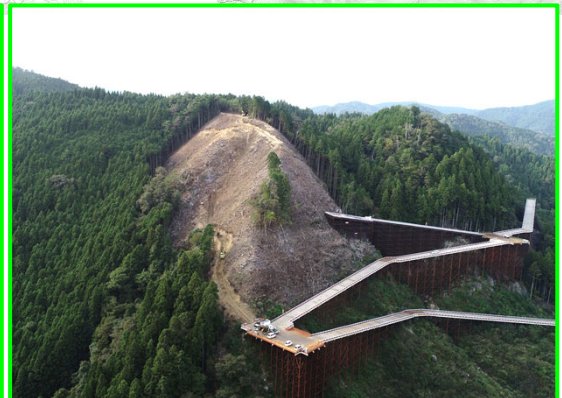
③松戸地区整備(右岸側)
