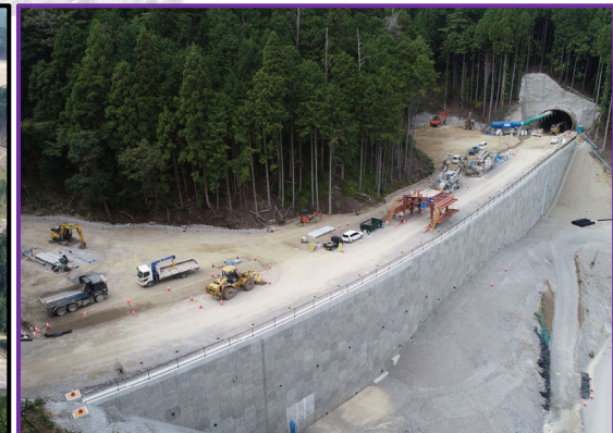
①瀬戸設楽線トンネル (土工4工区)
