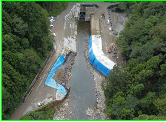
①堤外仮排水路（呑口側）
