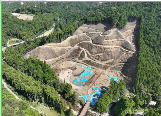
⑦田口地区林道進入路整備工事
