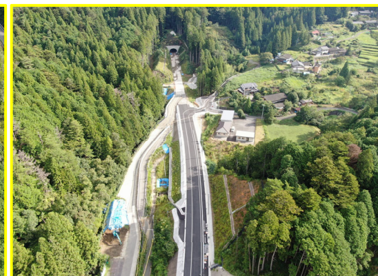
①八橋地区道路建設(田口・小松工区終点)
