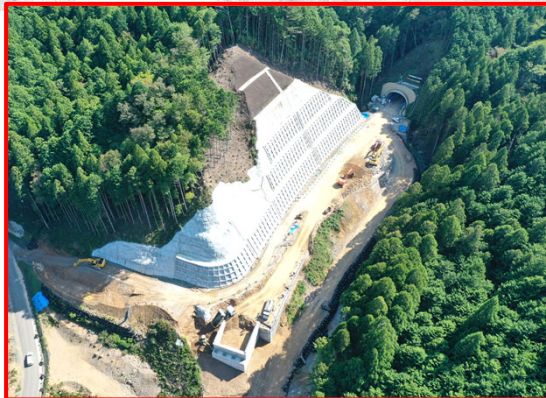
②3号橋左岸下部工(終点側より)
