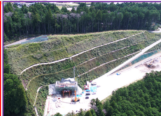
⑤4号トンネル(起点側)
