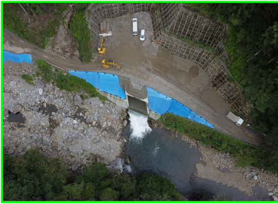
①堤外仮排水路（吐口側）
