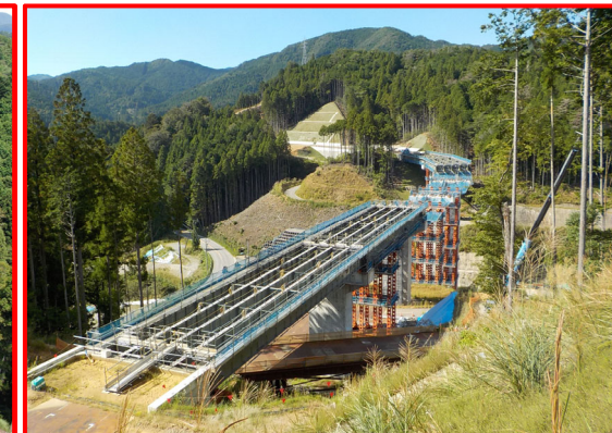
②2号橋鋼上部工
