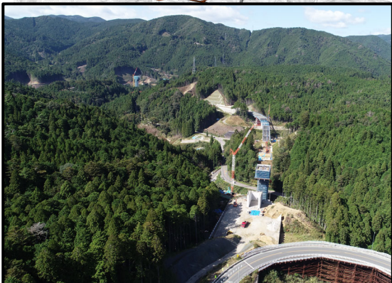
257号起点から設楽大橋
