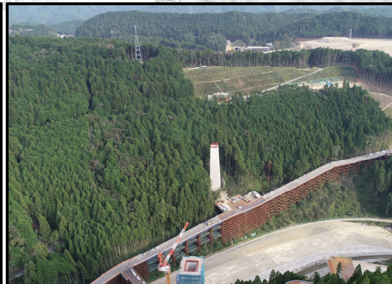
瀬戸設楽線5号橋から5号トンネル
