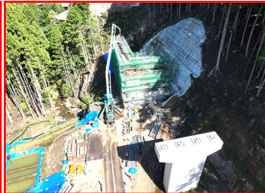
③3号橋右岸下部工(起点側)
