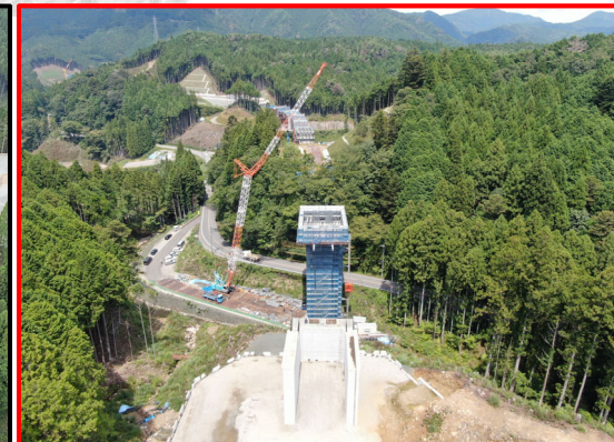
①1号橋PC上部工(起点側より)
