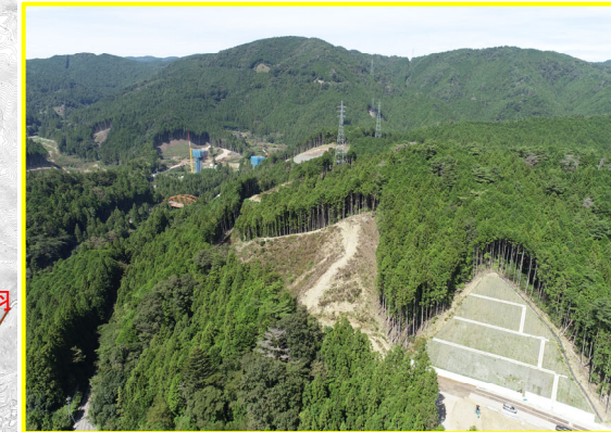
③田口地区道路建設工事(奴田工区)
