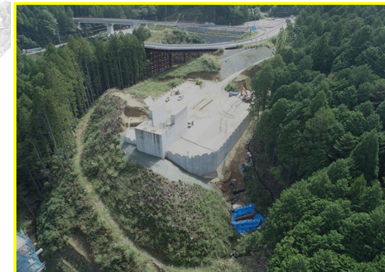
③田口地区道路建設工事(田口工区)
