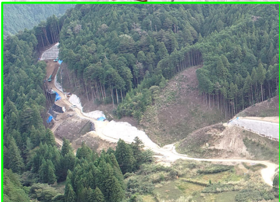
⑥大名倉地区斜面对策(遠景)
