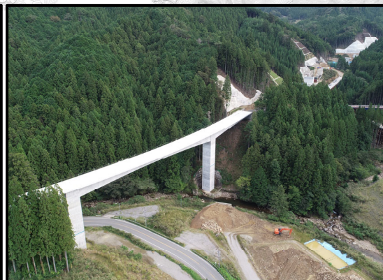
設楽根羽線1号トンネルから5号橋
