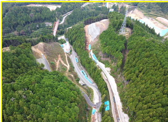
④小松地区道路建設
