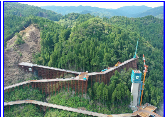
④右岸工事用道路(近景)
