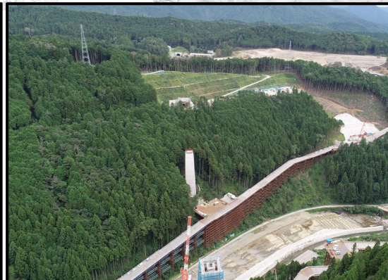
瀬戸設楽線5号橋から5号トンネル
