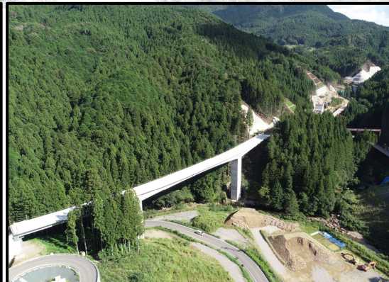
設楽根羽線1号トンネルから5号橋
