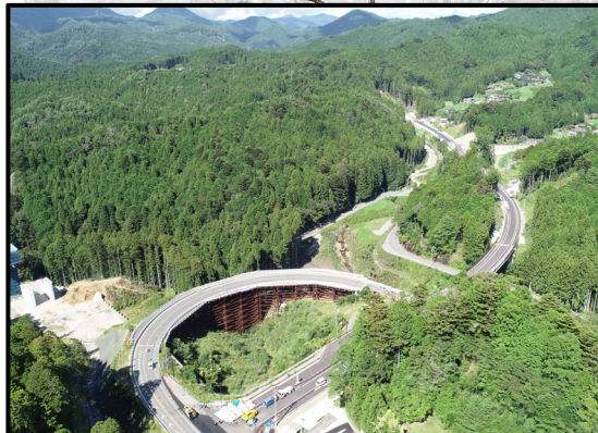
設楽根羽線起点から1号トンネル
