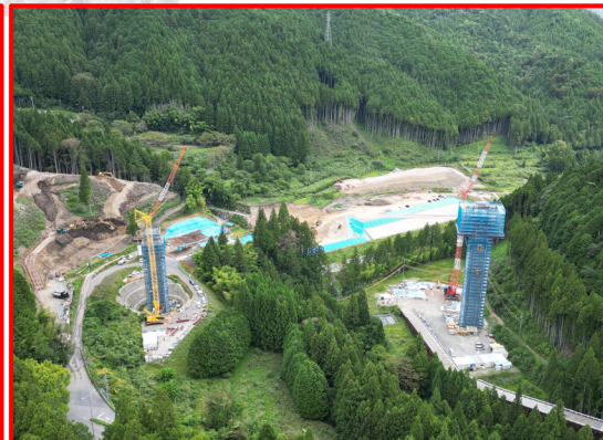
⑤4号橋PC上部工
