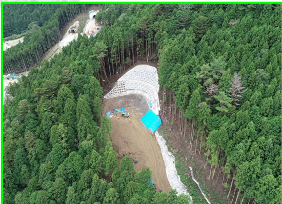
⑦大名倉地区斜面对策(近景)
