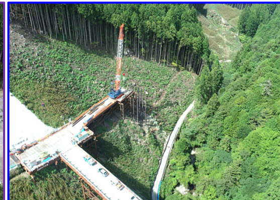
②松戸地区工事用進入路
