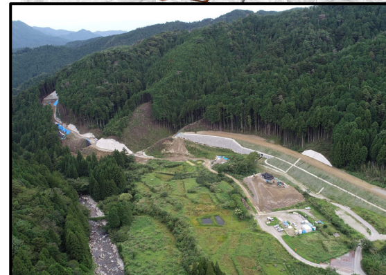
瀬戸設楽線土工3工区から5号橋
