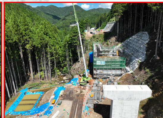
③3号橋右岸下部工(起点側)
