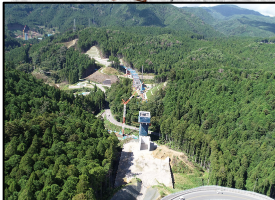
257号起点から設楽大橋
