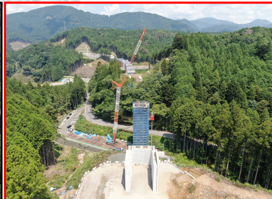
①1号橋PC上部工(起点側より)
