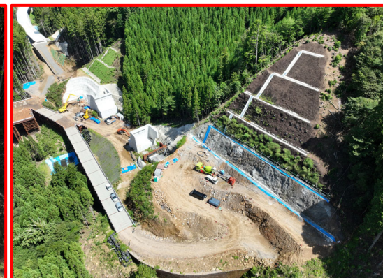
③3号橋右岸下部工(終点側)
