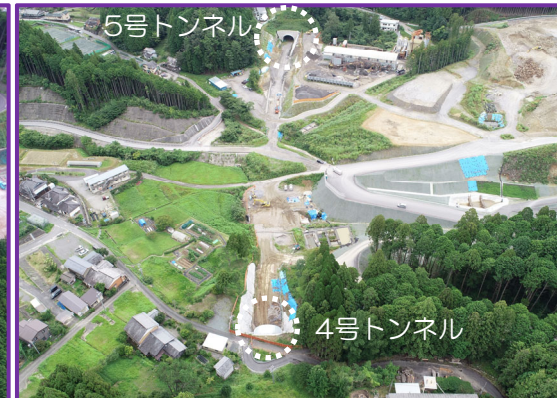
⑤4号トンネル(土工10工区遠景)
