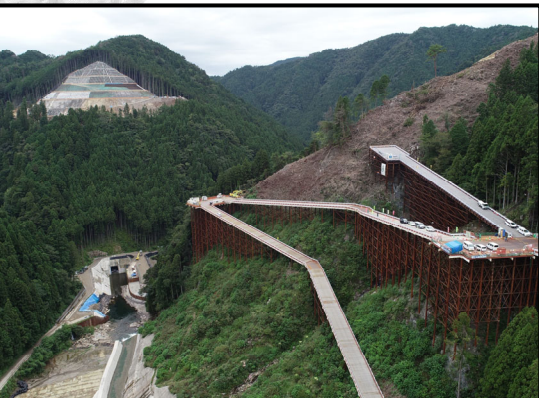
ダム本体施工箇所
