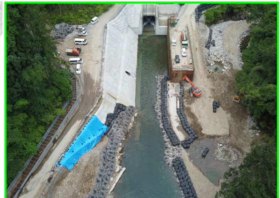
①堤外仮排水路 (呑口側)
