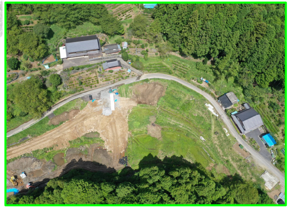
⑧延坂地区盛土整備(小松工区)
