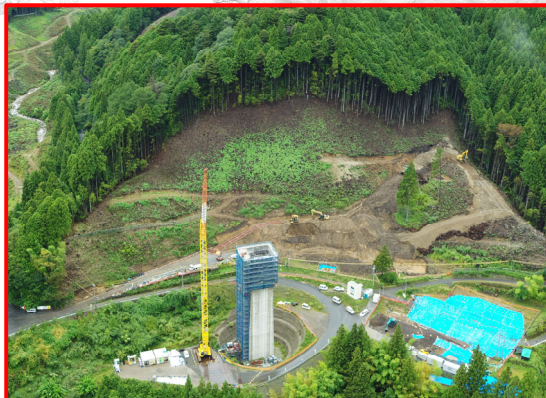
④4号橋下部工
