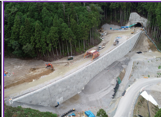
①瀬戸設楽線トンネル (土工4工区)
