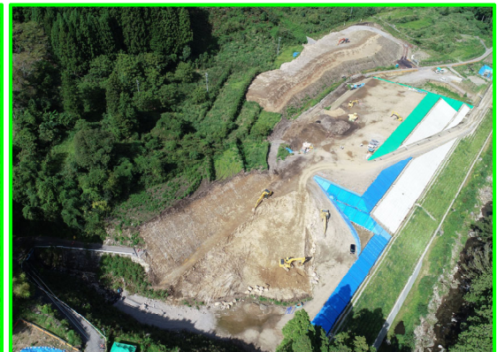
⑧延坂地区盛土整備(延坂工区)
