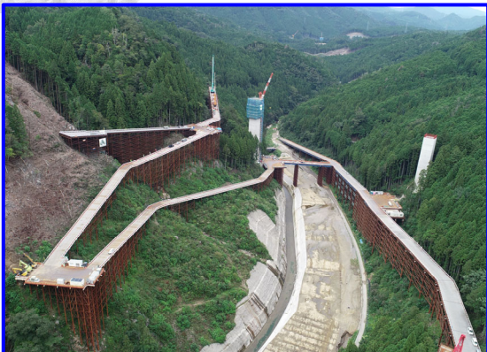
④右岸工事用道路(遠景)
