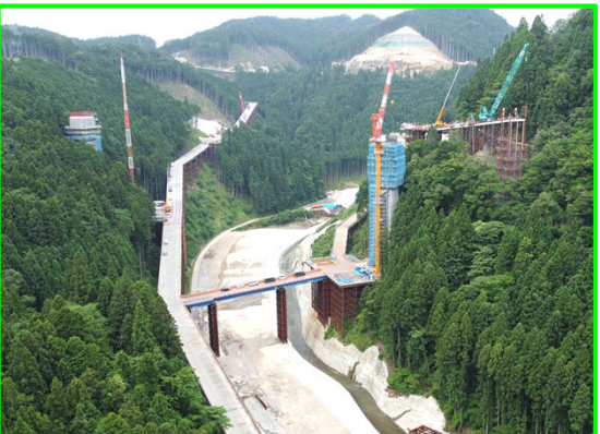
①堤外仮排水路 (遠景)
