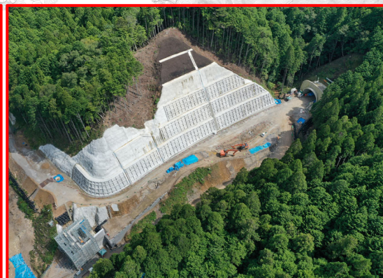
②3号橋左岸下部工(終点側より)
