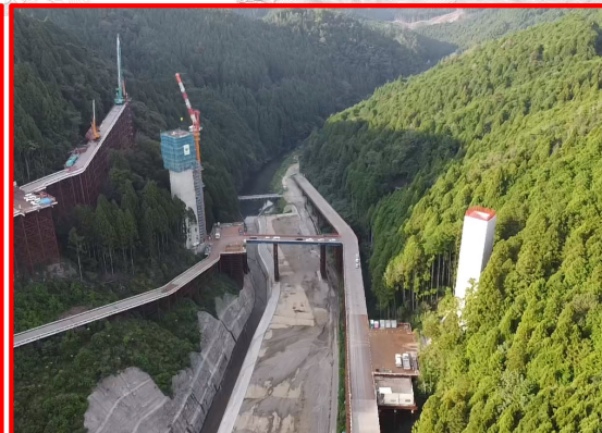
④5号橋下部工(遠景)
