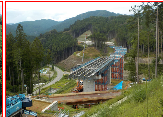
②2号橋鋼上部工
