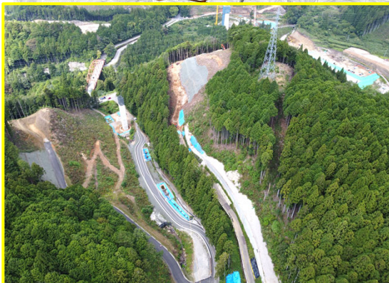
③小松地区道路建設
