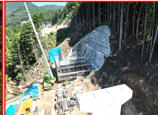
③3号橋右岸下部工(起点側)
