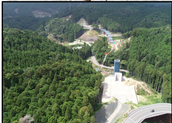
257号起点から設楽大橋
