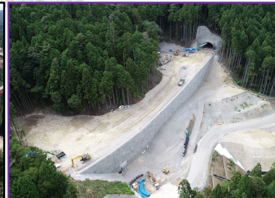
①瀬戸設楽線トンネル (土工4工区)
