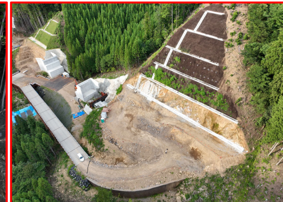
③3号橋右岸下部工(終点側)
