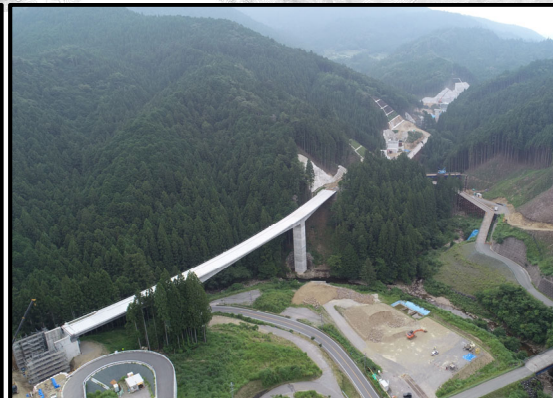
設楽根羽線1号トンネルから5号橋
