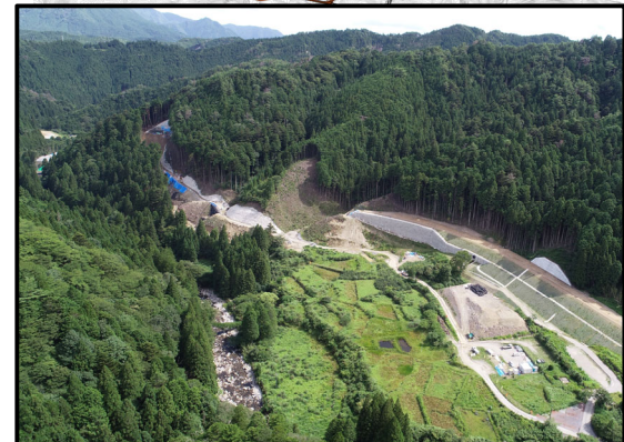
瀬戸設楽線土工3工区から5号橋
