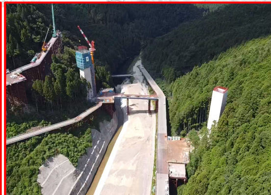
④5号橋下部工(遠景)
