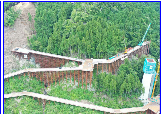
④右岸工事用道路(近景)
