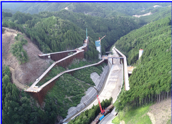
④右岸工事用道路(遠景)
