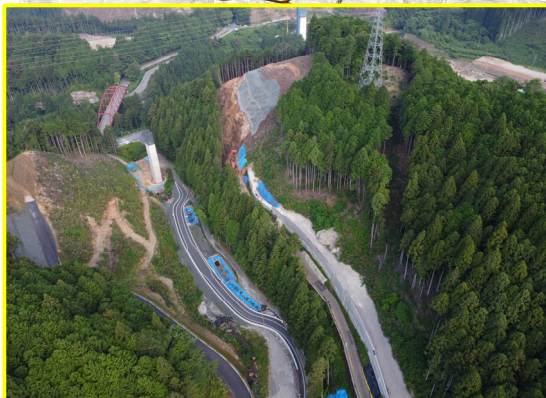
③小松地区道路建設
