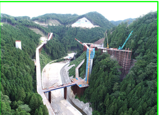
①堤外仮排水路 (遠景)
