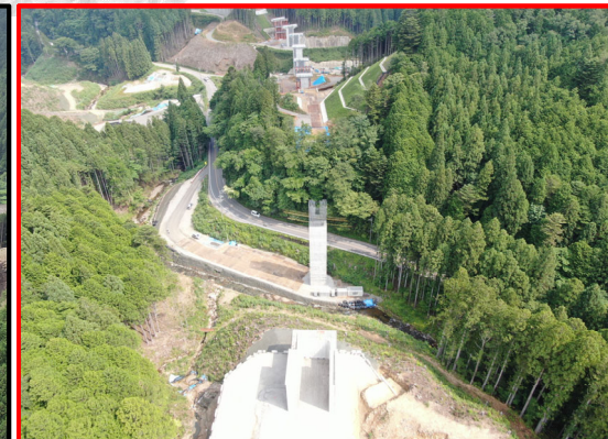
①1号橋PC上部工(起点側より)
