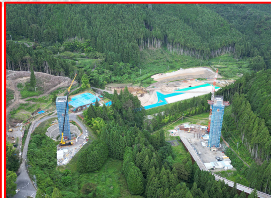
⑤4号橋PC上部工
