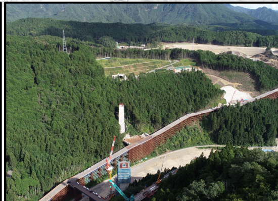
瀬戸設楽線5号橋から5号トンネル
