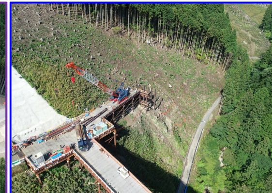
②松戸地区工事用進入路
