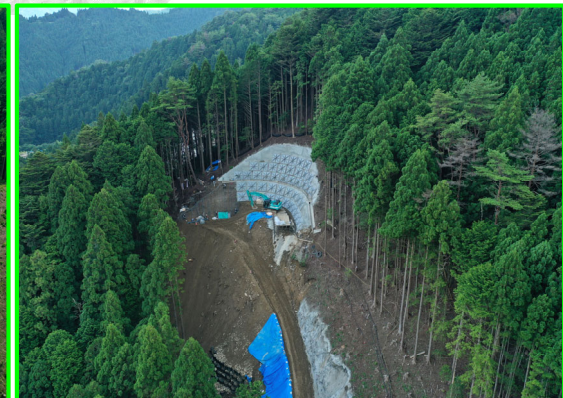
⑦大名倉地区斜面对策(近景)
