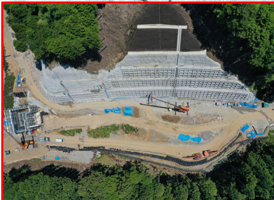
②3号橋左岸下部工(真上)
