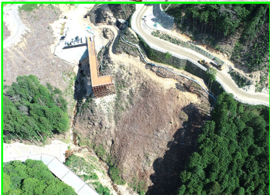
⑥清崎地区貯水池斜面对策
