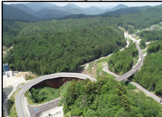
設楽根羽線起点から1号トンネル
