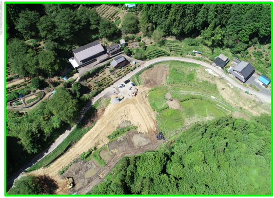
⑧延坂地区盛土整備(小松工区)
