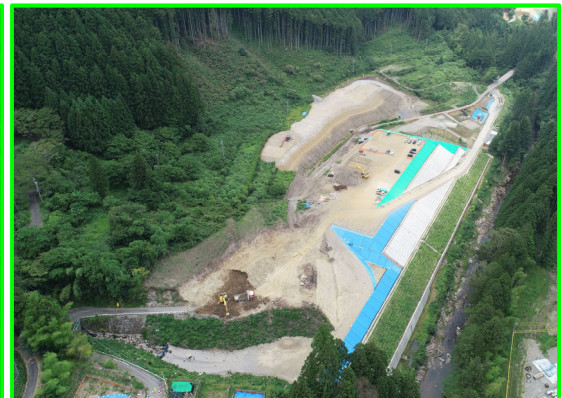
⑧延坂地区盛土整備(延坂工区)
