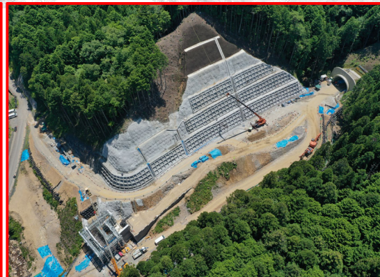
②3号橋左岸下部工(終点側より)
