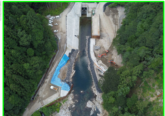
①堤外仮排水路 (呑口側)
