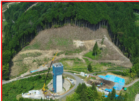
④4号橋下部工
