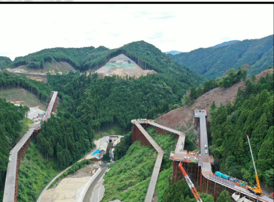
ダム本体施工箇所
