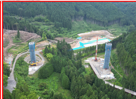
⑥4号橋PC上部工
