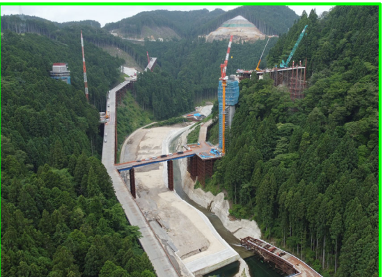
① 堤外仮排水路 (遠景)
