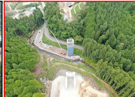
①1号橋PC上部工(起点側より)
