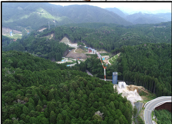
257号起点から設楽大橋
