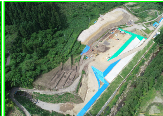
⑨延坂地区盛土整備
