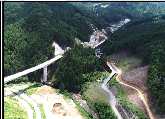
設楽根羽線1号トンネルから5号橋
