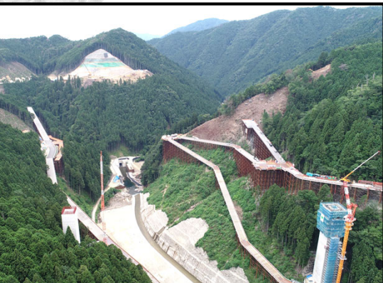
ダム本体施工箇所
