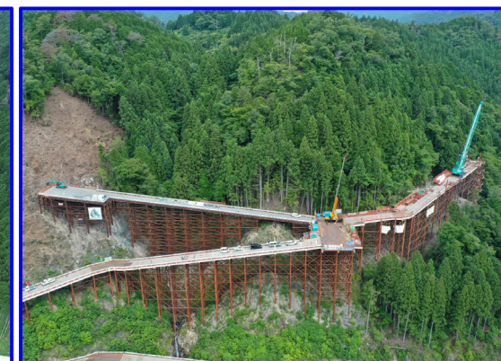
④右岸工事用道路(近景)
