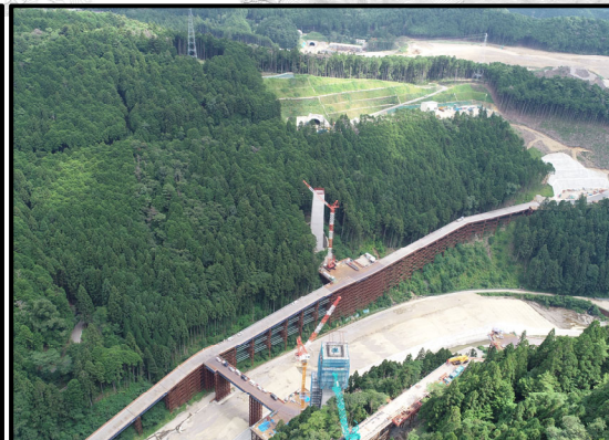
瀬戸設楽線5号橋から5号トンネル
