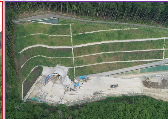
⑤4号トンネル(起点側)
