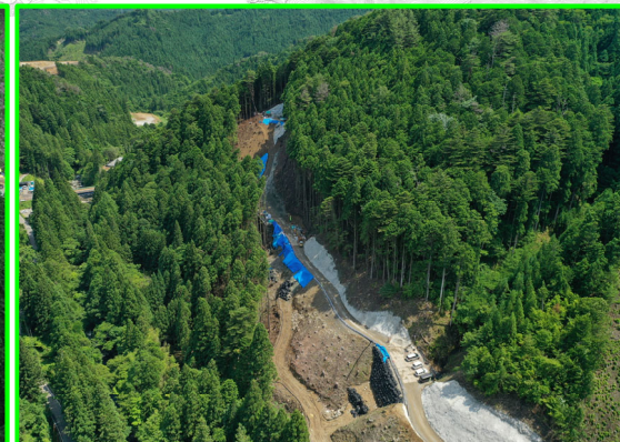
⑧大名倉地区斜面对策(遠景)
