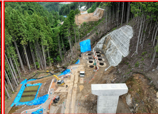
③3号橋右岸下部工(起点側)
