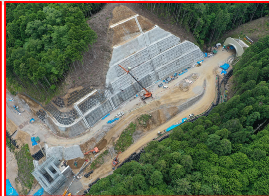
②3号橋左岸下部工(終点側より)
