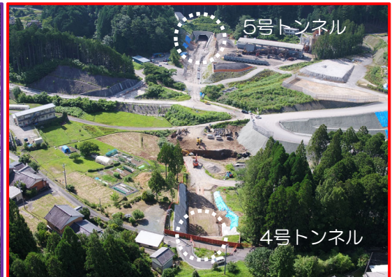
⑤4号トンネル(土工10工区)
