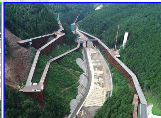
④右岸工事用道路(遠景)
