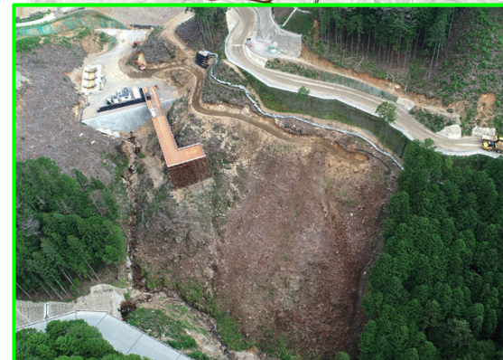
⑦清崎地区貯水池斜面对策
