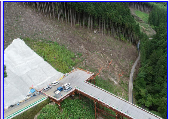
②松戸地区工事用進入路
