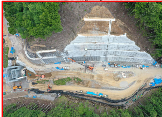
②3号橋左岸下部工(真上)
