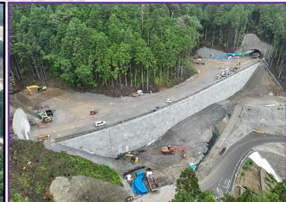
①瀬戸設楽線トンネル(土工4工区)
