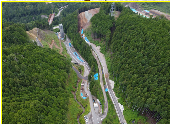
④小松地区道路建設
