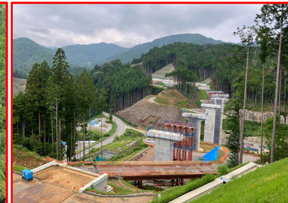
②2号橋鋼上部工
