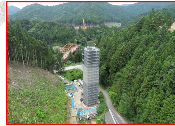
③3号橋下部工
