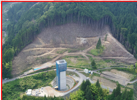
⑤4号橋下部工
