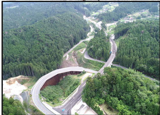
設楽根羽線起点から1号トンネル
