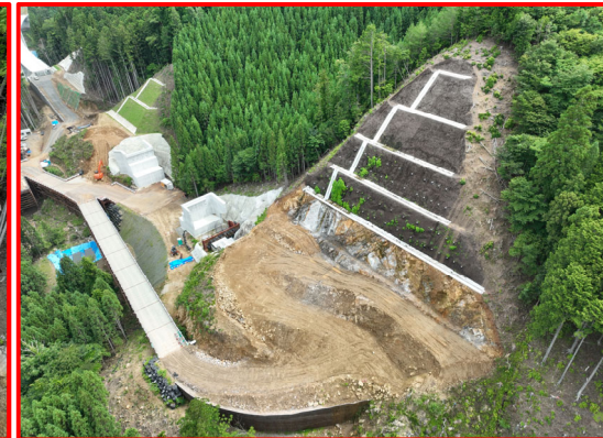
③3号橋右岸下部工(終点側)
