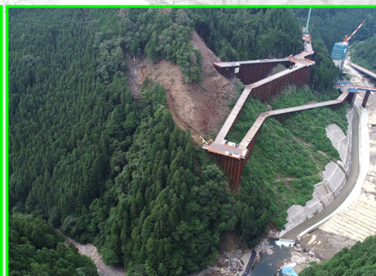
③松戸地区整備(右岸側)
