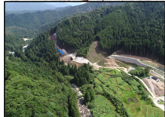
瀬戸設楽線土工3工区から5号橋
