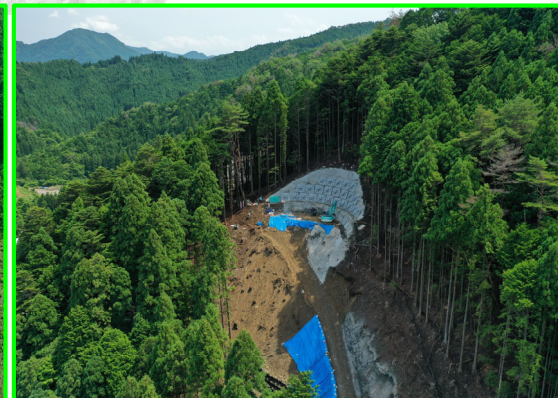
⑧大名倉地区斜面对策(近景)
