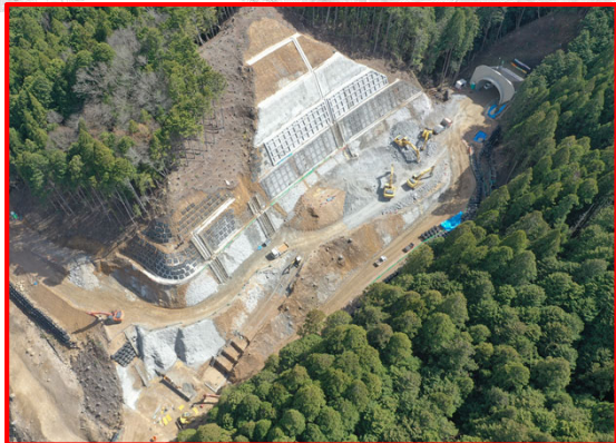
①3号橋左岸下部工(終点側より)
