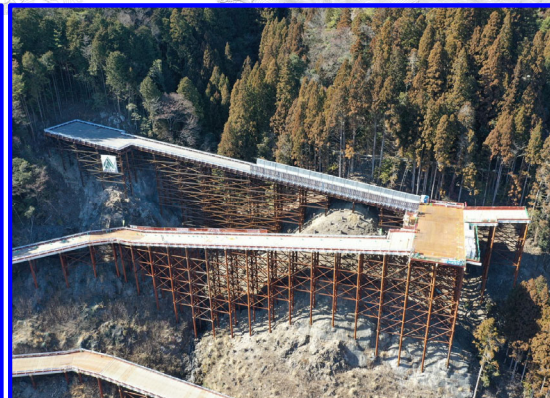
③右岸工事用道路(近景)
