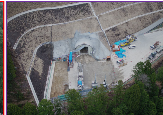
④ 4号トンネル（起点側）
