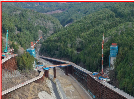
③ 5号橋下部工
