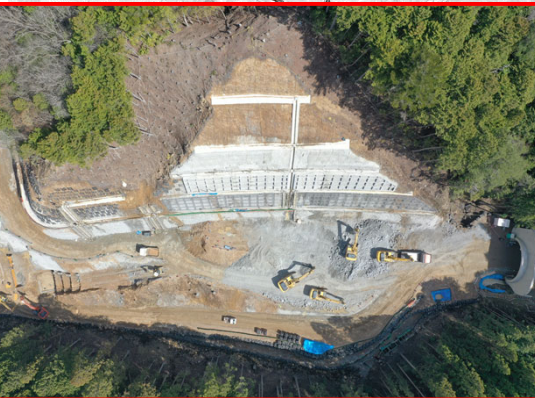
①3号橋左岸下部工(真上)
