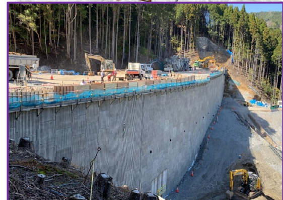
① 1号トンネル（土工4工区）
