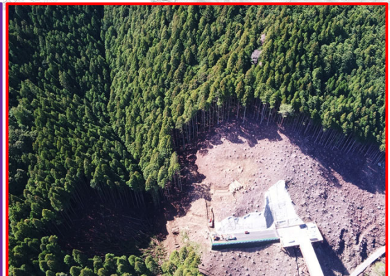
② 松戸地区橋梁下部工
