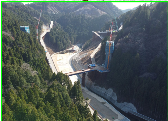
① 堤外仮排水路 (遠景)
