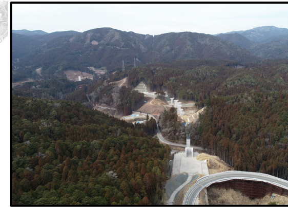
257号起点から設楽大橋
