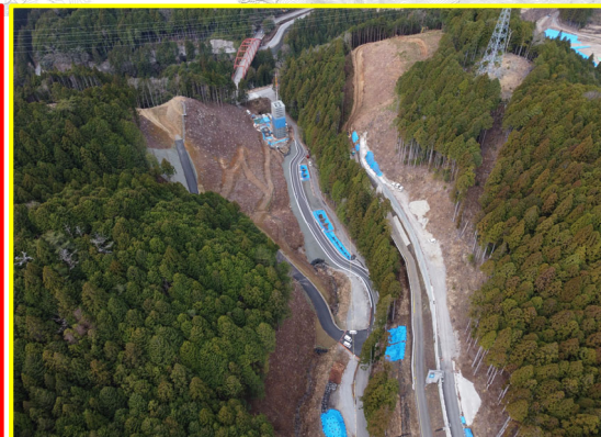
②小松地区道路建設
