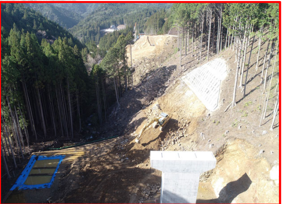
②3号橋右岸下部工(起点側)
