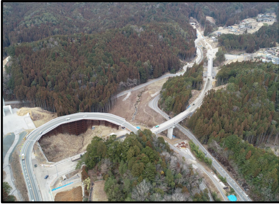
設楽根羽線起点から1号トンネル
