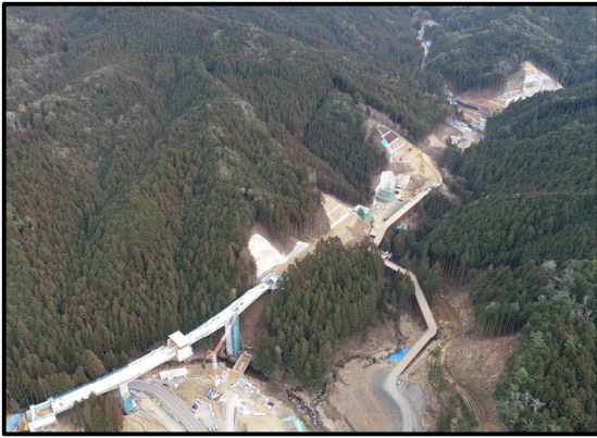
設楽根羽線5号橋から1号トンネル
