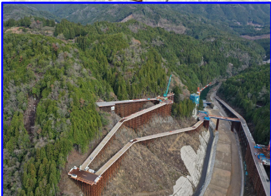
③右岸工事用道路(遠景)
