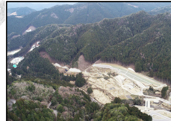
瀬戸設楽線土工3工区から5号橋
