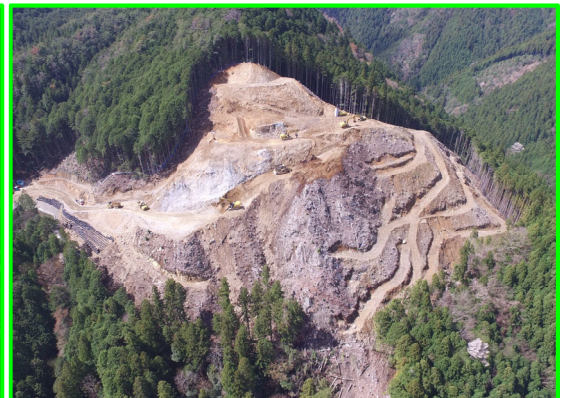
② 左岸頂部掘削
