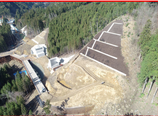
②3号橋右岸下部工(終点側)
