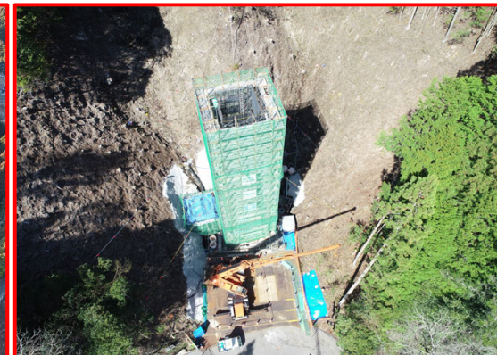
④川向地区橋梁下部工
