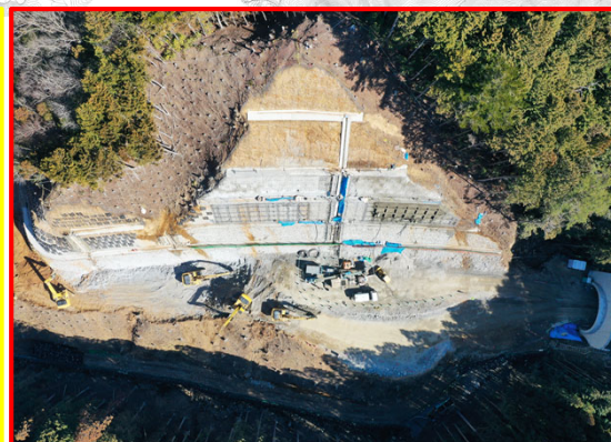
② 3号橋左岸下部工
