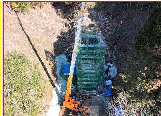
③川向地区橋梁下部工
