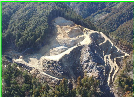
② 左岸頂部掘削
