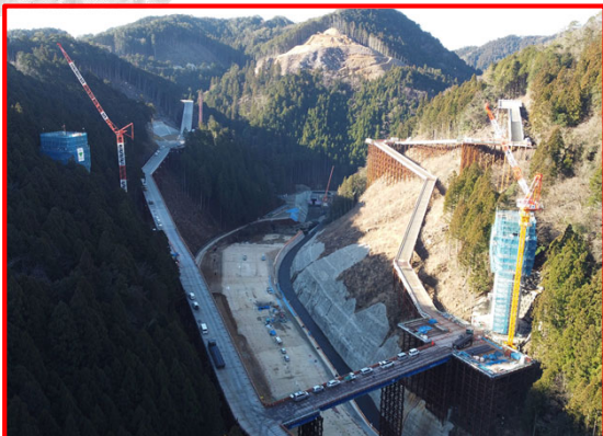
③ 5号橋下部工
