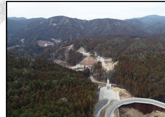
257号起点から設楽大橋
