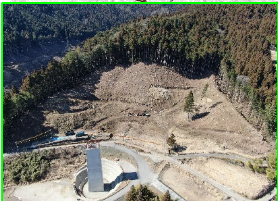
⑦R4貯水池斜面对策(川向工区)
