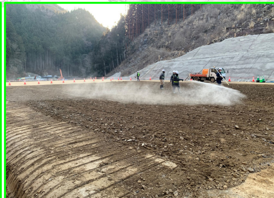
③貯水池斜面对策 (上流側より近景)
