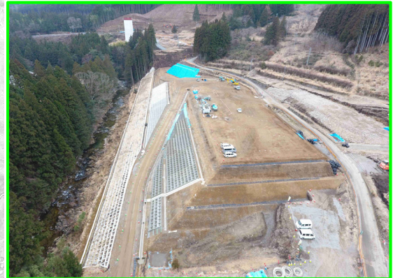
⑨延坂地区盛土(近影)
