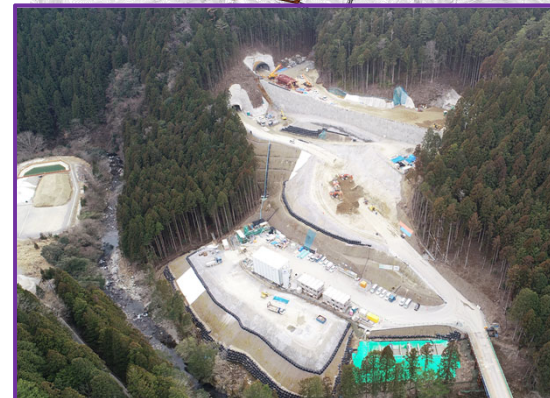
① 1号トンネル（土工4工区）
