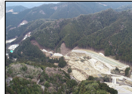
瀬戸設楽線土工3工区から5号橋
