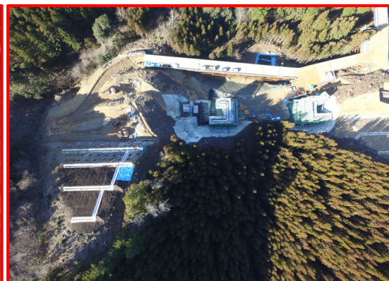
④ 4号橋下部工
