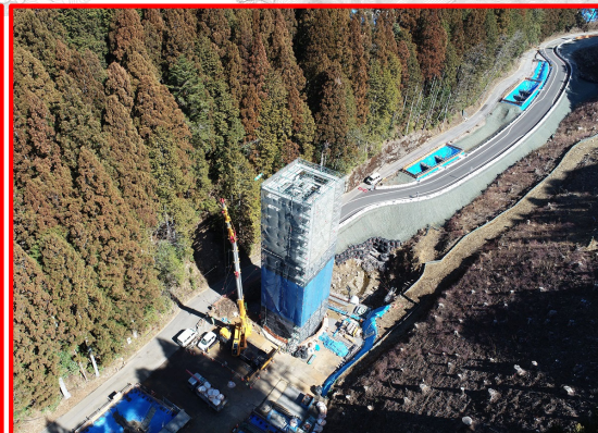
①3号橋下部工(上流方向)
