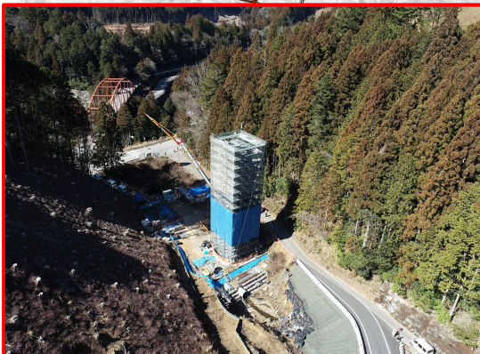
①3号橋下部工(下流方向)
