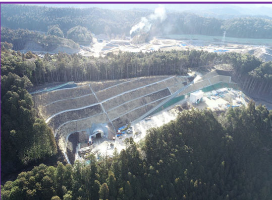
④ 4号トンネル（起点側）
