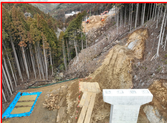
③ 3号橋右岸下部工
