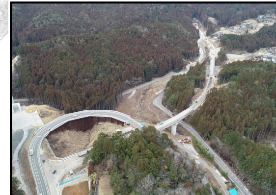
設楽根羽線起点から1号トンネル
