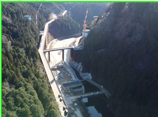
③貯水池斜面对策 (上流側より遠景)
