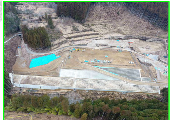
⑨延坂地区盛土(遠影)
