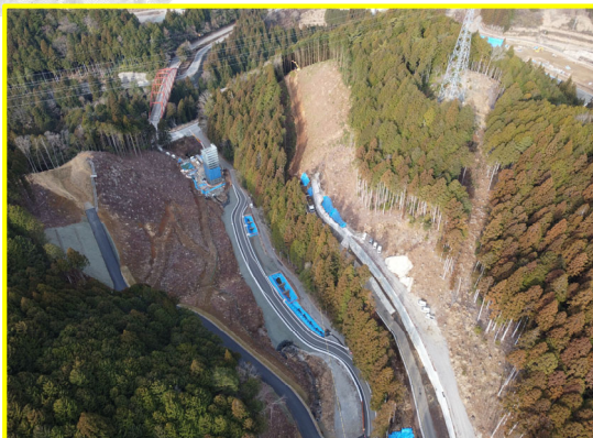
②小松地区道路建設
