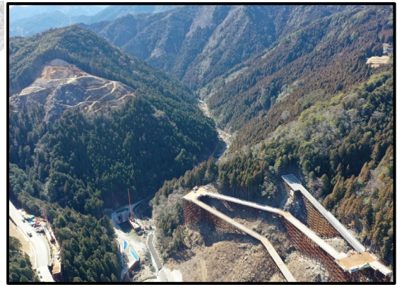
ダム本体施工箇所
