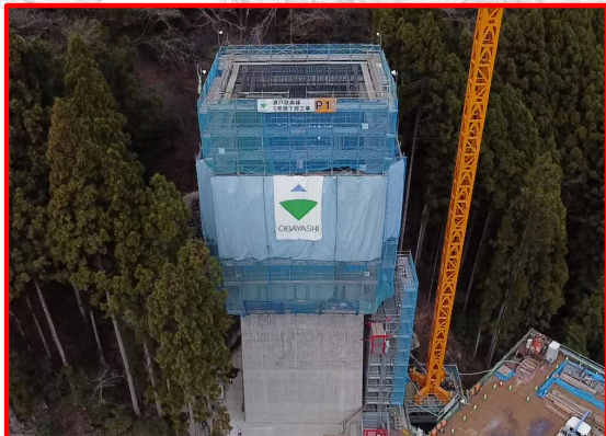
② 5号橋下部工（右岸）
