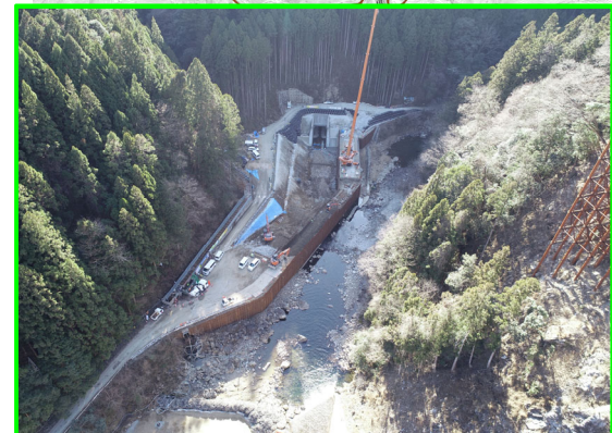
①堤外仮排水路 (呑口側)
