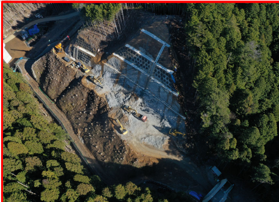
② 3号橋左岸下部工(起点側より)
