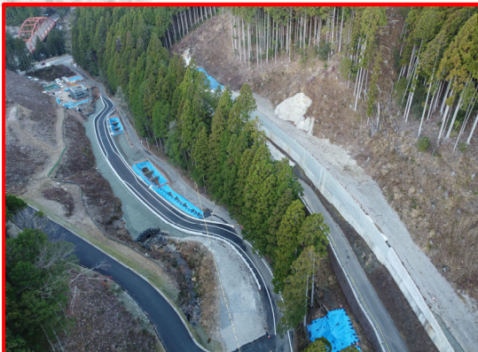
③小松地区道路建設
