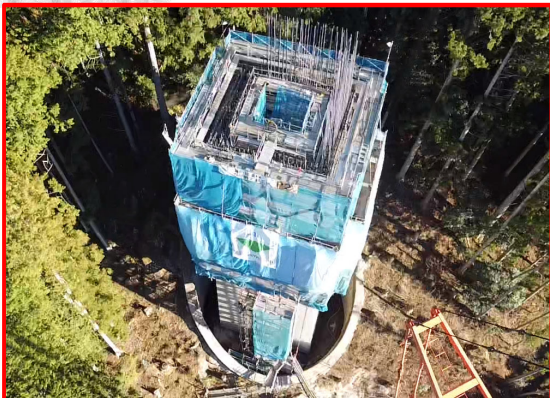
② 5号橋下部工（左岸）
