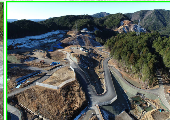
⑧清崎地区盛土
