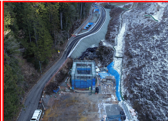
②3号橋下部工
