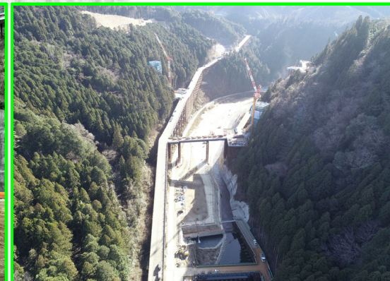
③貯水池斜面对策 (上流側より遠景)
