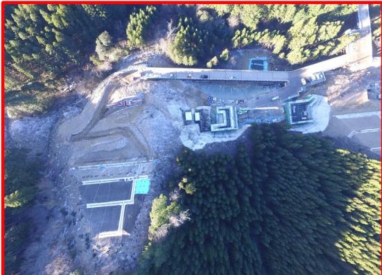
③ 4号橋下部工
