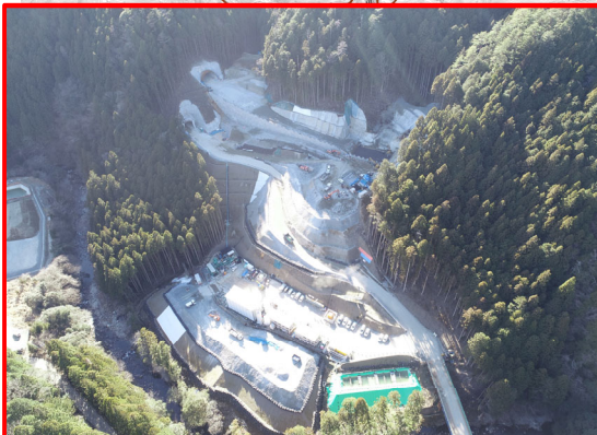
① 1号トンネル（土工4I区）
