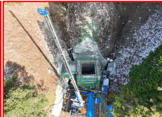
④川向地区橋梁下部工
