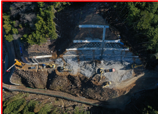
② 3号橋左岸下部工(真上)
