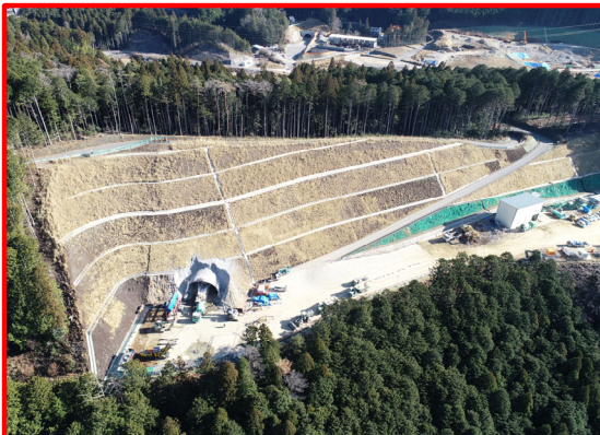
③ 4号トンネル（起点側）
