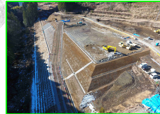
⑪延坂地区盛土
