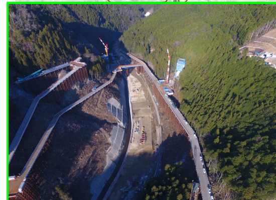
③貯水池斜面对策 (下流側より遠景)
