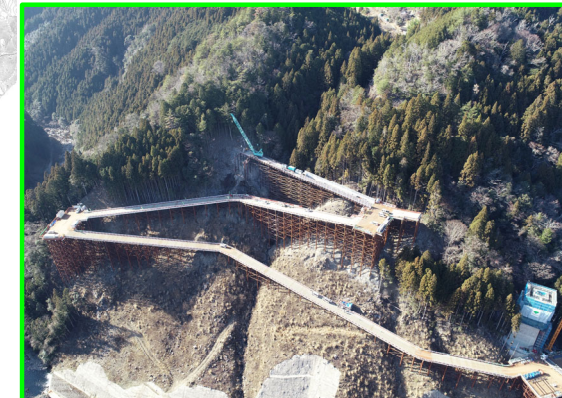
④右岸工事用道路
