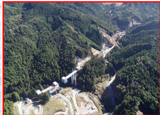
設楽根羽線5号橋から起点側
