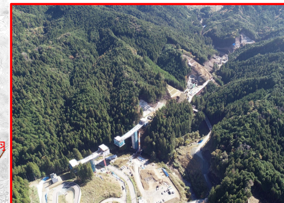
設楽根羽線5号橋から起点側
