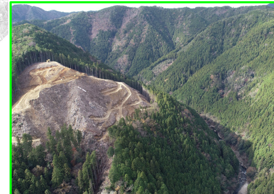
ダム本体施工箇所
