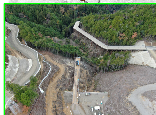
⑦R4貯水池斜面对策 (清崎工区)
