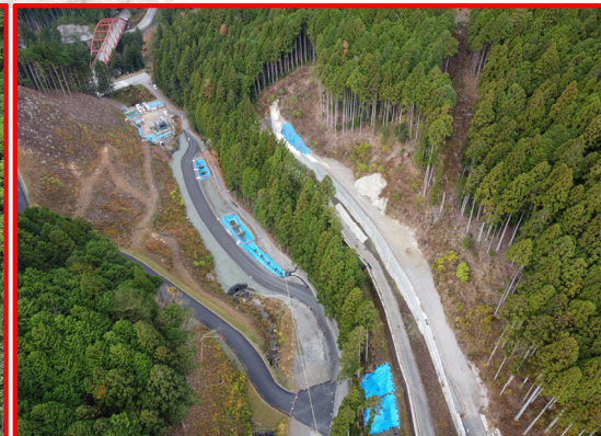
③小松地区道路建設
