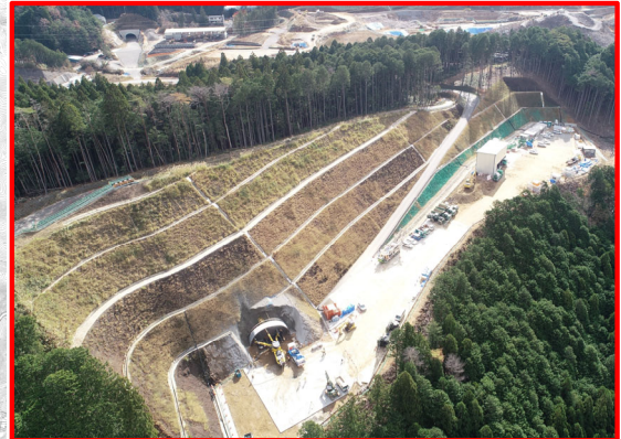
④トンネル（4号）
