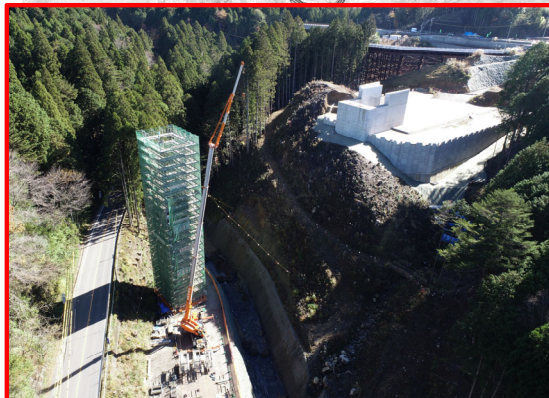
①田口地区橋梁下部工
