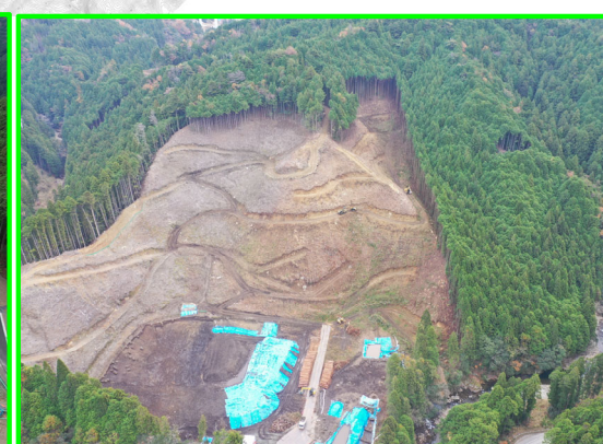
⑨大崎地区整備
