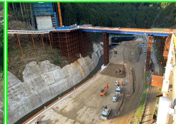
③貯水池斜面对策 (下流側より近景)
