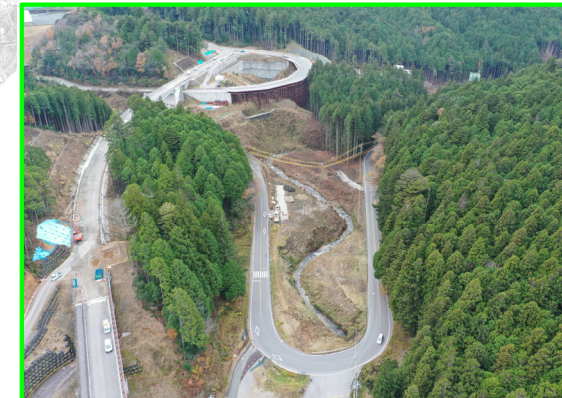
⑤田口地区整備 (田口工区)
