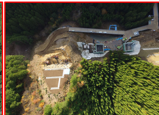
④4号橋下部工
