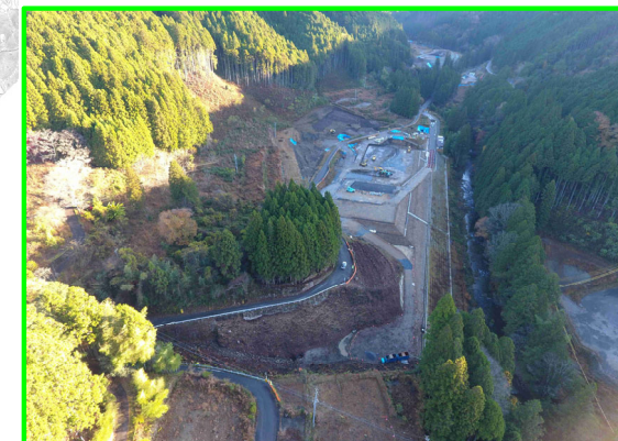
⑪延坂地区盛土
