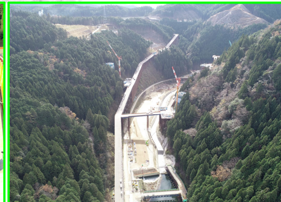
③貯水池西部斜面对策 (上流側より遠景)
