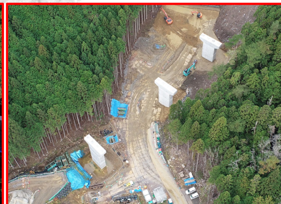
③3号橋下部工
