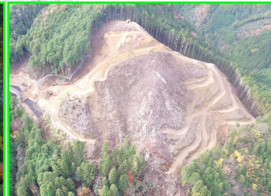
② 左岸頂部掘削
