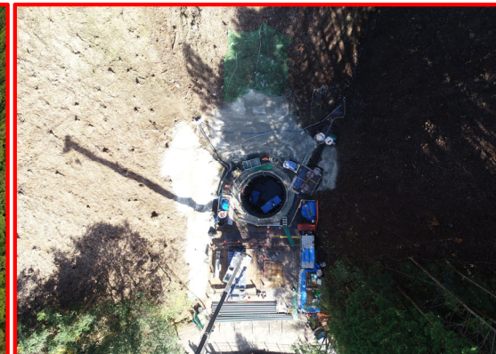
④川向地区橋梁下部工
