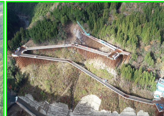
④ 右岸工事用道路
