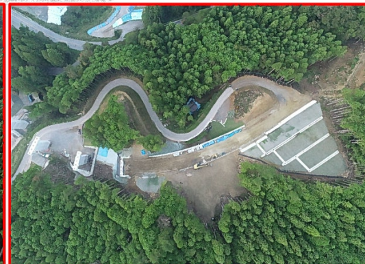
②2号橋右岸下部工
