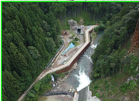
①堤外仮排水路（呑口側）
