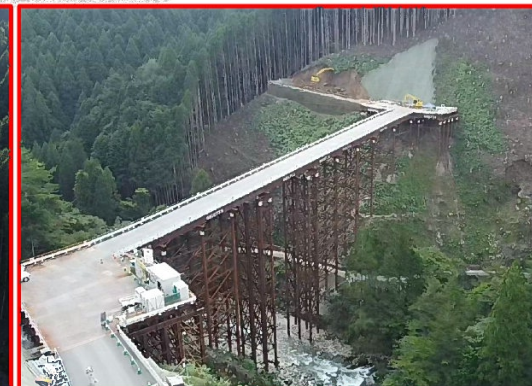
②松戸地区工事用進入路
