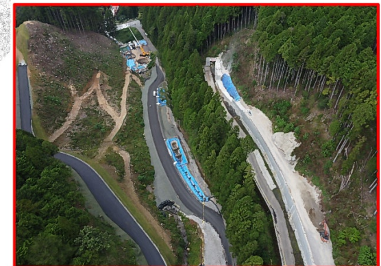
④小松地区道路建設
