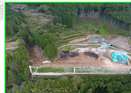
⑫延坂地区盛土
