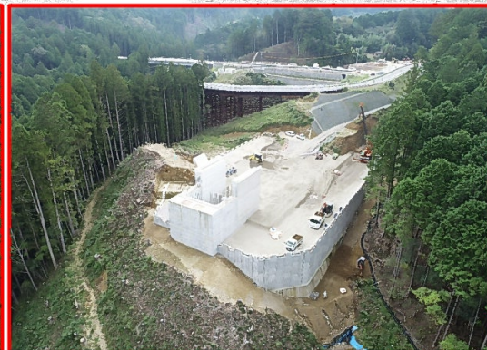
①田口地区橋梁下部工 (A1橋台)
