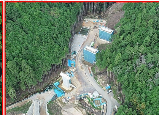
③3号橋下部工
