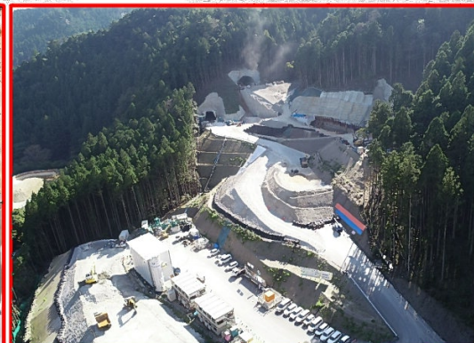
①トンネル（土工4工区）
