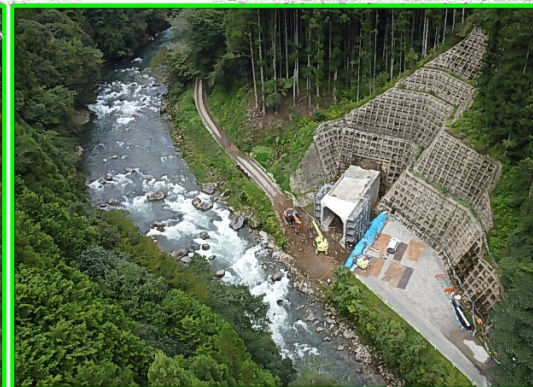
①堤外仮排水路（吐口側）
