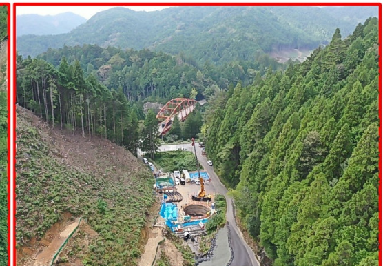
③3号橋下部工
