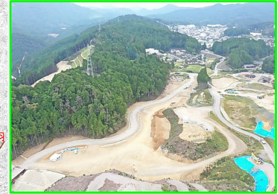
⑧清崎地区盛土
