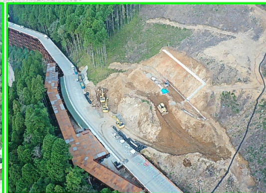
⑤田口地区整備 (田口工区)
