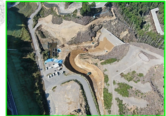
⑦R4貯水池斜面对策 (清崎工区)
