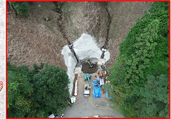
⑤川向地区橋梁下部工
