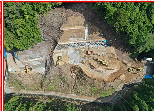
②3号橋左岸下部工
