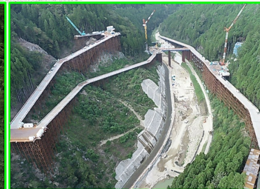
③貯水池斜面对策（下流側より）
