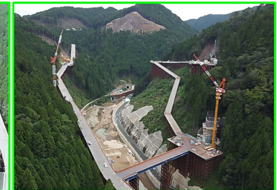
③貯水池斜面对策（上流側より）
