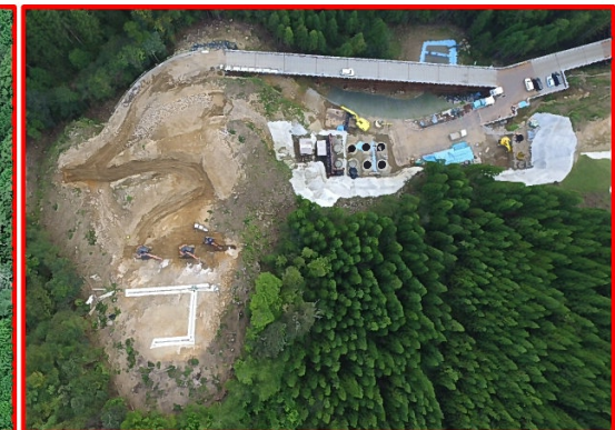
④4号橋下部工
