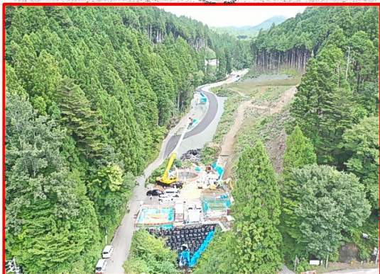
④3号橋下部工
