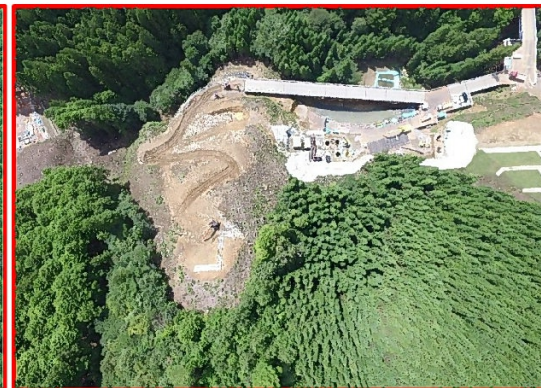
④4号橋下部工
