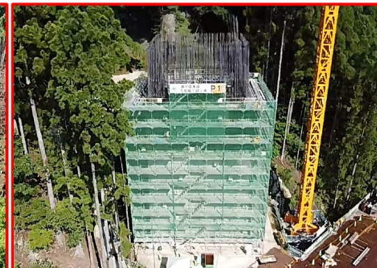
④5号橋下部工（右岸）
