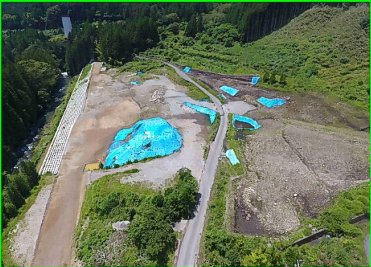
⑨延坂地区盛土
