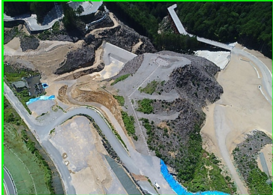
⑥R4貯水池斜面対策(清崎工区)
