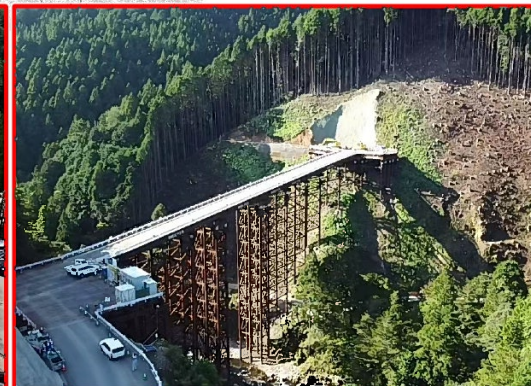
③松戸地区工事用進入路
