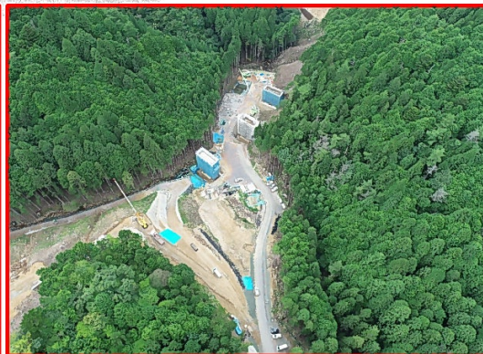
③3号橋下部工
