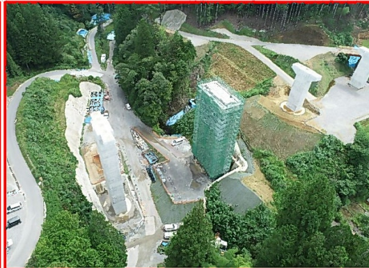
② 添沢地区橋梁下部工
