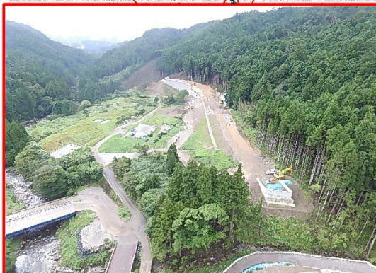
①大名倉地区道路建設
