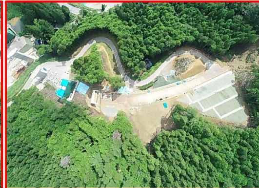
③ 2号橋右岸下部工
