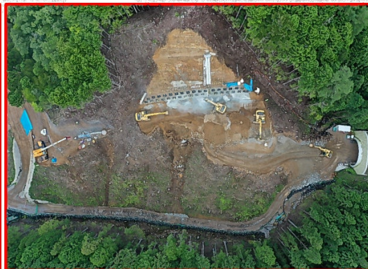
②3号橋左岸下部工
