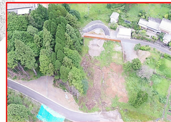
⑤トンネル（4号）
