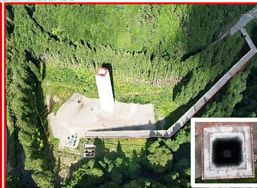
⑥ 4号橋左岸下部工
