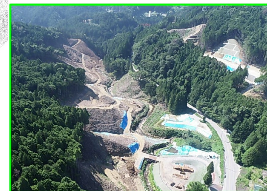
⑤貯水池西部整備(大崎工区)
