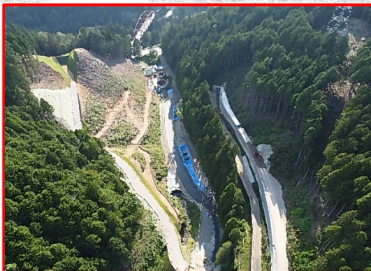
⑤小松地区道路建設
