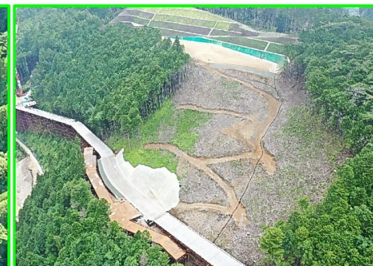
④田口地区整備工事
