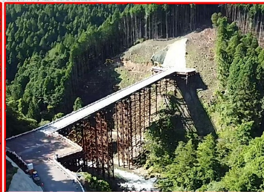
③松戸地区工事用進入路
