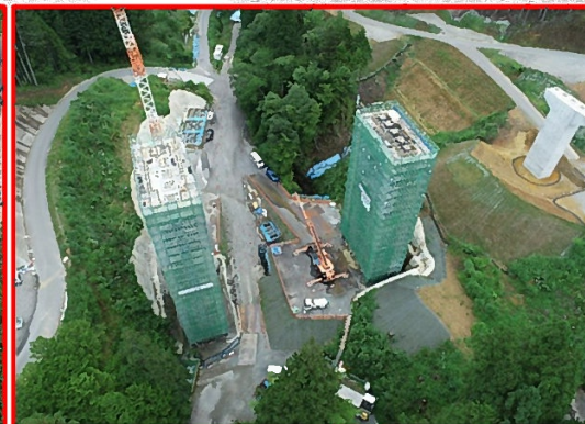
②添沢地区橋梁下部工
