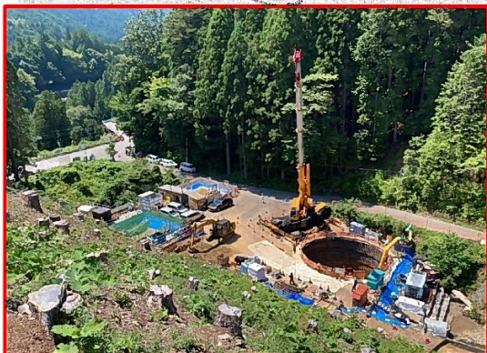
④ 3号橋下部工
