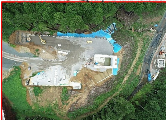
①田口地区下部工
