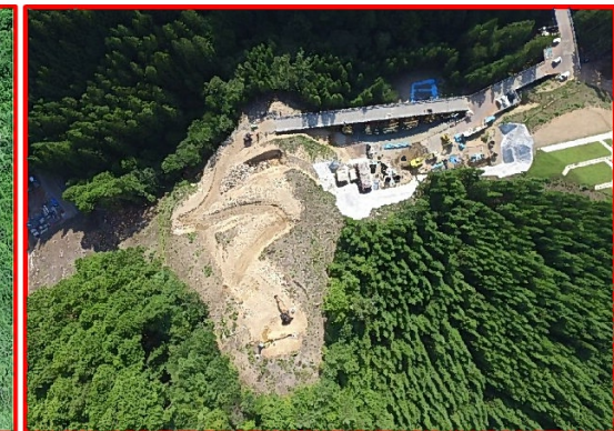
④4号橋下部工
