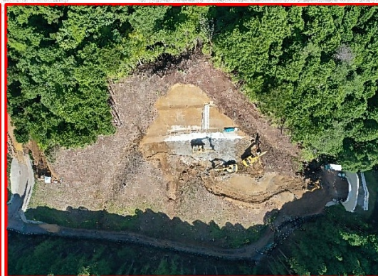
②3号橋左岸下部工
