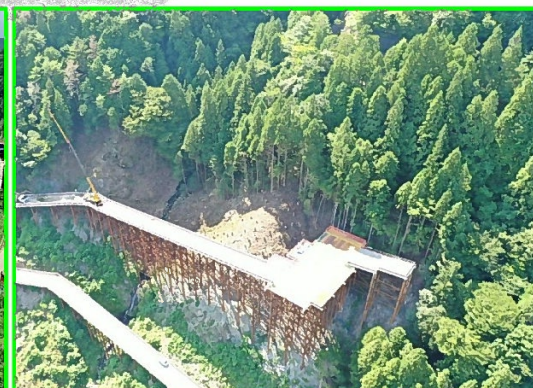
③右岸工事用道路
