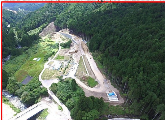
①大名倉地区道路建設
