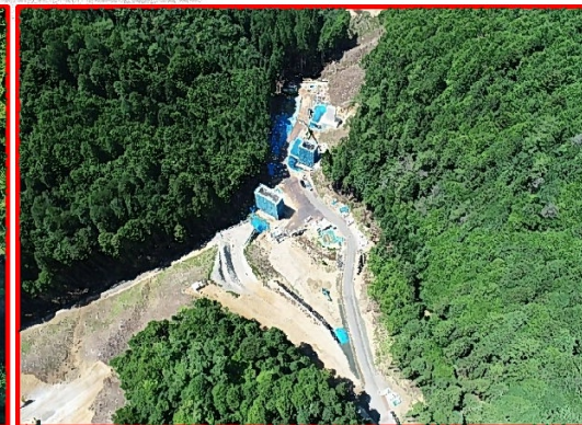
③3号橋下部工
