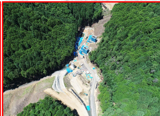
②3号橋下部工
