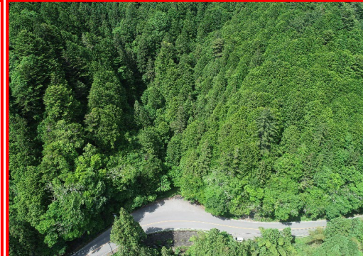
⑦川向地区下部工
