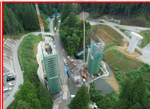
②添沢地区橋梁下部工
