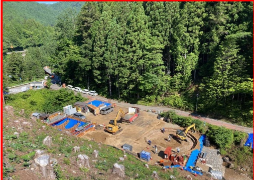
④3号橋下部工
