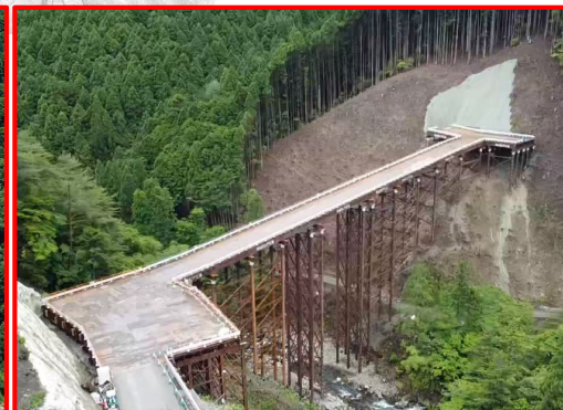
③松戸地区工事用進入路
