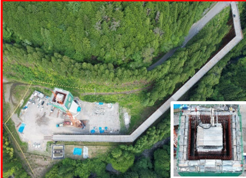
⑥4号橋左岸下部工
