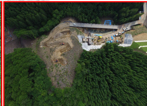
③4号橋下部工
