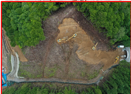
①3号橋左岸下部工
