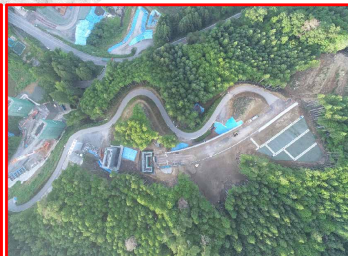
③2号橋右岸下部工
