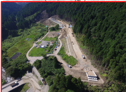
①大名倉地区道路建設
