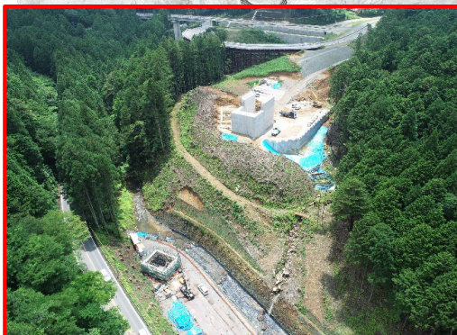
①田口地区下部工
