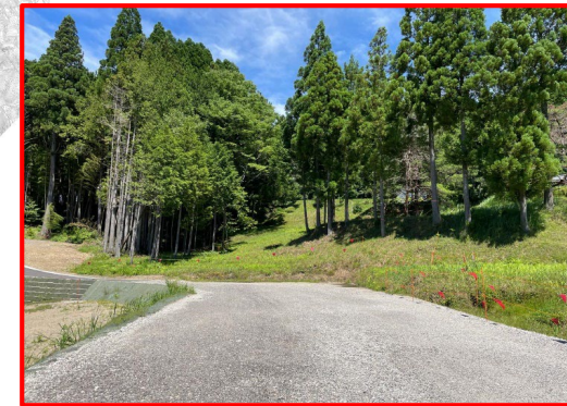
⑤トンネル (4号)
