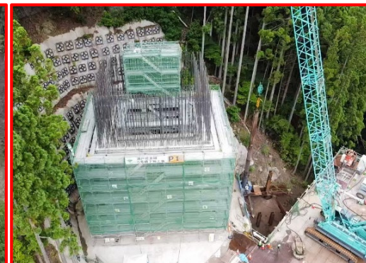
④5号橋下部工 (右岸)
