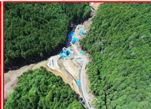
②3号橋下部工
