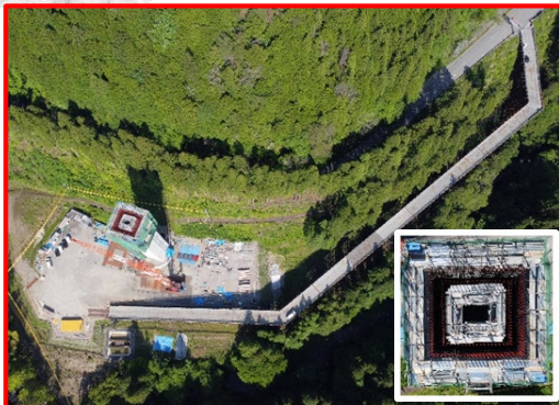
⑥4号橋左岸下部工
