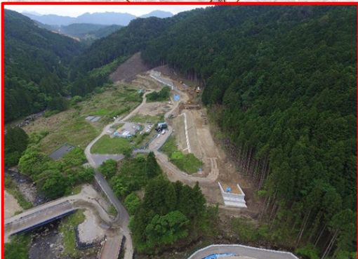
①大名倉地区道路建設
