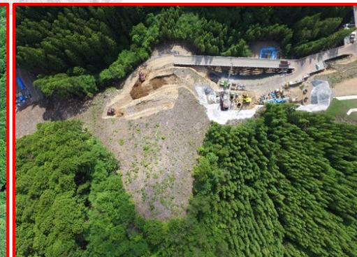
③4号橋下部工
