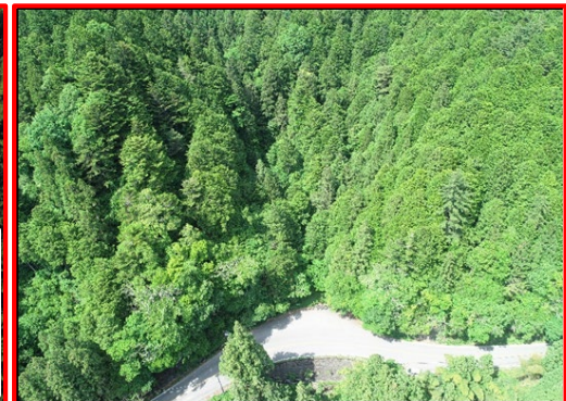
⑦川向地区下部工
