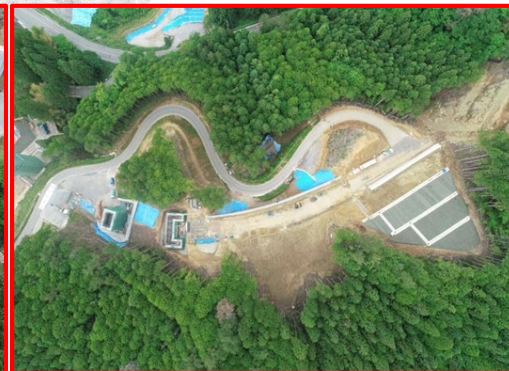
③2号橋右岸下部工
