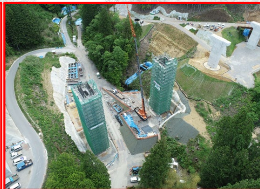
②添沢地区橋梁下部工
