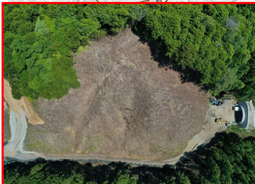
①3号橋左岸下部工
