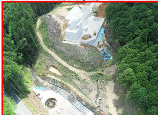
①田口地区下部工
