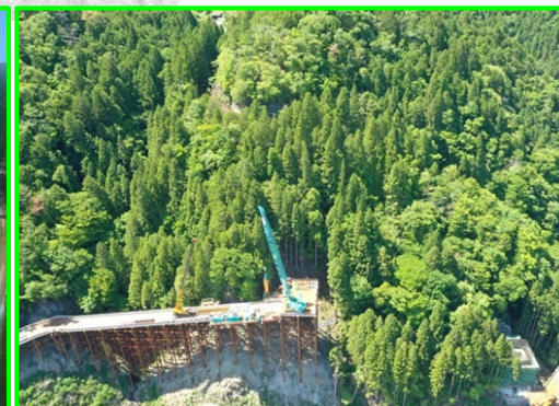
③右岸工事用道路
