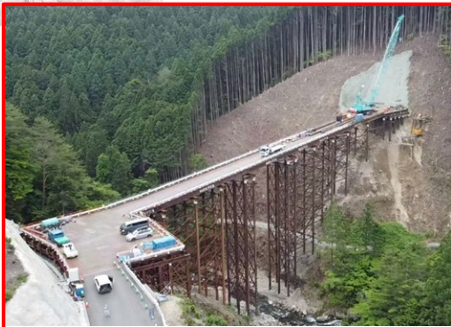
③松戸地区工事用進入路
