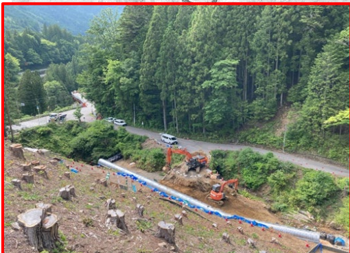
④3号橋下部工
