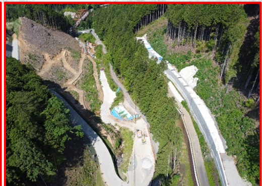
⑤小松地区道路建設
