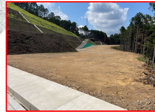
⑤トンネル (4号)
