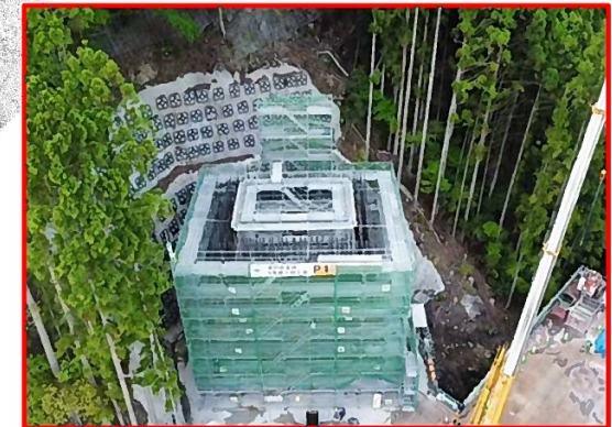
⑤5号橋下部工（右岸）
