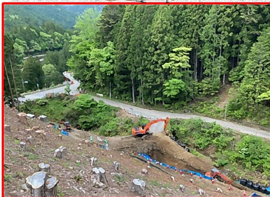
③ 3号橋下部工
