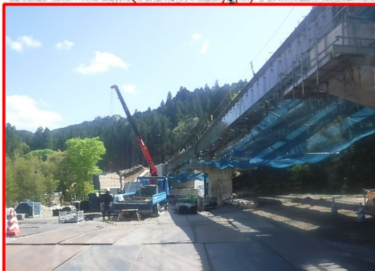
①瀬戸設楽線1号橋上部工
