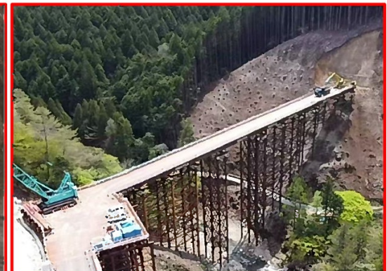
④松戸地区工事用進入路
