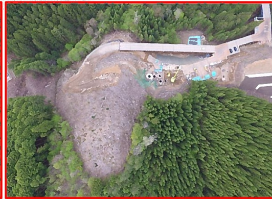
③4号橋下部工
