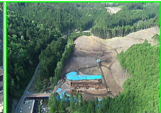
④貯水池西部整備
