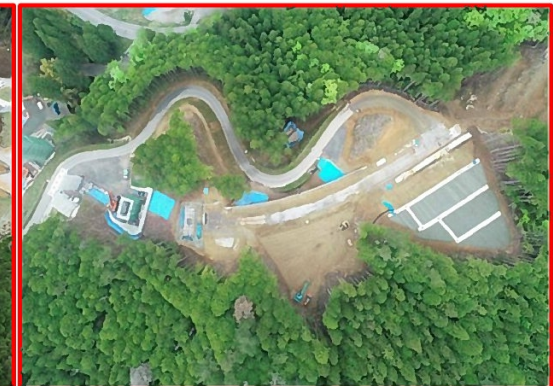
④2号橋右岸下部工
