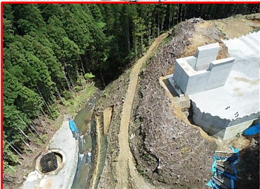
①田口地区下部工
