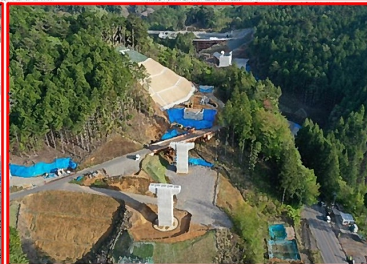
②2号橋左岸下部工
