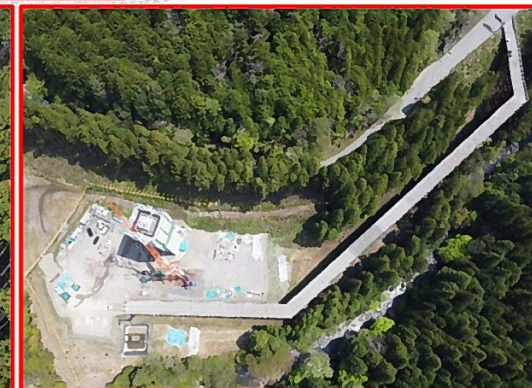
⑦ 4号橋左岸下部工
