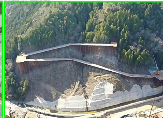
③右岸工事用道路
