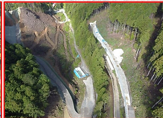
⑥ 小松地区道路建設
