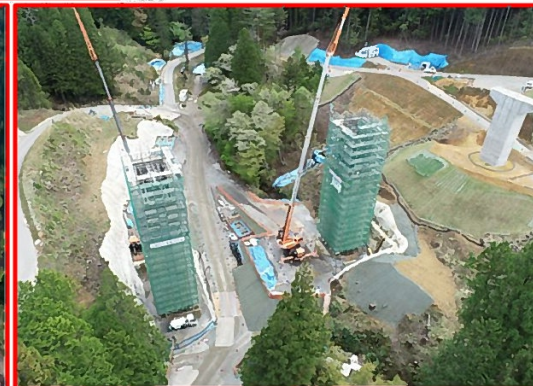
③添沢地区橋梁下部工
