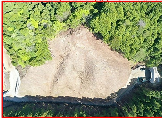
①3号橋左岸下部工
