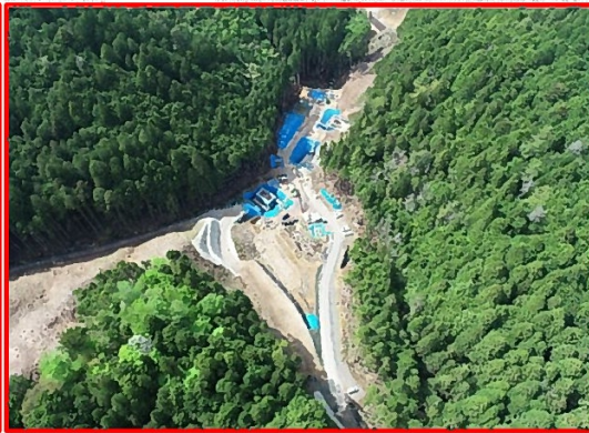
②3号橋下部工
