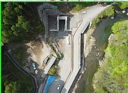
①堤外仮排水路
