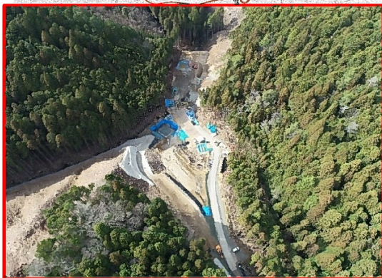
①3号橋下部工
