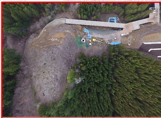
②4号橋下部工
