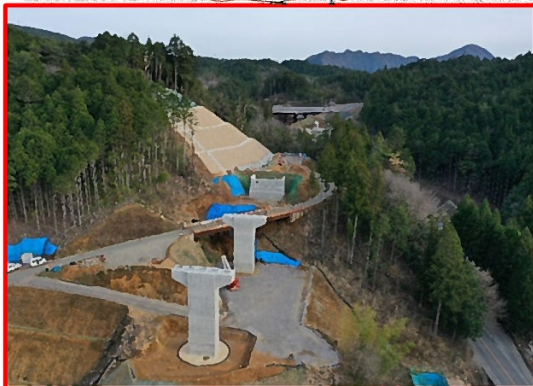
①2号橋左岸下部工
