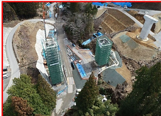
②添沢地区橋梁下部工
