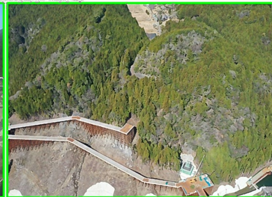
③ 右岸工事用道路
