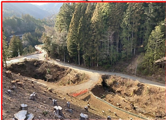
④3号橋下部工
