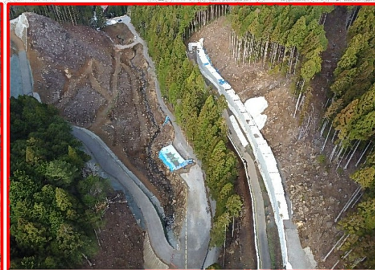
⑤小松地区道路建設
