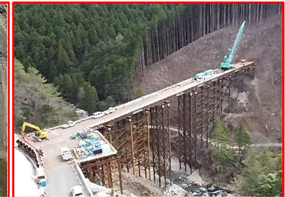
④松戸地区工事用進入路
