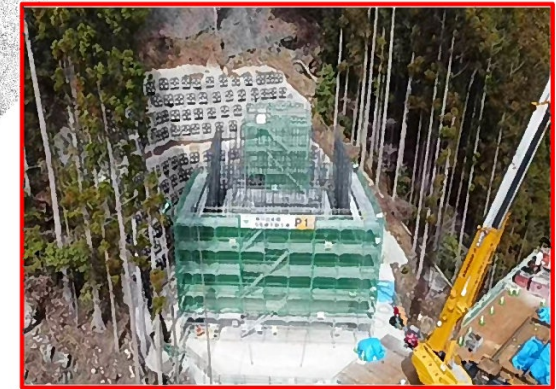
⑤5号橋下部工(右岸)
