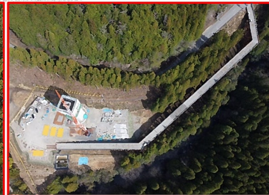
⑥4号橋左岸下部工
