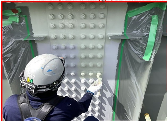
①瀬戸設楽線1号橋上部工
