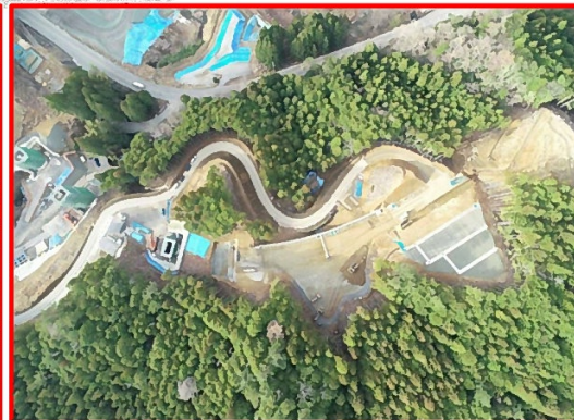
③2号橋右岸下部工
