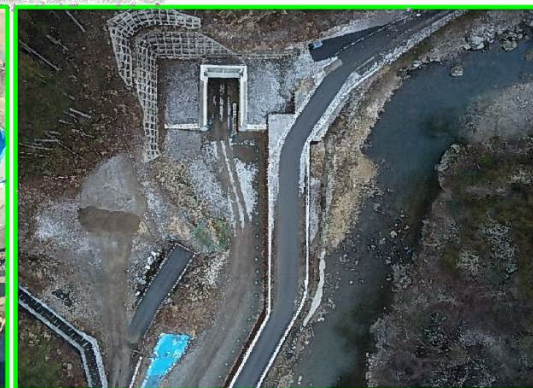
③ 堤外仮排水路工事
