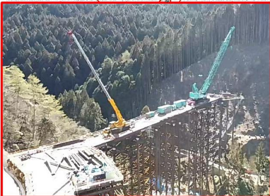
④松戸地区工事用進入路
