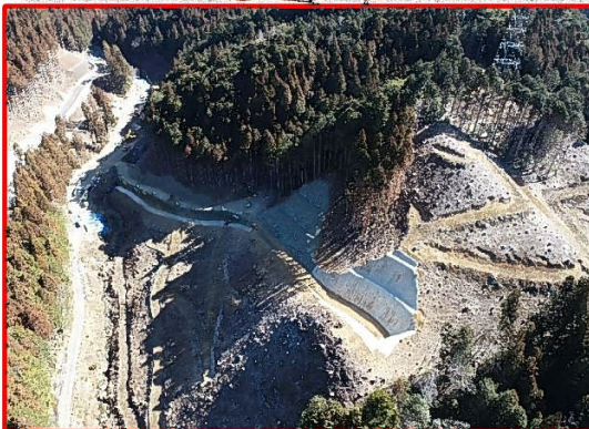
⑤双田工区道路建設
