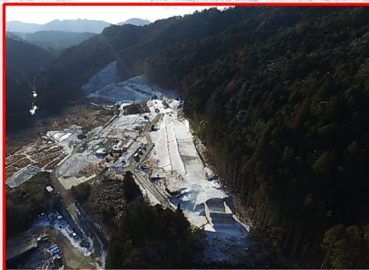
②大名倉地区工事用道路
