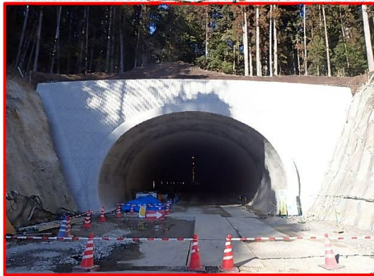
①1号トンネル
