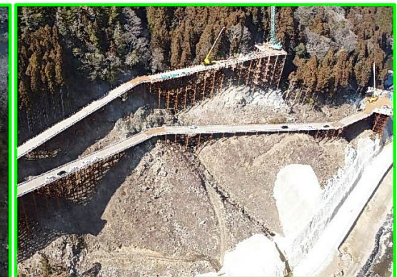
④ 右岸工事用道路
