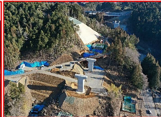
②2号橋左岸下部工
