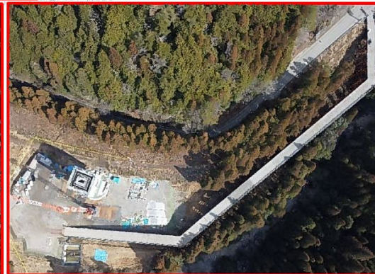
⑦4号橋左岸下部工
