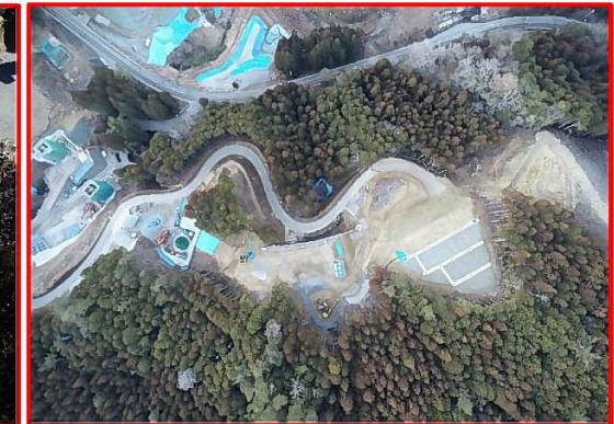
④2号橋右岸下部工
