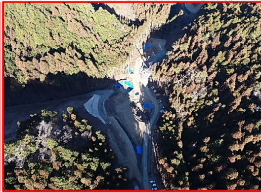
②3号橋下部工
