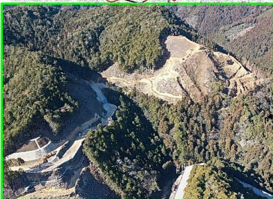
① 本体左岸掘削
