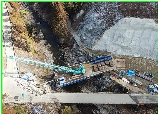
⑨工事用道路整備
