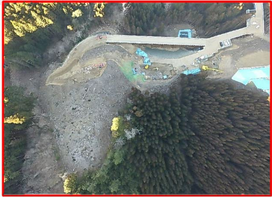
③4号橋下部工
