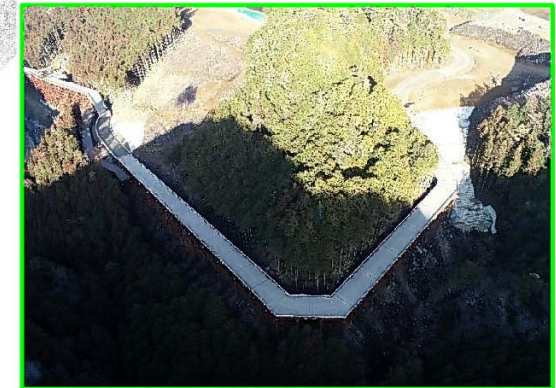
⑤ 廃棄岩骨材運搬路整備
