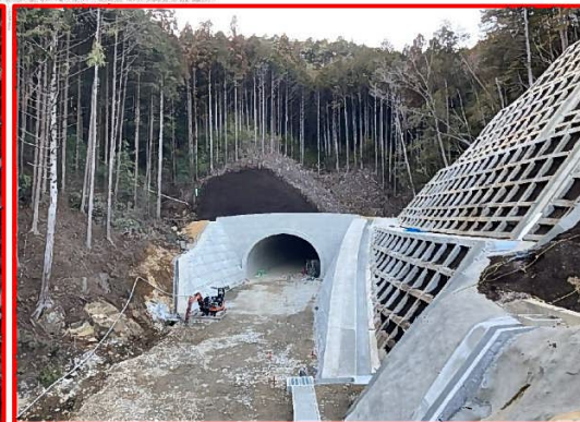
⑥5号トンネル (終点部)
