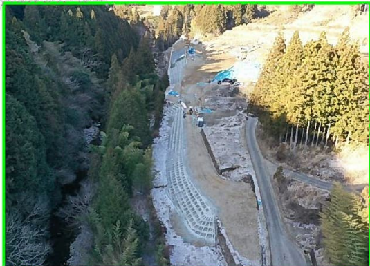
⑧仮設備工事用道路
