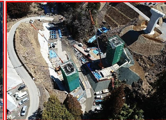
③添沢地区橋梁下部工
