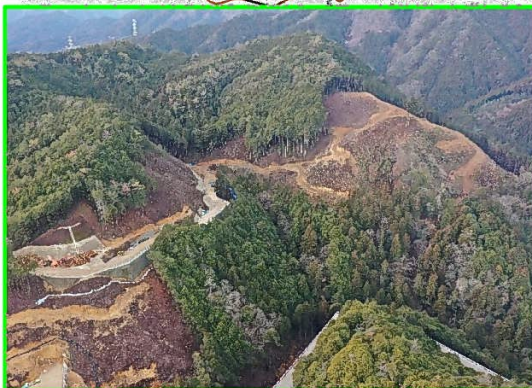
① 本体左岸掘削
