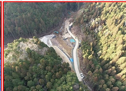
②3号橋下部工
