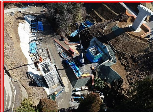
③添沢地区橋梁下部工
