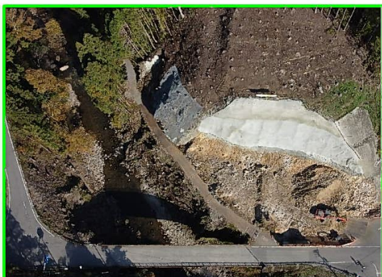
⑨工事用道路整備
