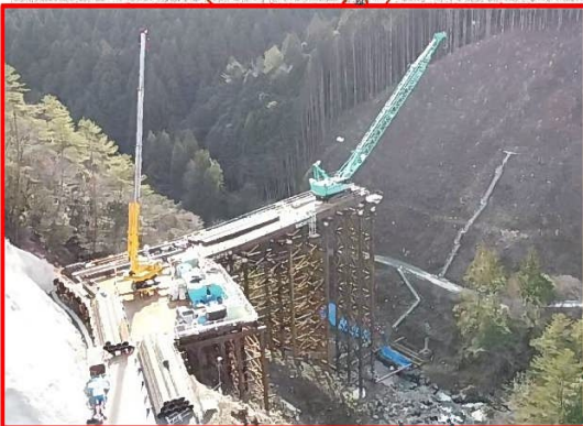
⑤松戸地区工事用進入路
