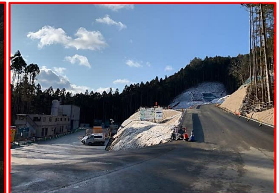
④トンネル(1号・2号)
