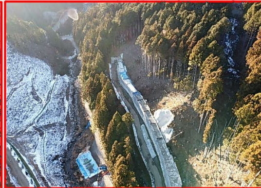
⑥ 小松地区道路建設
