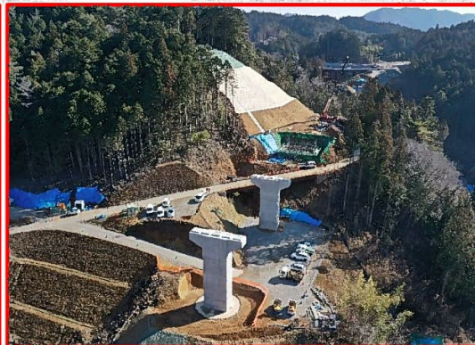
②2号橋左岸下部工
