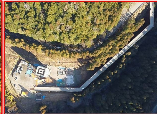
⑦ 4号橋左岸下部工
