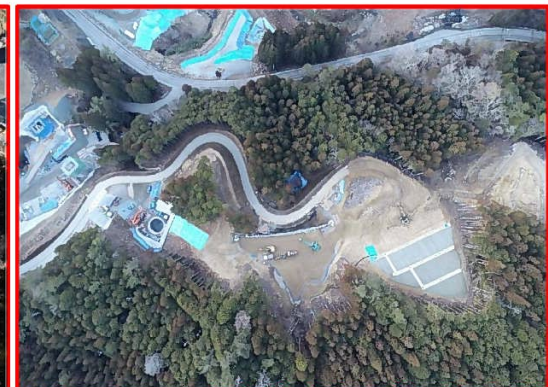
④2号橋右岸下部工
