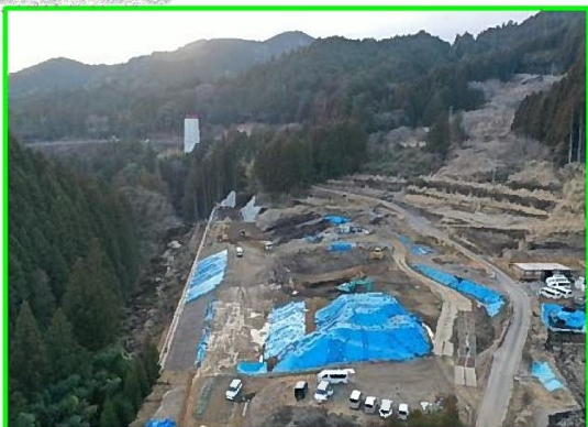
⑧仮設備工事用道路
