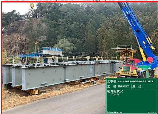
①瀬戸設楽線1号橋上部工
