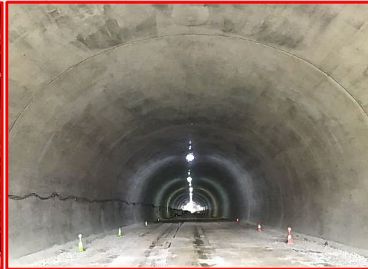
⑦5号トンネル(終点部)
