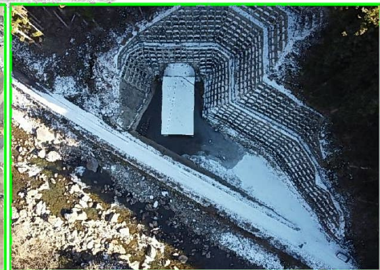
③ 堤外仮排水路工事
