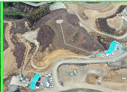
② 山村交流拠点 (建設発生土受入地整備)
