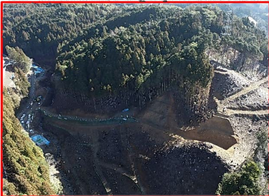
⑤ 奴田工区道路建設
