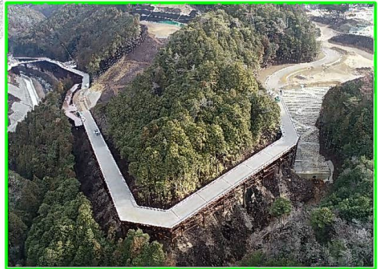
⑤ 廃棄岩骨材運搬路整備
