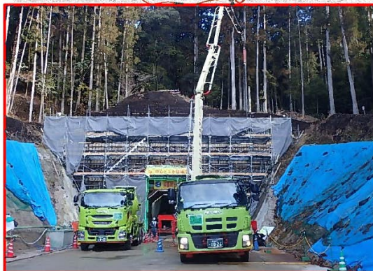
①1号トンネル
