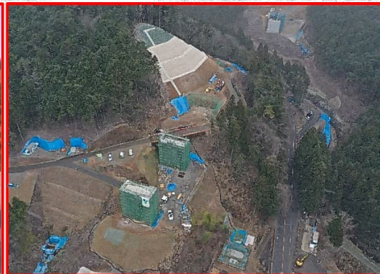
②2号橋左岸下部工
