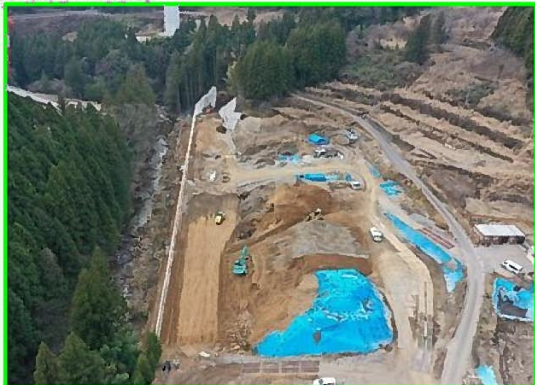
⑧仮設備工事用道路
