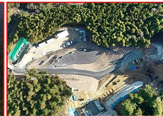
④トンネル(1号・2号)
