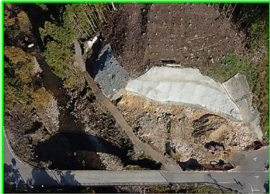
⑨工事用道路整備
