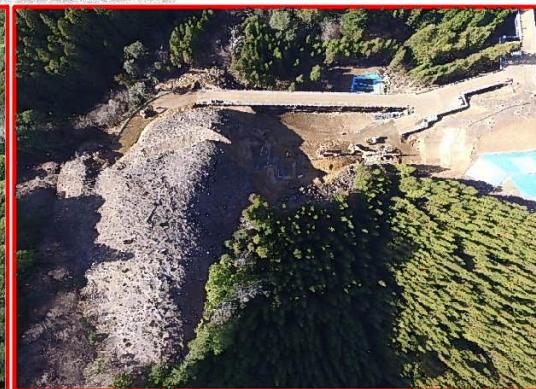
③4号橋下部工
