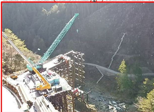
⑤松戸地区工事用進入路
