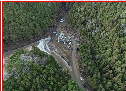
②3号橋下部工
