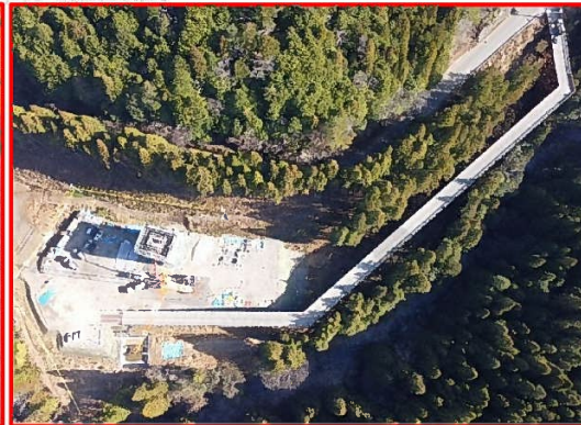
⑦4号橋左岸下部工
