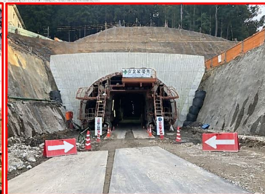
⑦ 5号トンネル (終点部)
