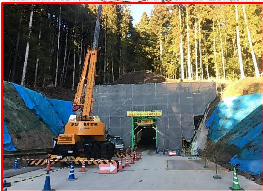
①1号トンネル
