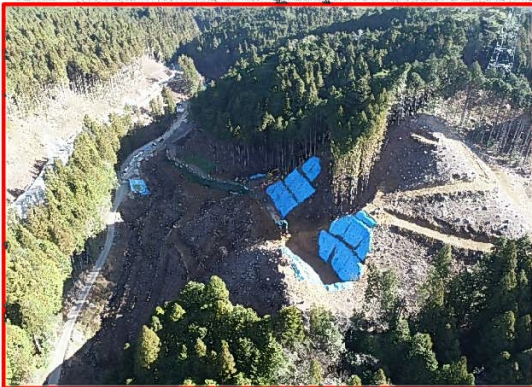
⑤奴田工区道路建設
