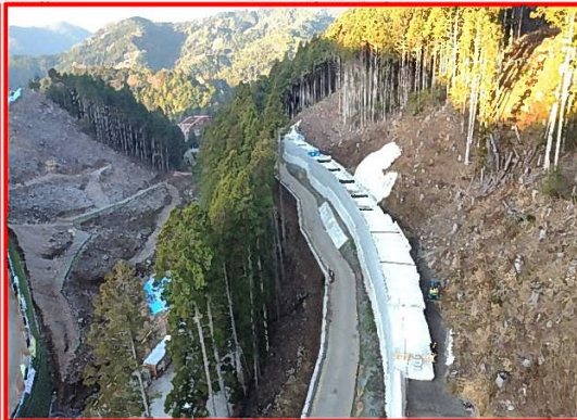
⑥小松地区道路建設
