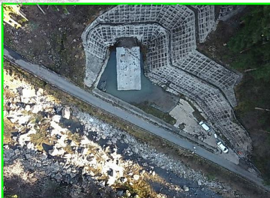
③ 堤外仮排水路工事
