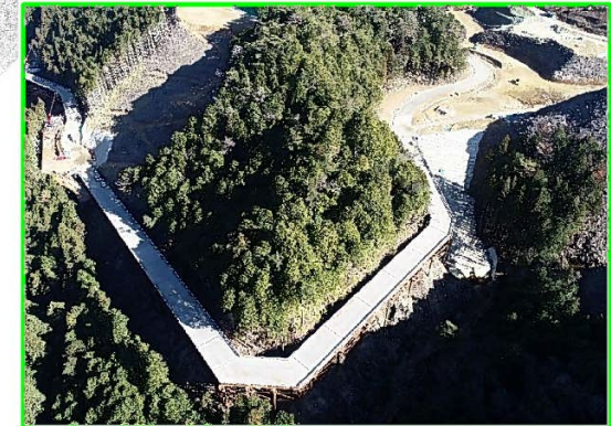
⑤ 廃棄岩骨材運搬路整備
