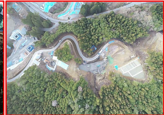
④2号橋右岸下部工
