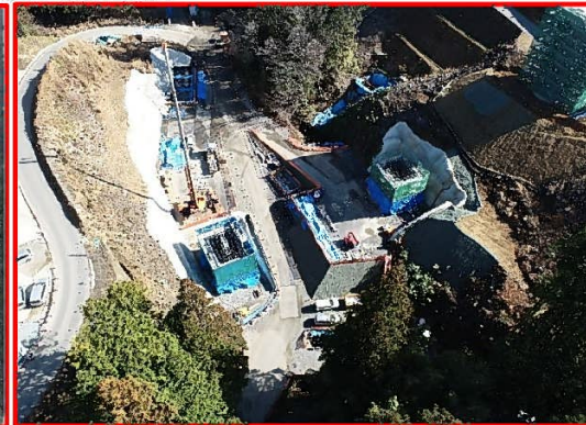
③添沢地区橋梁下部工
