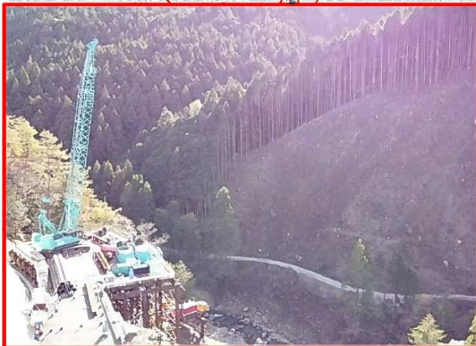
⑤松戸地区工事用進入路
