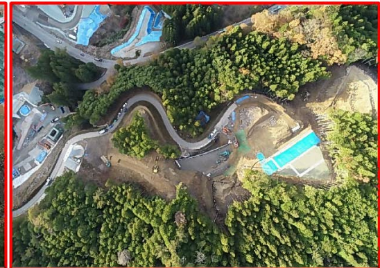
④2号橋右岸下部工
