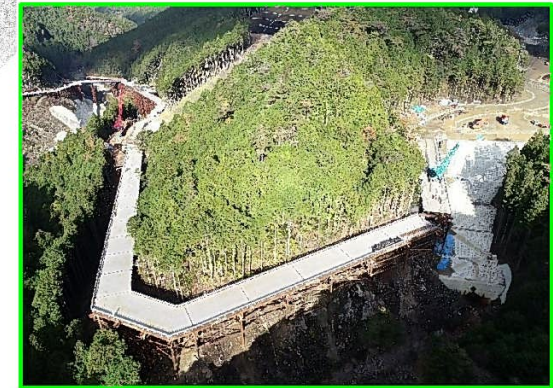
⑤ 廃棄岩骨材運搬路整備
