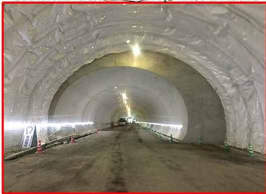
①1号トンネル
