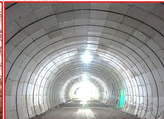
⑦ 5号トンネル (終点部)
