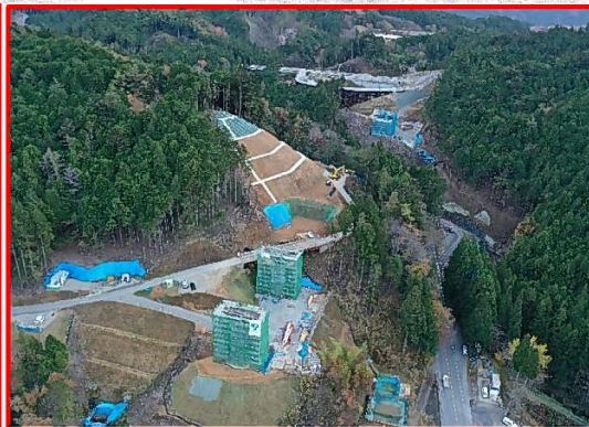
②2号橋左岸下部工
