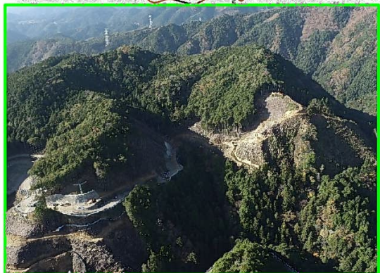
① 本体左岸掘削
