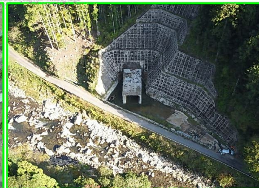
③ 堤外仮排水路工事
