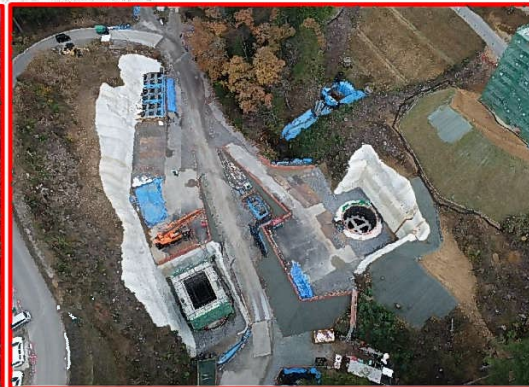
③添沢地区橋梁下部工
