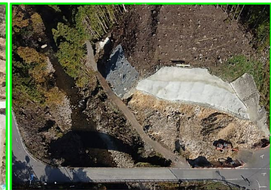
⑨工事用道路整備
