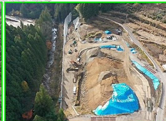
⑧仮設備工事用道路
