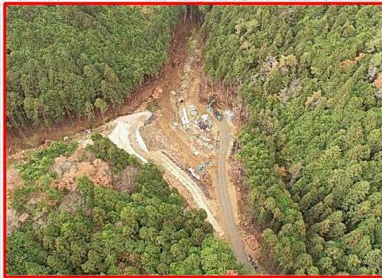
②3号橋下部工
