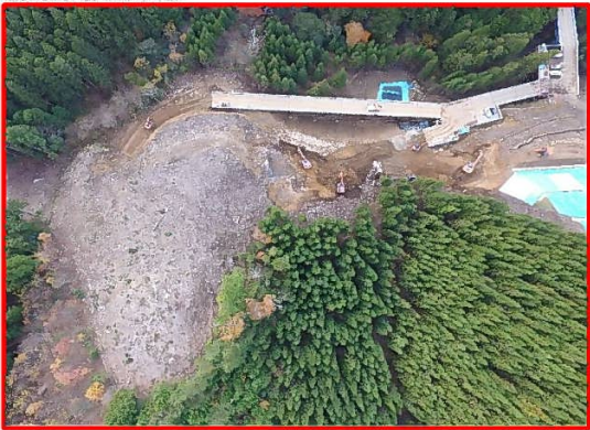
③4号橋下部工
