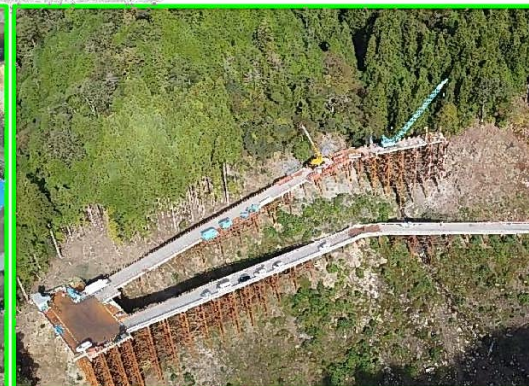
③右岸工事用道路
