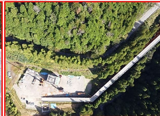
⑦ 4号橋左岸下部工
