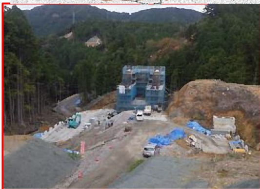
①田口地区橋梁下部工
