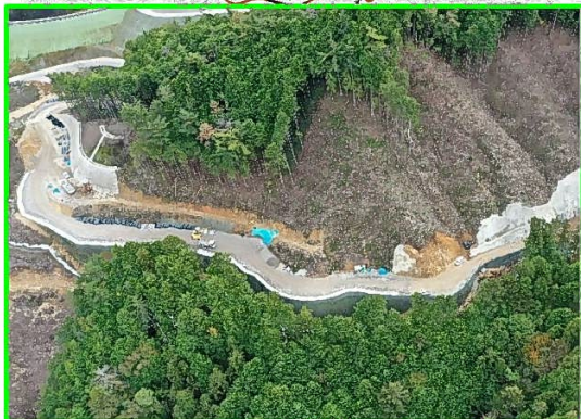
①本体左岸掘削
