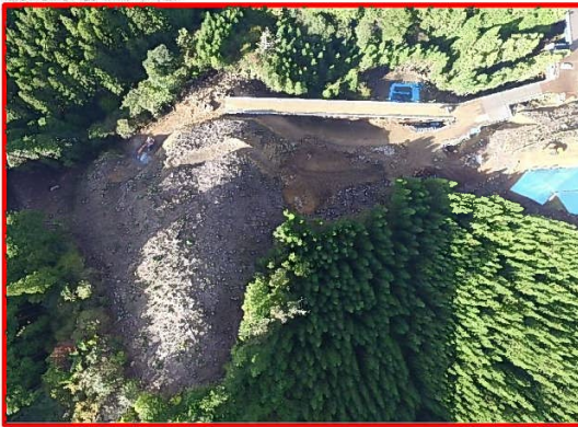
③4号橋下部工
