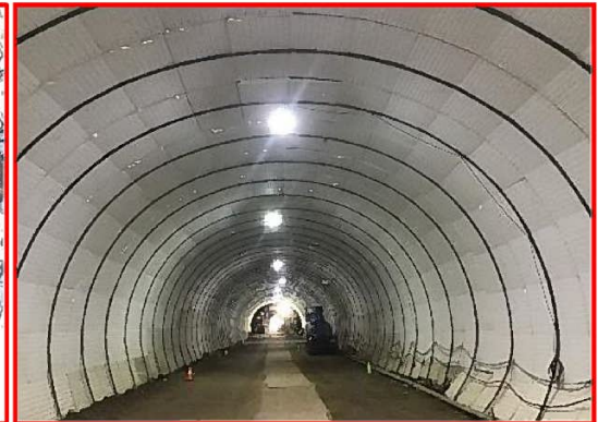
⑧5号トンネル (終点部)
