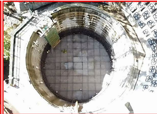
⑦5号橋下部工 (右岸)
