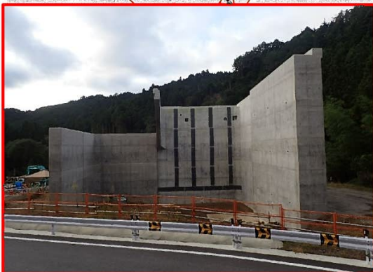
①大名倉工区橋梁下部工
