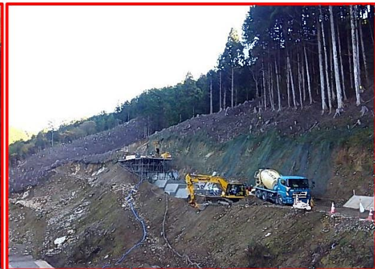
④大名倉地区工事用道路
