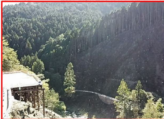
⑥松戸地区工事用進入路
