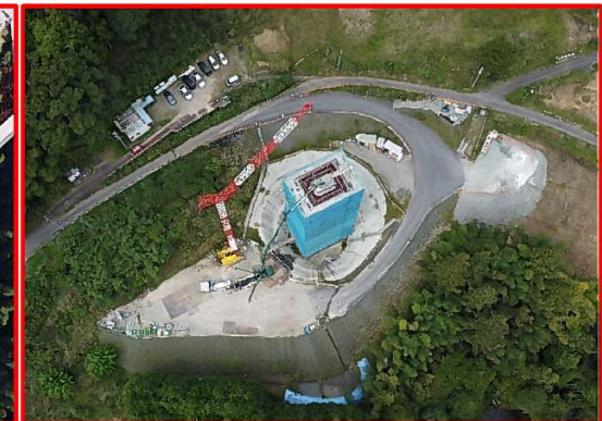
⑧ 4号橋右岸下部工
