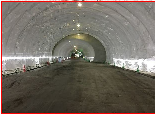
①1号トンネル
