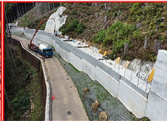
③ 小松地区道路建設
