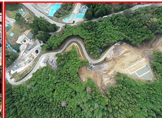
④2号橋右岸下部工
