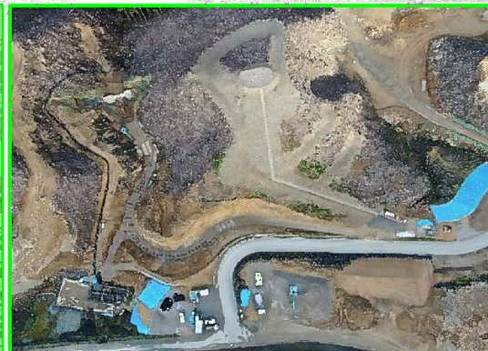
②山村交流拠点（建設発生土受入地整備）
