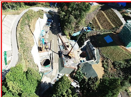
③添沢地区橋梁下部工
