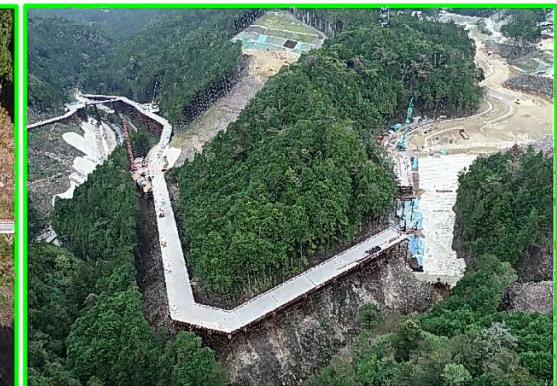
④廃棄岩骨材運搬路整備
