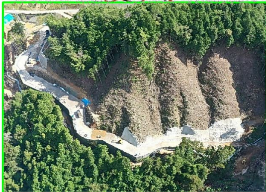
⑥本体左岸掘削
