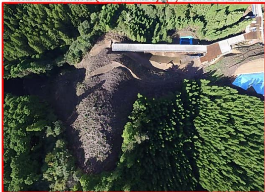
①4号橋下部工
