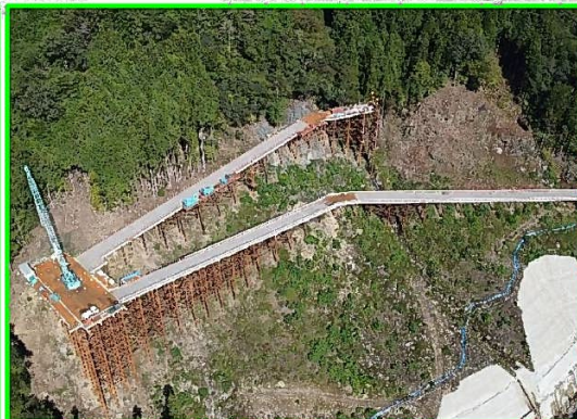
⑦右岸工事用道路
