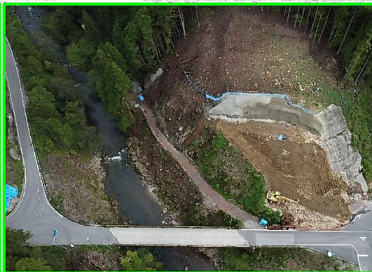
②工事用道路整備
