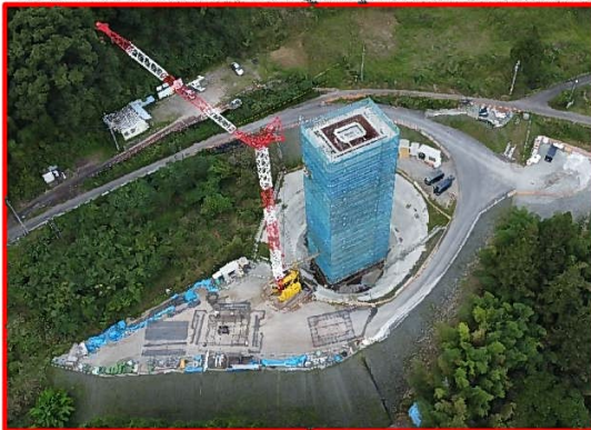
①4号橋右岸下部工
