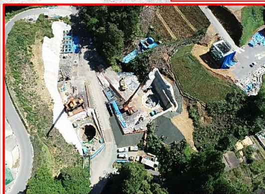
⑥添沢地区橋梁下部工
