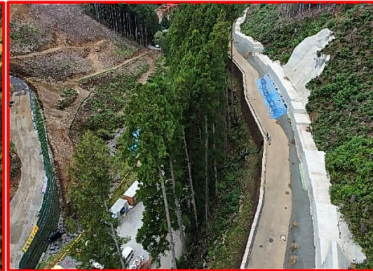
③笹平奴田小松道路建設
