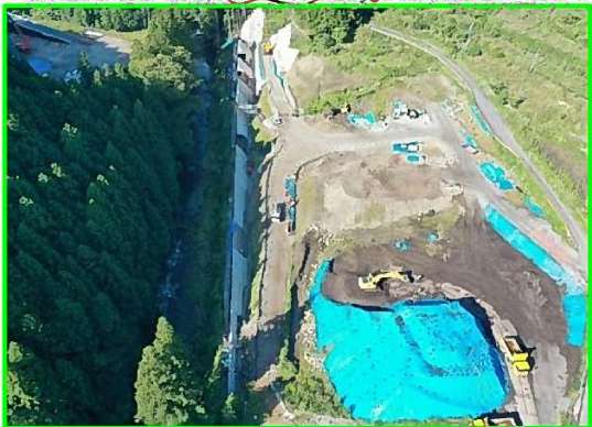
①仮設備工事用道路
