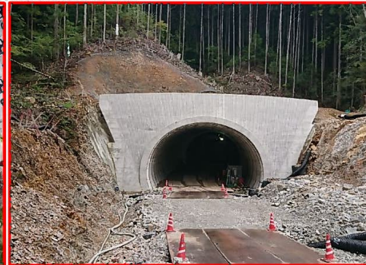
⑦5号トンネル(終点部)
