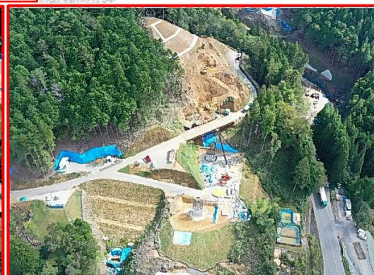
⑦2号橋左岸下部工
