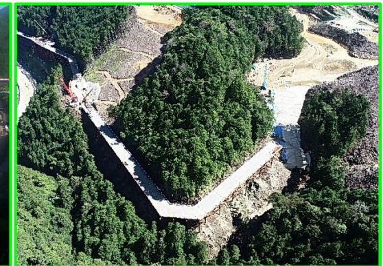
④廃棄岩骨材運搬路整備
