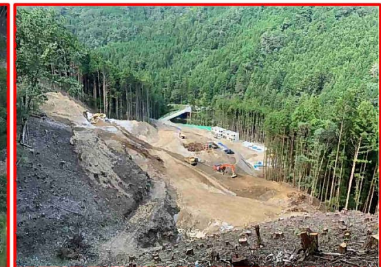
④トンネル(1号・2号)
