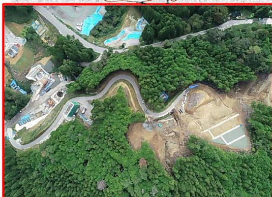
⑤2号橋右岸下部工
