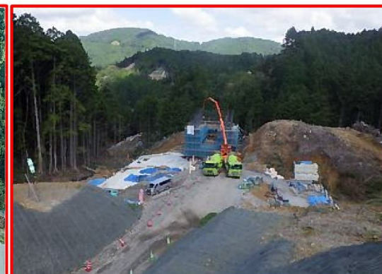
⑧田口地区橋梁下部工
