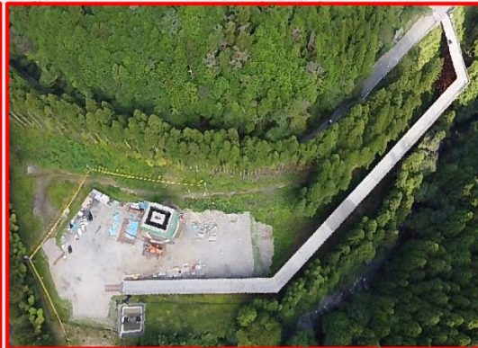
②4号橋左岸下部工
