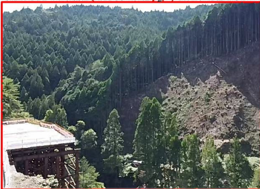
⑤松戸地区工事用進入路
