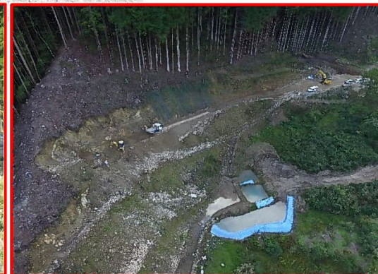
③大名倉地区工事用道路
