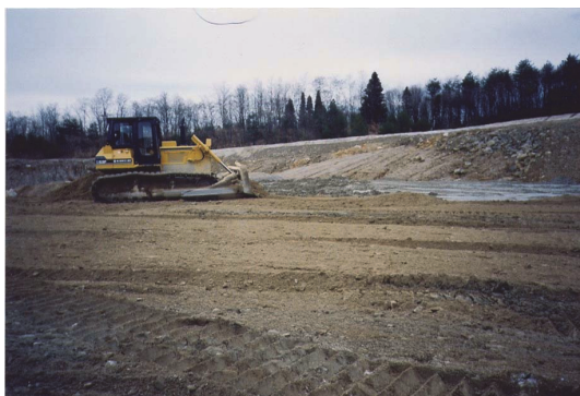
[建設発生土の処理工事のイメージ]
