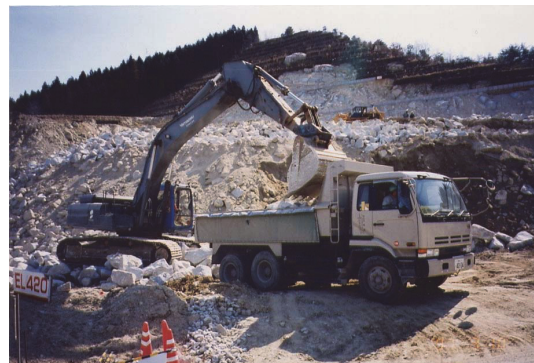
[原石の採取工事のイメージ]
