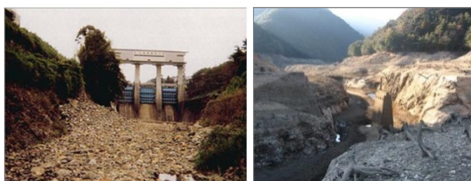
川底が露出する大野頭首工
