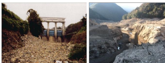
川底が露出する大野頭首工
