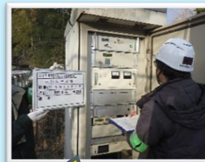
保守点検の様子
