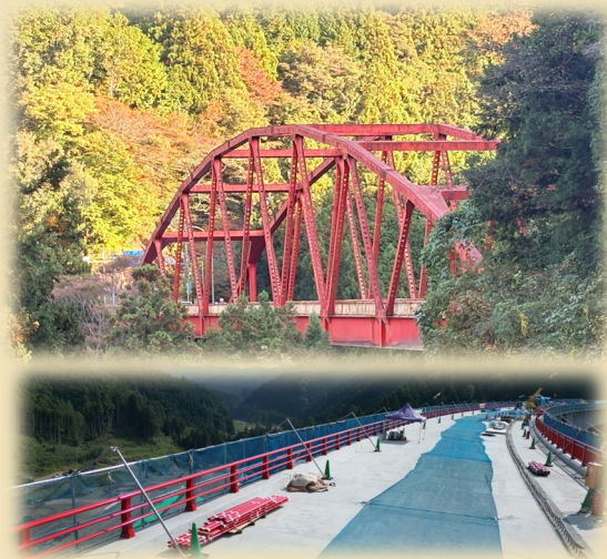
設楽大橋(上)と新設楽大橋(下)
