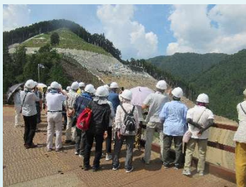
ダム本体工事の現場
