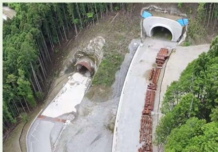
受賞したトンネルの上空写真
